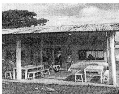
Ilustración 17. Área de comedor existente - Canalete
