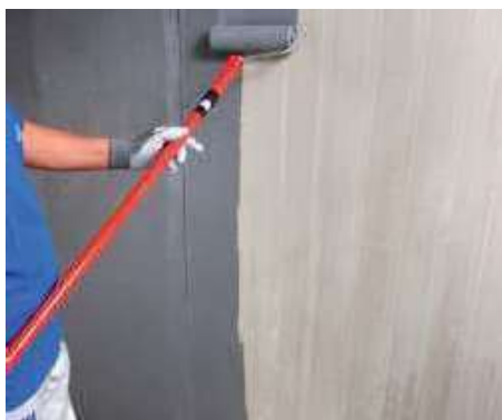
Aplicación de Eco Prim Grip Plus a rodillo sobre soporte de hormigón
