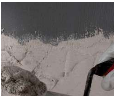
Aplicación de enlucido sobre Eco Prim Grip Plus
