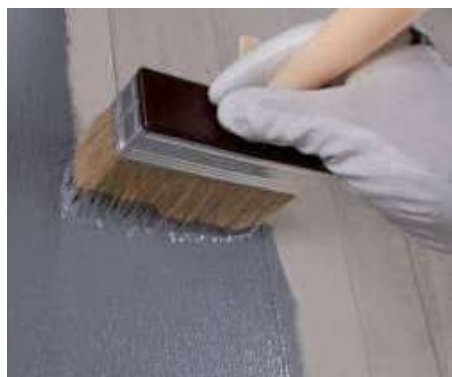
Aplicación de Eco Prim Grip Plus con brocha sobre soporte de hormigón
