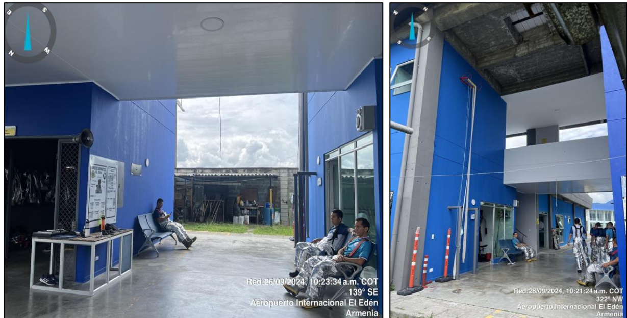
Registro Fotográfico: Estado actual del área destinada al gimnasio, objeto de ampliación y adecuación funcional. Fuente: Propia
