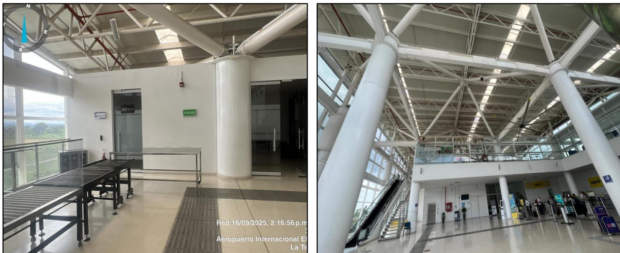
Registro Fotográfico: Estructura metálica Terminal Internacional Fuente: Propia
