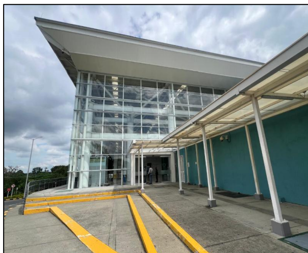
Registro Fotográfico: Cubierta y canales Terminal Internacional / Fachada Terminal Internacional en Vidrio Laminado PVB. Fuente: Propia
