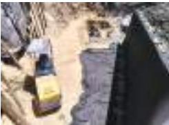
CONSTRUCCION DE FILTROS A CUALQUIER PROFUNDIDAD
