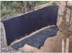
CONSTRUCCION DE FILTROS A CUALQUIER PROFUNDIDAD
