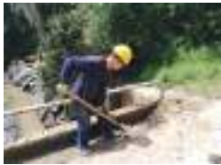
LIMPIEZA DE PONTONES Y BOX COULVERT
