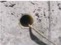
SUMINISTRO E INSTALACIÓN DE TUBERÍA PVC
