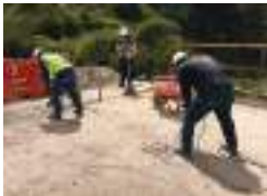
DEMOLICIÓN OBRAS EN CONCRETO REFORZADO
