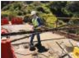
SUMINISTRO E INSTALACIÓN DE JUNTAS DE DILATACIÓN
