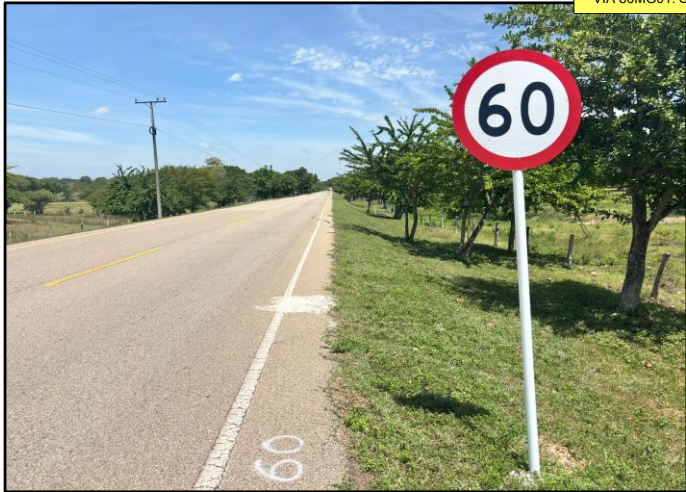
EL SECTOR DEL ACCIDENTE CUENTA CON DEMARCACIÓN HORIZONTAL EN TODA SU LONGITUD EN EL EJE DE LA CALZADA CON LÍNEAS DISCONTINUAS EN SENTIDO SANTANA HACIA LA GLORIA SIGNIFICATIVA QUE SE PUEDE ADELANTAR CON MUCHA PRECAUCIÓN Y LÍNEAS CONTINUAS EN SENTIDO LA GLORIA HACIA SANTANA EN BUEN ESTADO.
