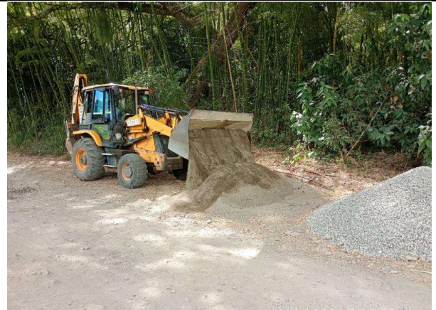
Fotografía 4. Suministro de materiales pétreos para la construcción del cárcamo
