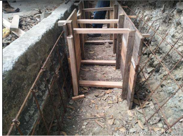
Fotografía 3. Fabricación de encofrado para construcción de cárcamo en tramo 1 – Sector Batea bananos.
