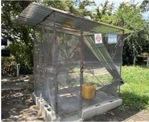
Foto 5. Almacenamiento de combustible – PTAP Guacará
