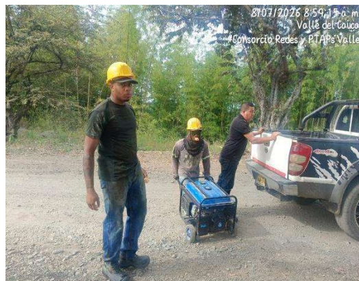
Foto 8. Inspección de actividades
