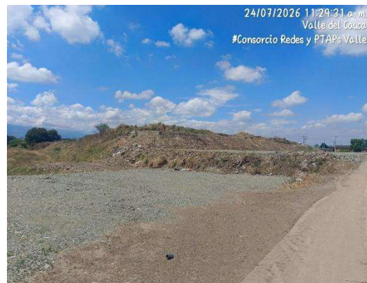
Foto 18. Visita de Inspección escombrera SERVI TRANSPORTES LÓPEZ Y RECUPERACIÓN AMBIENTAL S.A.S.
