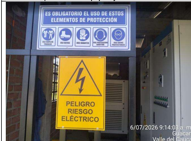
Revisión señalización parte eléctrica
