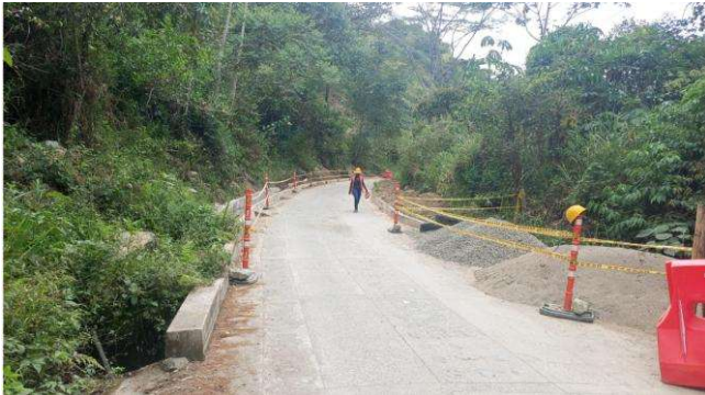
Señalización tramo 1 sector regaderas.
