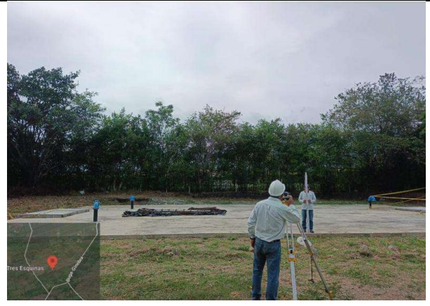
Fotografía 2. Toma de información para chequeo de asentamientos y evaluar el comportamiento de los rellenos.
