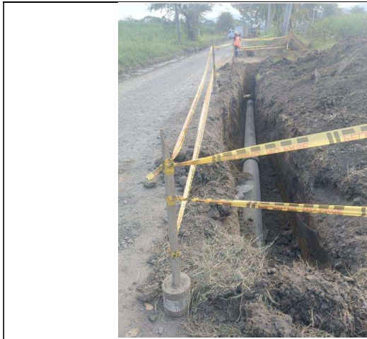
Señalización de excavaciones
