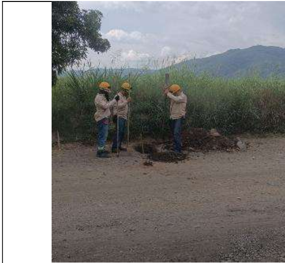
Recorridos en frente de obra, inspección de equipos y correcto uso de los elementos de protección personal.
