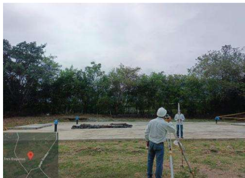
Ilustración 2. Seguimiento al asentamiento del tanque Albania.
