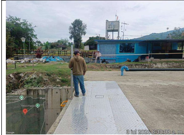
Fotografía 1. Toma de información para chequeo de asentamientos
