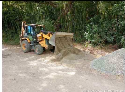
Área de acopio materiales pétreos en sitios de trabajo
