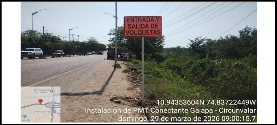
SEÑALIZACION VERTICAL PMT-CORDIALIDAD
