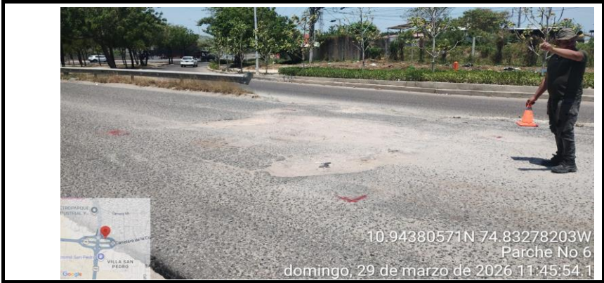
MARCACION DE BACHES -CONECTANTE GALAPA
