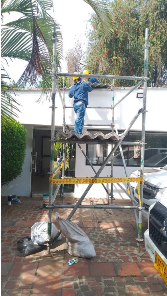
Figura 18. Delimitación y señalización preventiva del frente de trabajo.
