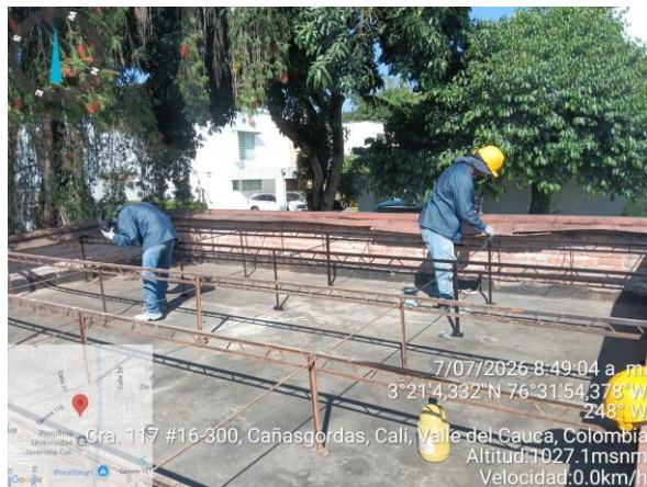
Figura 31. Actividad sobre cubierta - 07/07/2026, 08:49 a. m.
