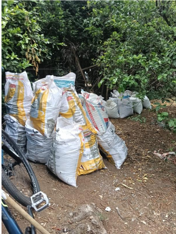
Figura 22. Acopio y ensacado de RCD generado en los frentes.
