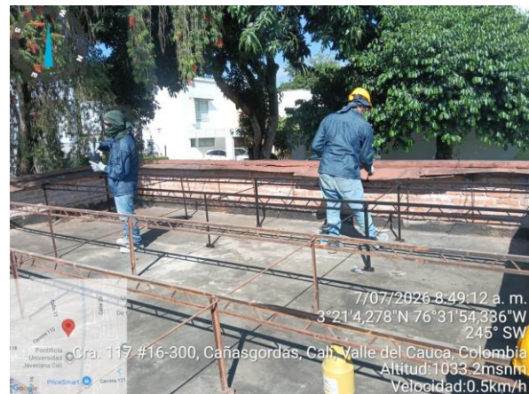
Figura 32. Continuidad del frente de cubierta - 07/07/2026, 08:49 a. m.
