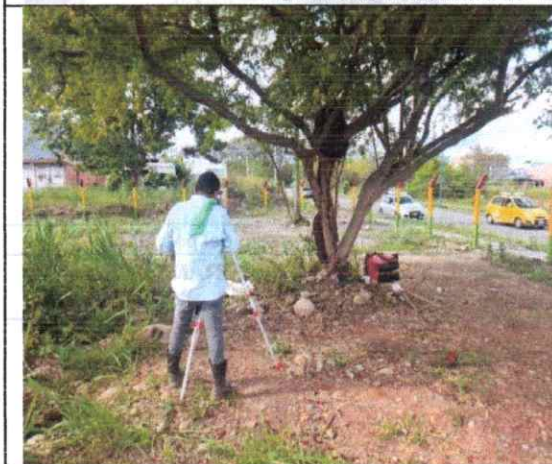
Img. 7. Realización de medidas con equipos topográficos.
