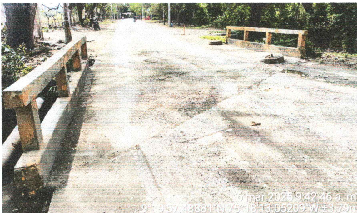
Ilustración 3. estructura existente Fuente: Elaboración propia.
