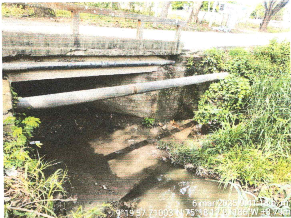
Fotografía 1. Zona de entrada de la obra.
