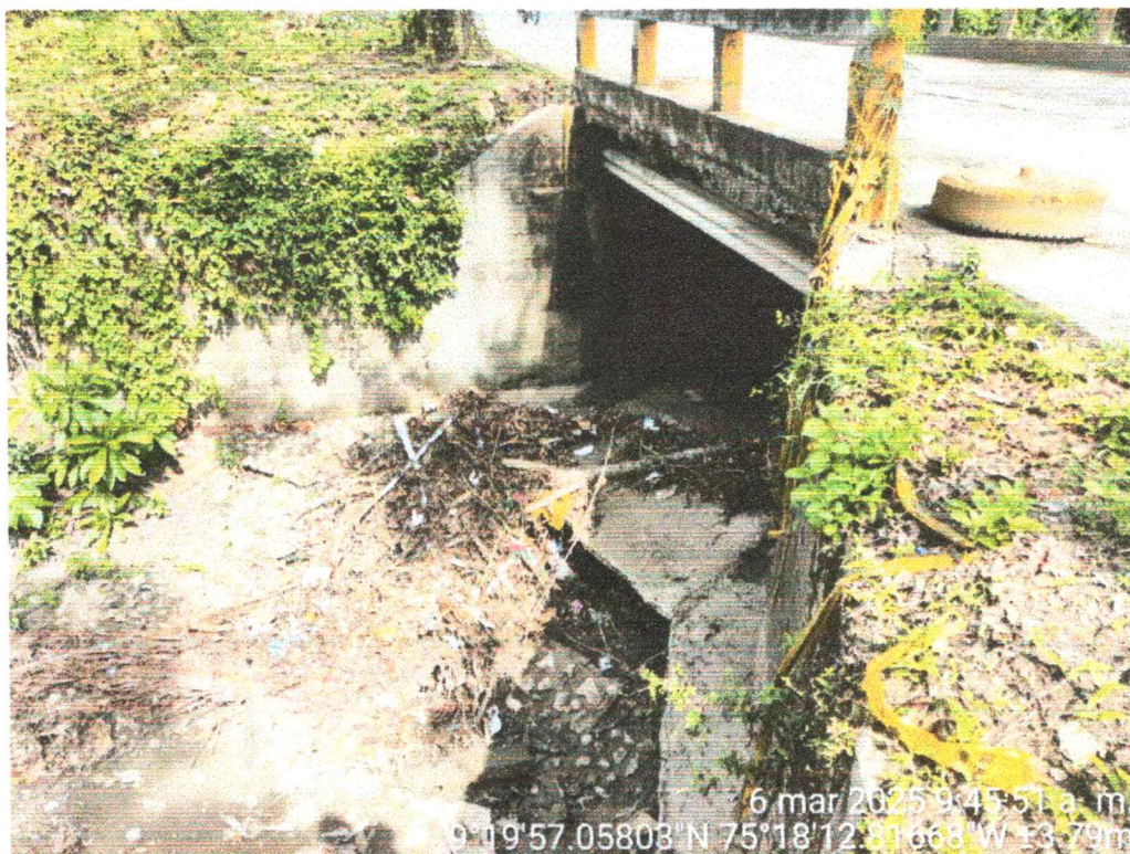
Fotografía 5. Zona de salida de la obra.
