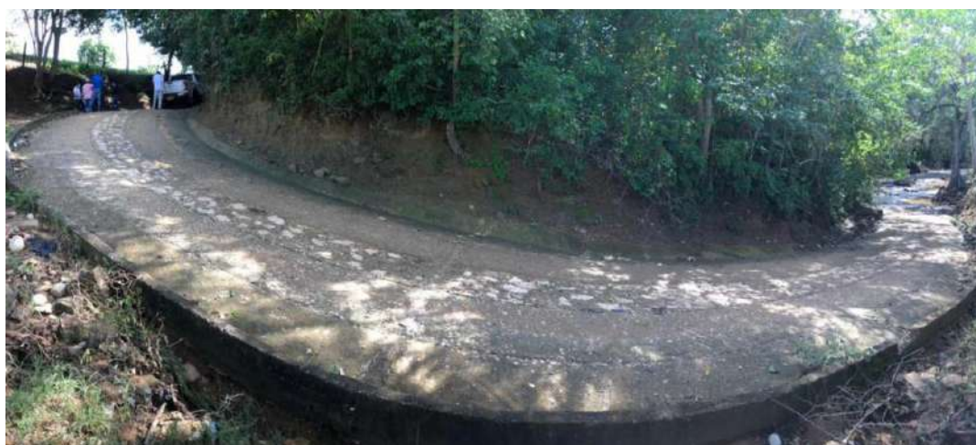
FOTOGRAFIAS. Tramo 4 Placas Huella en buen estado.
