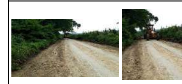
Fotografía N° 3. Perfilación
