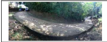
Fotografía N° 1 Tramo 4 - Placa Huella Existente
