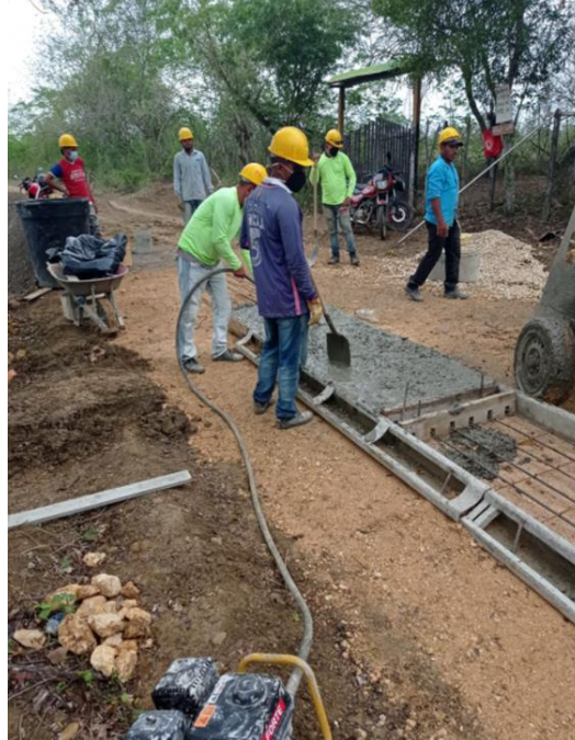
1. Foto: fundición de losas en concreto de 3000 psi en el tramo 3 de la vía.
