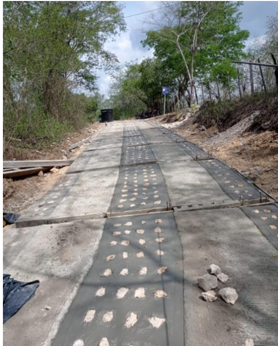
7. Foto: Trabajos de suministro de concreto ciclópeo, Tramo N°3.
