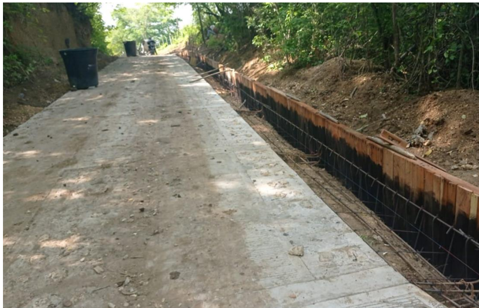
10. Instalación acero de refuerzo para cunetas y bordillos tramo 3
