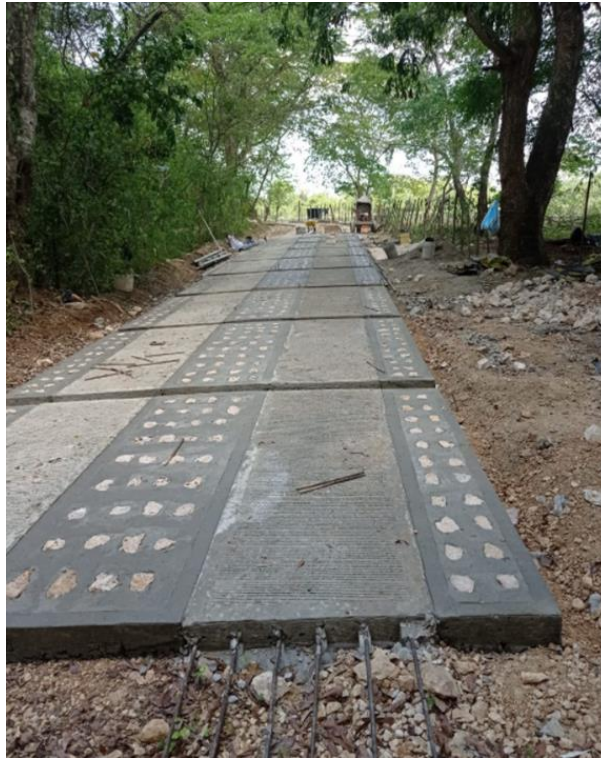
9. Foto: Trabajos de suministro de concreto ciclópeo, Tramo N°3.
