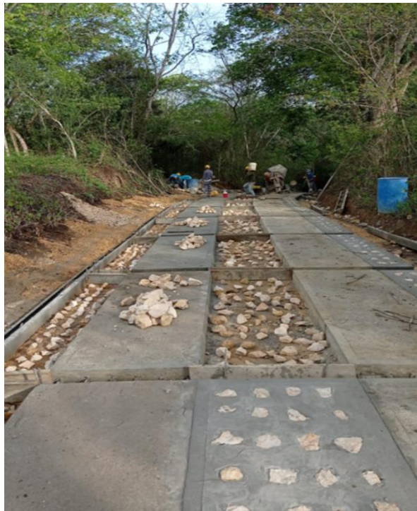
8. Foto: Trabajos de suministro de concreto ciclópeo, Tramo N°3.
