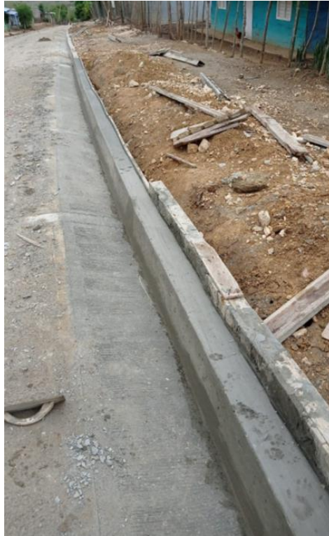
3. Foto: fundición de concreto para bordillos y cunetas en el tramo N° 4.
