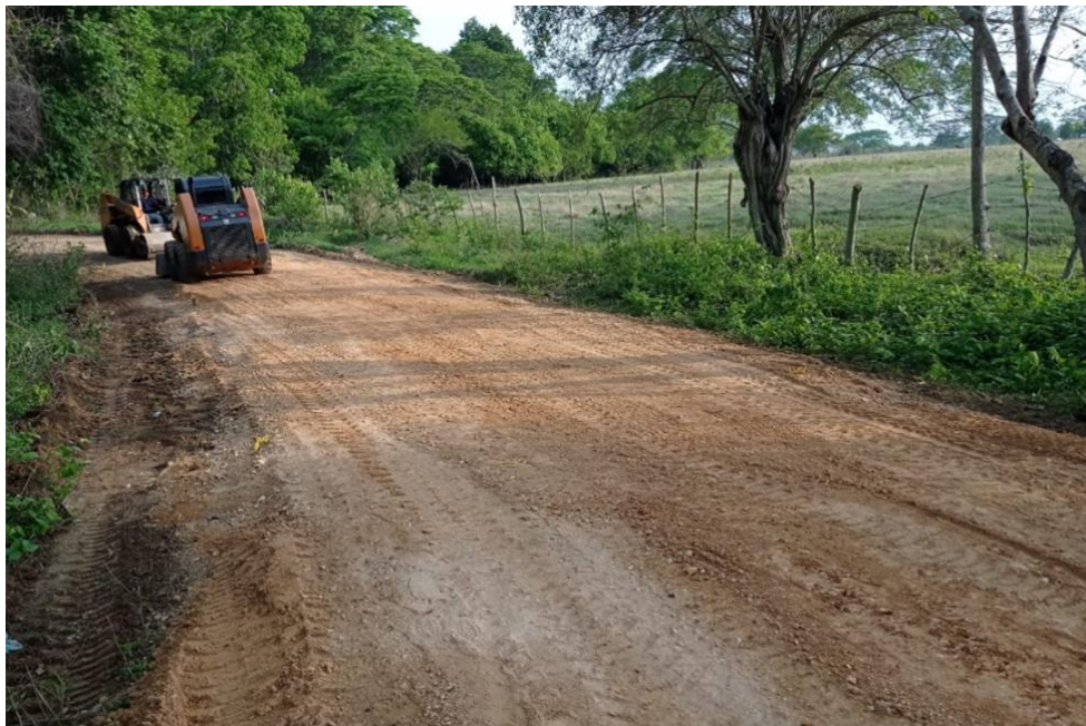
12. : Actividades preliminares en el tramo 2, preparación de la vía para instalación de subbase granular tipo C.
