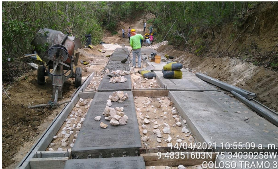
5. Foto: Suministro de concreto ciclópeo en el tramo 3 de la vía
