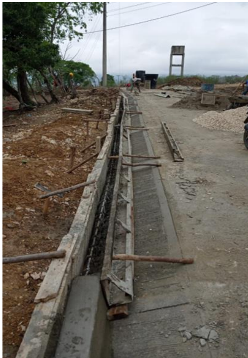
2. Foto: Instalación de acero refuerzo y encofrado para bordillo en el tramo 4 de la vía
