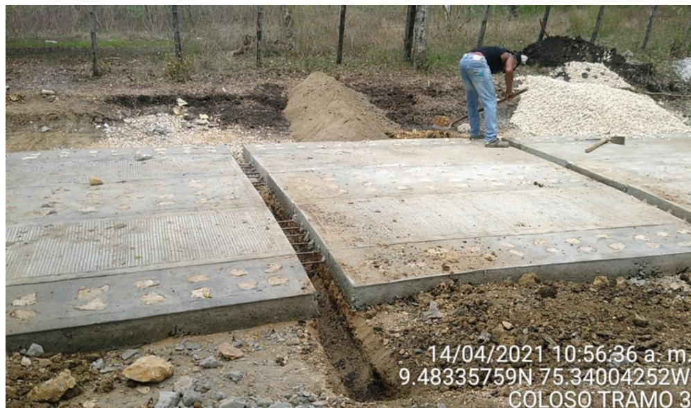
6. Foto: Excavaciones varias sin clasificar para vigas riostras en el tramo 3 de la vía.
