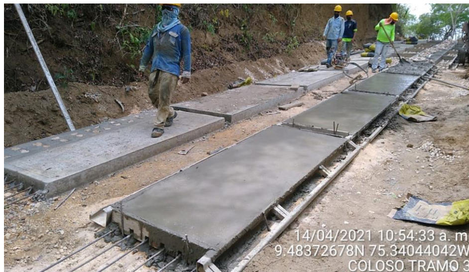
4. Foto: Ejecución de fundición de concreto de refuerzo 21 MPA, para placa huella en el tramo 3
