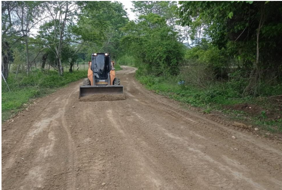
11. Foto: Actividades preliminares en el tramo 2, preparación de la vía para instalación de subbase granular tipo C.
