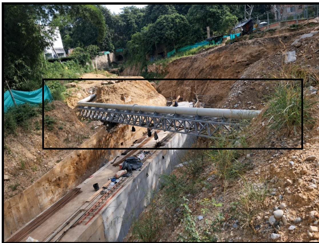
Registro Fotográfico No.4 Estructura y Red Acueducto Metropolitano Ø= 20"
