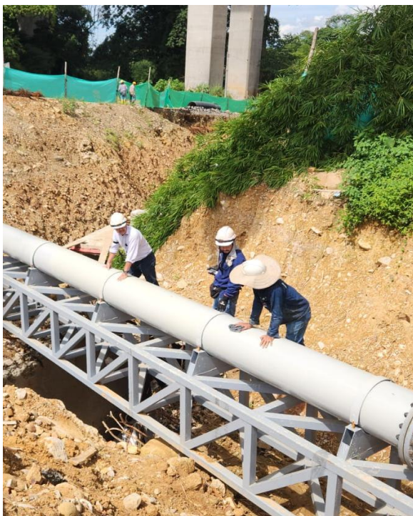
Registro Fotográfico No.9 Red Nueva de Acueducto
