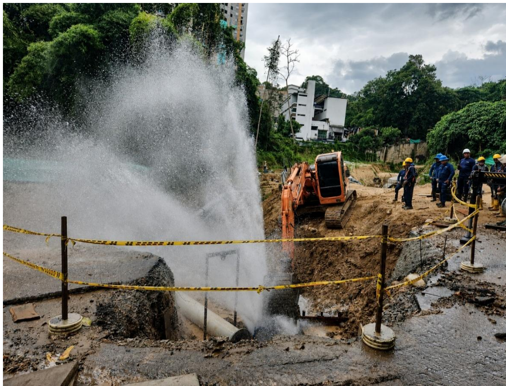
Registro Fotográfico No.5 Red Acueducto Municipal Existente
