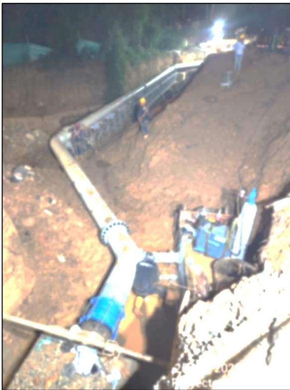
Registro Fotográfico No.7 Red Nueva de Acueducto
