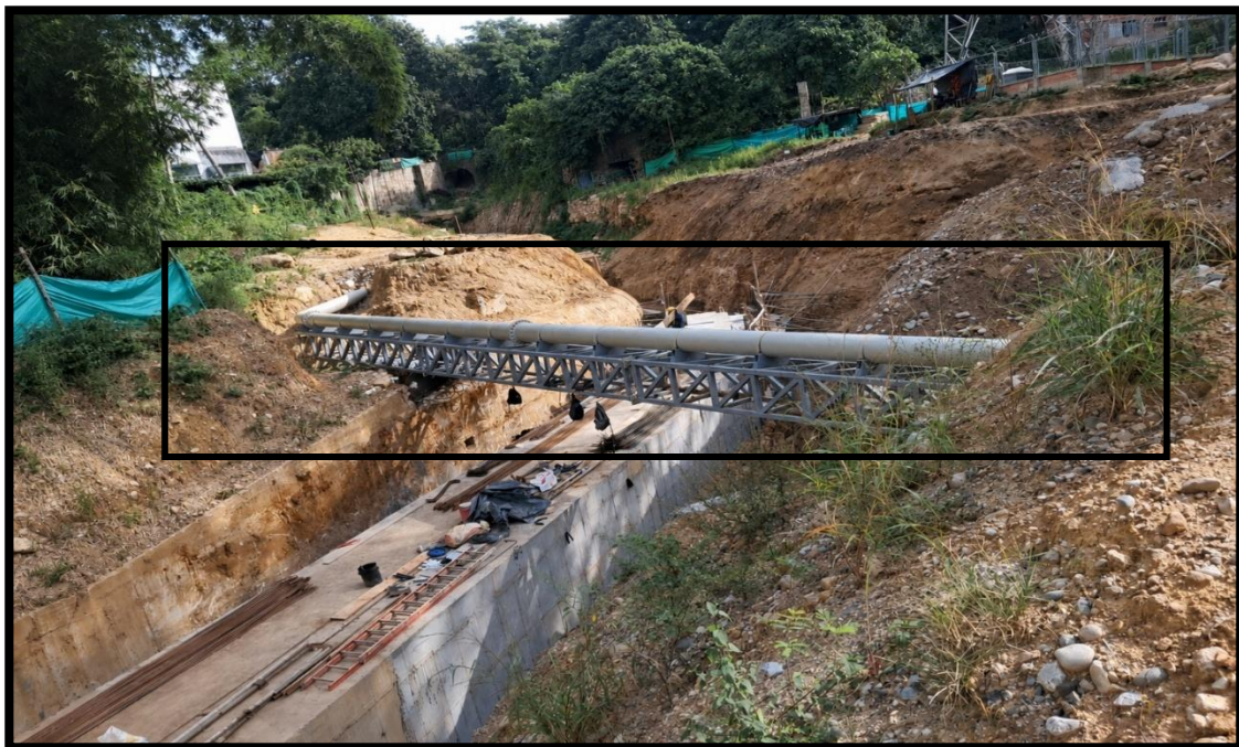
Registro Fotográfico No.6 Estructura y Red Acueducto Municipal \varnothing = 20''
