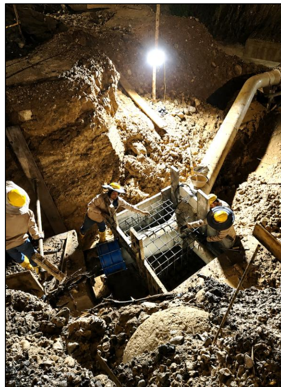
Registro Fotográfico No.8 Red Nueva de Acueducto
