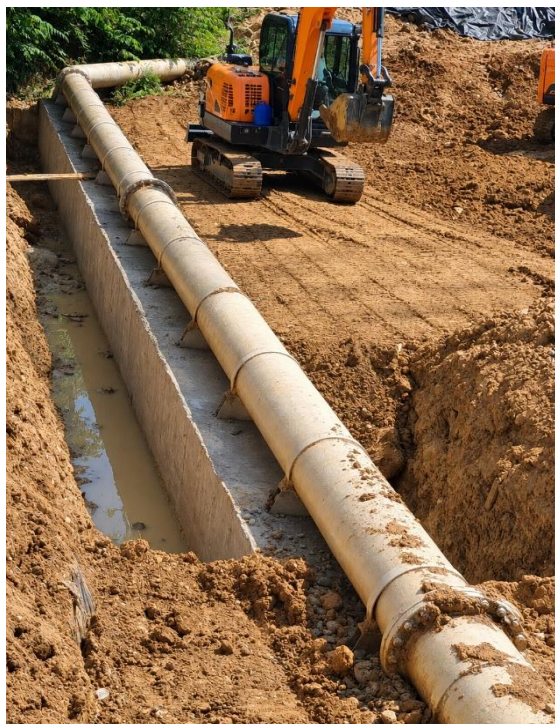
Registro Fotográfico No.10 Red Nueva de Acueducto
