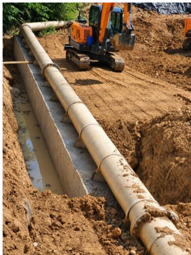
Registro Fotográfico No.8 Red Nueva de Acueducto
