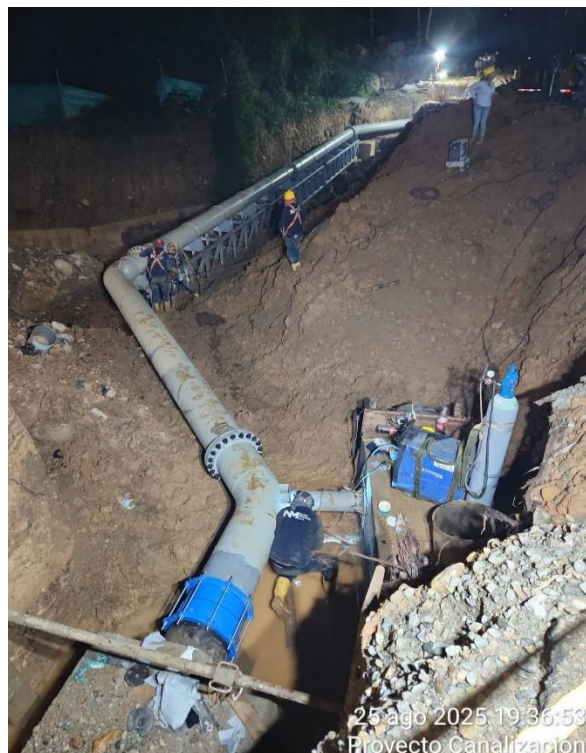
Registro Fotográfico No.5 Red Nueva de Acueducto
