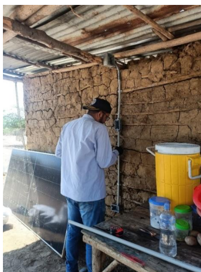
Ilustración 9. Instalación de internas.
