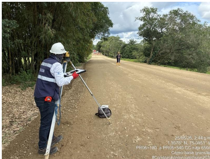
Fotografía 173. PR06+180 Ruta 6504, Verificación de niveles base granular – Estructura de vía
