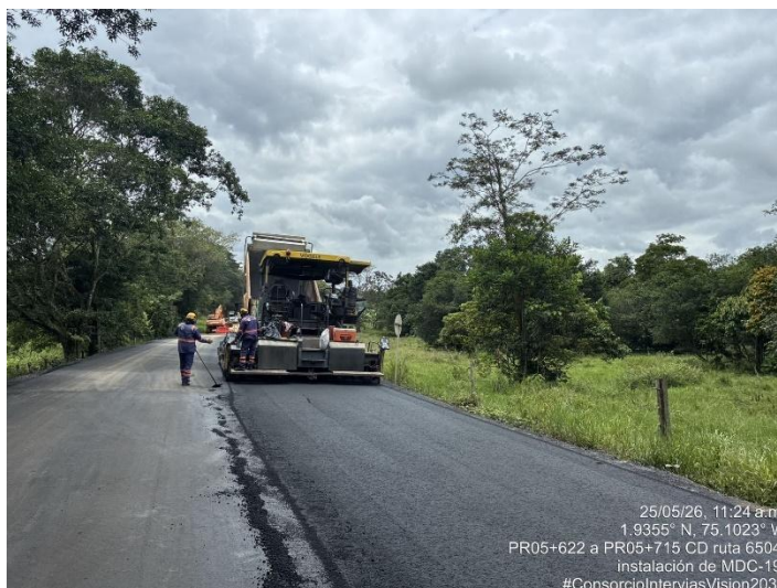
Fotografía 180. PR05+622 Ruta 6504, Suministro e instalación de mezcla asfáltica MDC-19.
