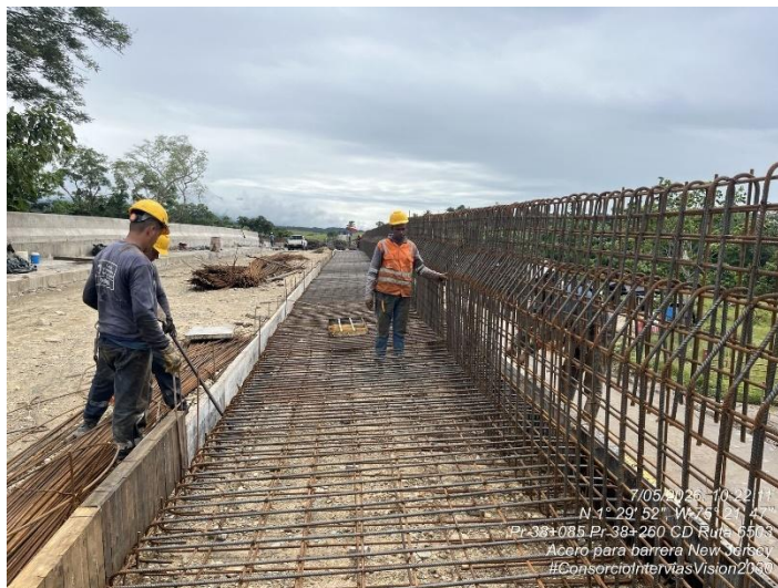
Fotografía 214. PR38+170 Ruta 6503, Armado acero de refuerzo New Jersey – Accesos puente quebrada Las Delicias.
