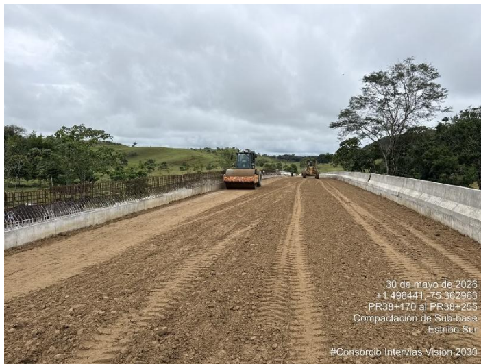
Fotografía 209. PR38+170 Ruta 6503, Instalación de suelo de relleno MSME – Accesos puente quebrada Las Delicias.
