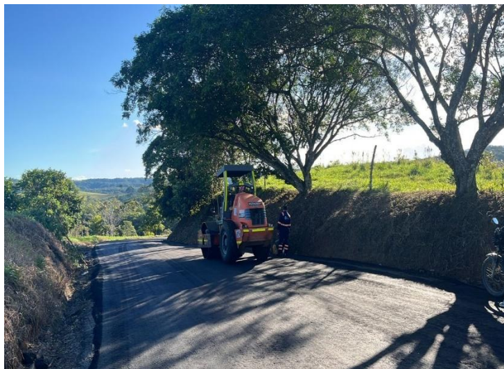
Fotografía 197. PR40+900 Ruta 6503, Instalación y compactación de MDC- 19 - Mantenimiento vial
