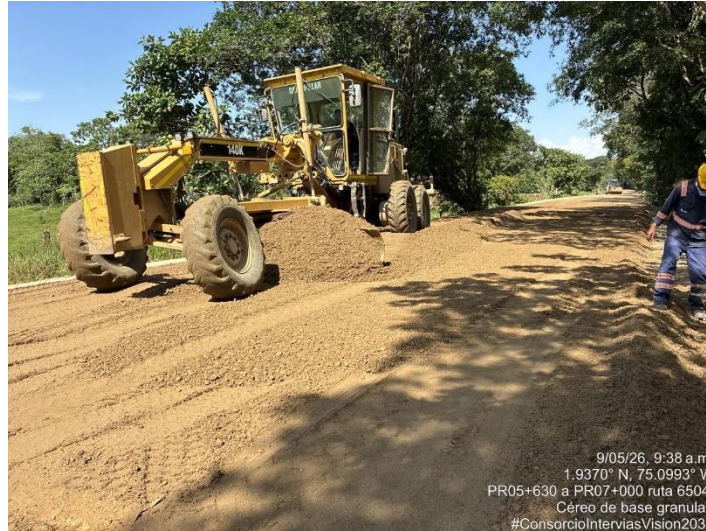
Fotografía 169. PR05+630 Ruta 6504, Suministro e instalación de base granular - Estructura de vía
