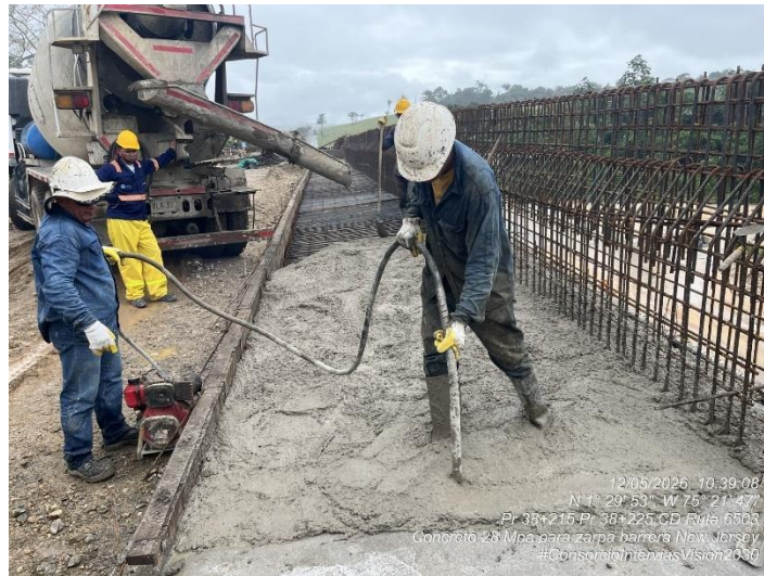
Fotografía 224. PR38+215 Ruta 6503, Suministro e instalación de concreto 28 MPa New Jersey – Accesos puente quebrada Las Delicias.
