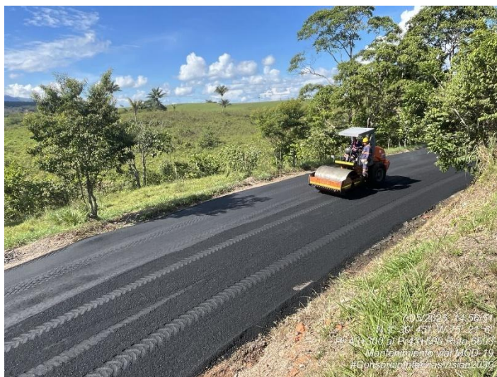
Fotografía 194. PR43+300 Ruta 6503, Instalación y compactación de MDC- 19 - Mantenimiento vial.
