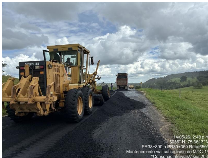
Fotografía 191. PR38+800 Ruta 6503, Instalación de MDC- 19 - Mantenimiento vial.
