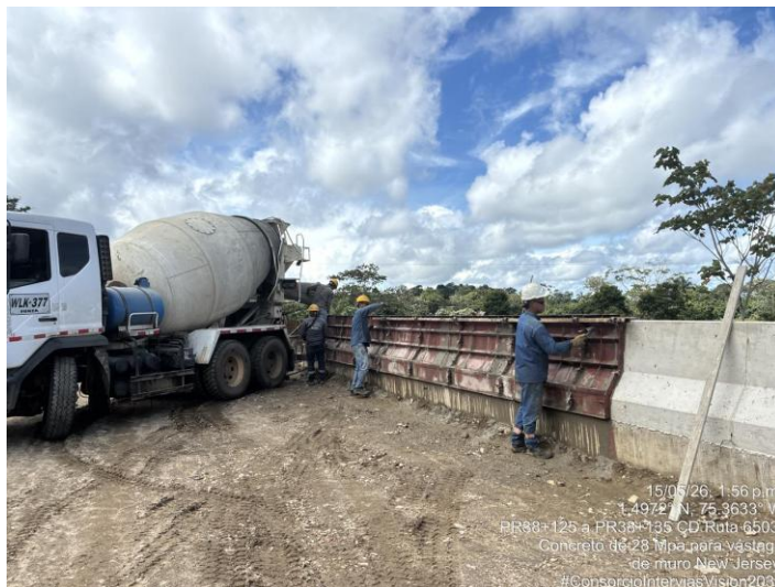
Fotografía 225. PR38+125 Ruta 6503, Suministro e instalación de concreto 28 MPa New Jersey – Accesos puente quebrada Las Delicias.
