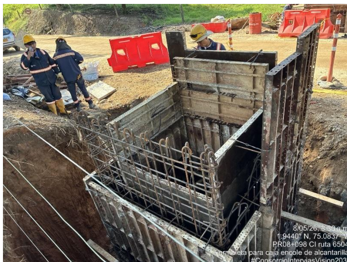
Fotografía 144. PR08+098 Ruta 6504, Encofrado caja – Alcantarilla.
