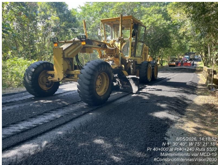
Fotografía 195. PR40+000 Ruta 6503, Instalación y compactación de MDC- 19 - Mantenimiento vial.
