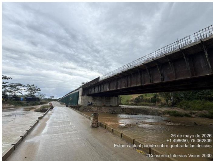
Fotografía 227. PR38+295 Ruta 6503, puente quebrada Las Delicias.
