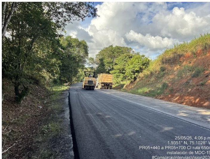
Fotografía 189. PR05+440 Ruta 6504, Compactación de mezcla asfáltica MDC-19.
