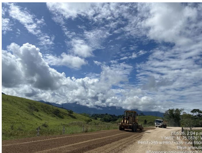
Fotografía 167. PR07+280 Ruta 6504, Suministro e instalación de base granular - Estructura de vía.
