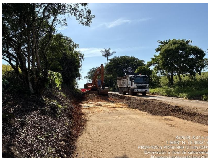
Fotografía 154. PR09+925 Ruta 6504, Excavación a nivel de subrasante.
