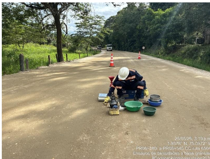
Fotografía 174. PR06+180 Ruta 6504, Ensayo de densidades base granular – Estructura de vía.
