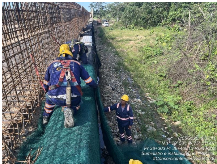
Fotografía 211. PR38+303 Ruta 6503, Instalación de manto TRM MSME – Accesos puente quebrada Las Delicias.
