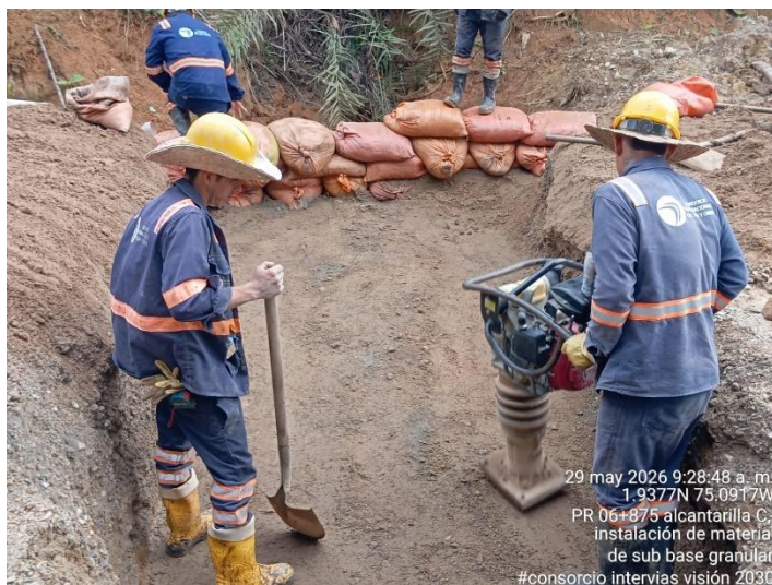
Fotografía 151. PR06+875 Ruta 6504, Lleno estructuras – Muro de contención.
