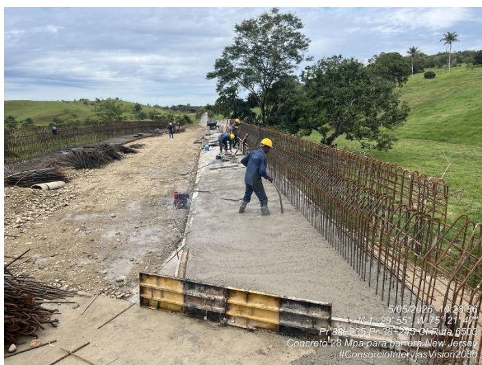
Fotografía 220. PR38+245 Ruta 6503, Suministro e instalación de concreto 28 MPa New Jersey – Accesos puente quebrada Las Delicias.
