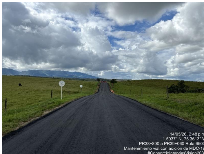
Fotografía 198. PR38+800 Ruta 6503, Instalación y compactación de MDC- 19 - Mantenimiento vial.
