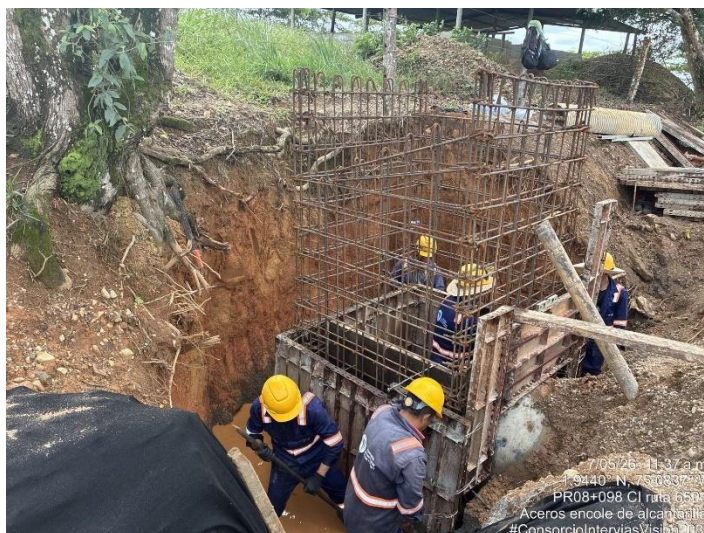
Fotografía 146. PR08+098 Ruta 6504, Encofrado caja – Alcantarilla.
