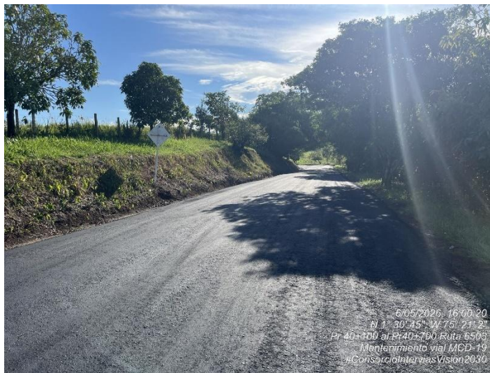
Fotografía 199. PR40+700 Ruta 6503, Instalación y compactación de MDC- 19 - Mantenimiento vial.
