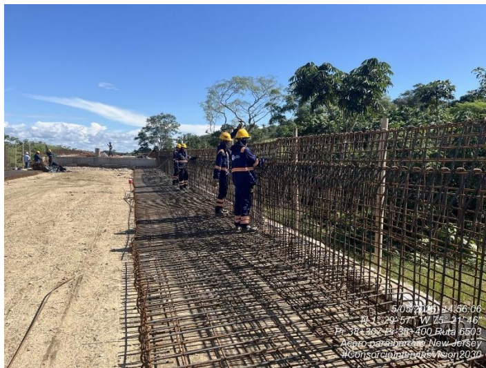
Fotografía 219. PR38+330 Ruta 6503, Armado acero de refuerzo New Jersey – Accesos puente quebrada Las Delicias
