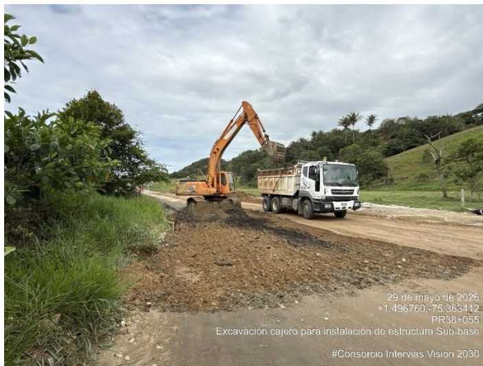
Fotografía 229. PR38+055 Ruta 6503, Excavación – Accesos puente quebrada Las Delicias.
