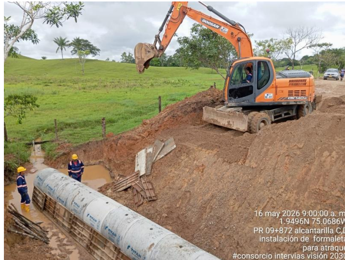
Fotografía 139. PR09+872 Ruta 6504, Suministro e instalación tubería 36" – Alcantarilla.
