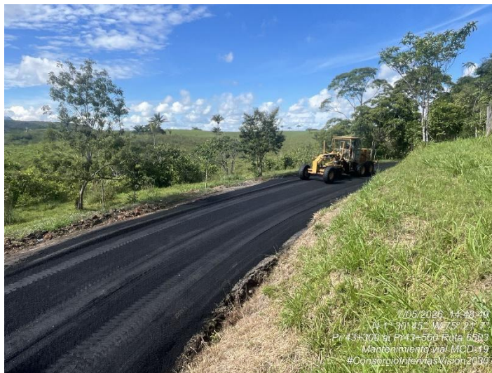
Fotografía 193. PR43+300 Ruta 6503, Instalación de MDC- 19 - Mantenimiento vial.
