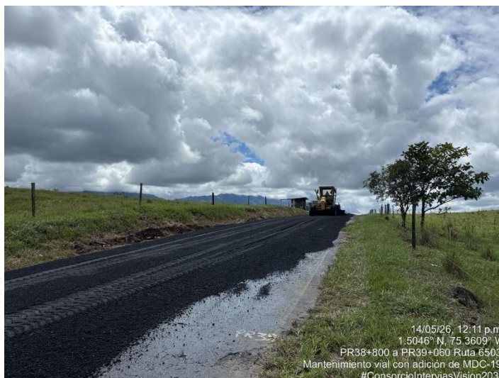
Fotografía 192. PR38+800 Ruta 6503, Instalación de MDC- 19 - Mantenimiento vial.
