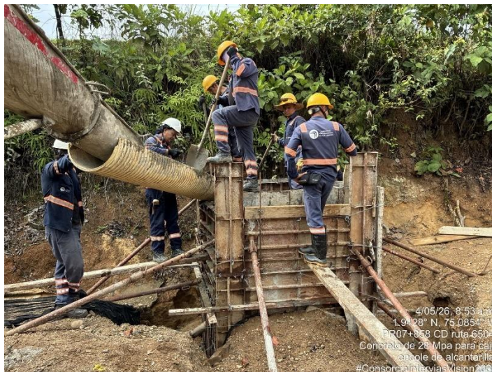
Fotografía 147. PR07+858 Ruta 6504, Suministro e instalación de concreto 28 MPa muros caja – Alcantarilla.
