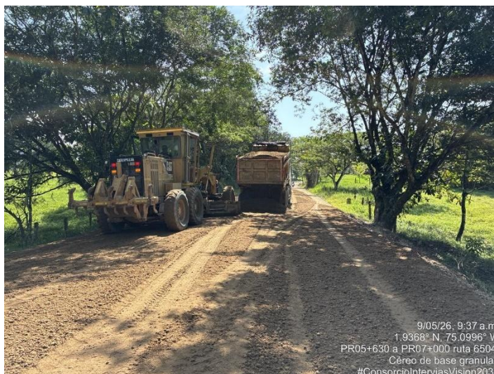
Fotografía 166. PR05+630 Ruta 6504, Suministro e instalación de base granular - Estructura de vía.
