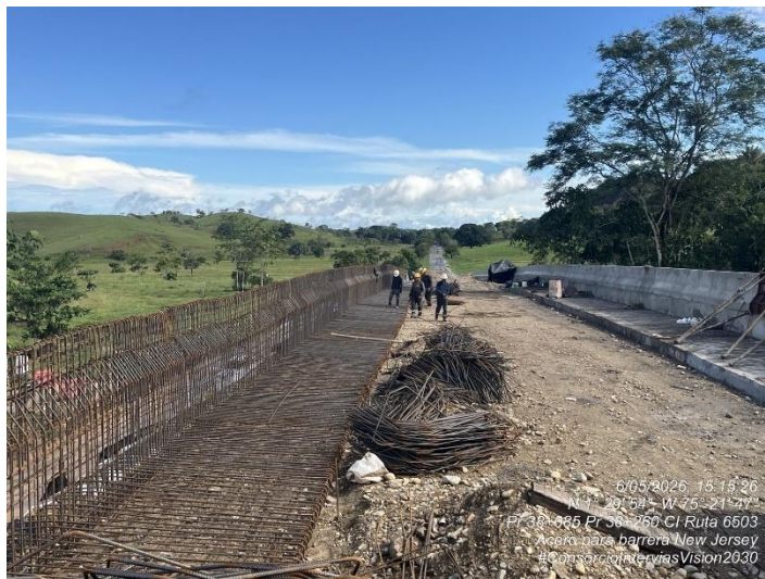
Fotografía 217. PR38+180 Ruta 6503, Armado acero de refuerzo New Jersey – Accesos puente quebrada Las Delicias.
