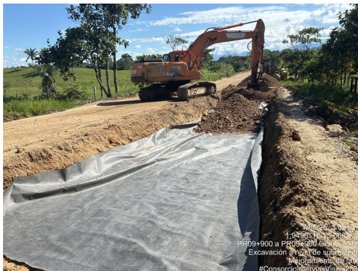
Fotografía 158. PR09+900 Ruta 6504, Suministro e instalación de geotextil y crudo - Mejoramiento de fallo.
