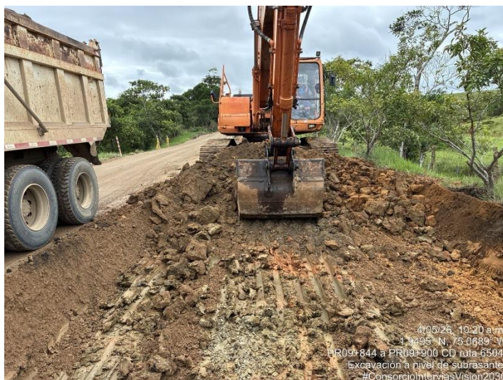
Fotografía 152. PR09+844 Ruta 6504, Excavación a nivel de subrasante.
