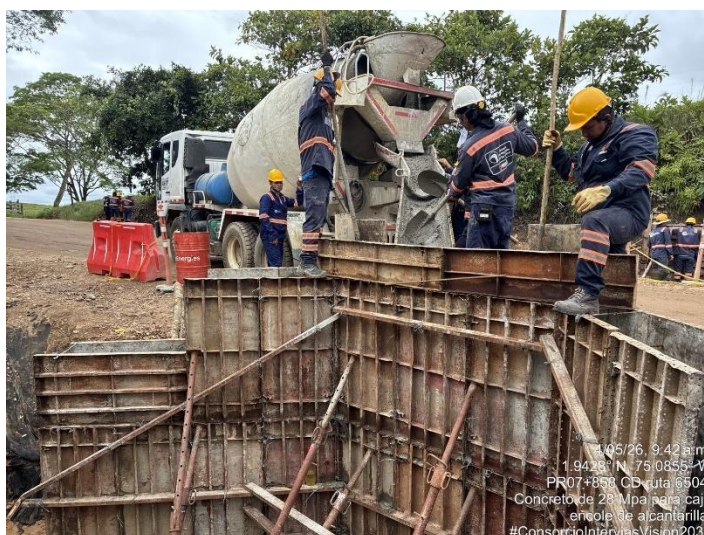
Fotografía 148. PR07+858 Ruta 6504, Suministro e instalación de concreto 28 MPa muro y aletas - Alcantarilla.
