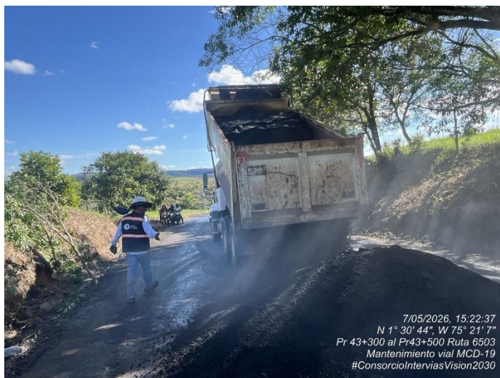
Fotografía 190. PR43+300 Ruta 6503, Instalación de MDC- 19 - Mantenimiento vial.
