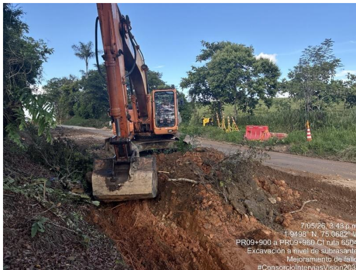
Fotografía 157. PR09+950 Ruta 6504, Excavación - Mejoramiento de fallo.
