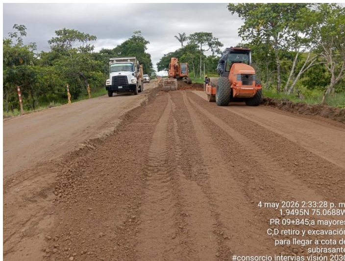
Fotografía 161. PR09+845 Ruta 6504, Suministro e instalación de subbase granular - Estructura de vía.
