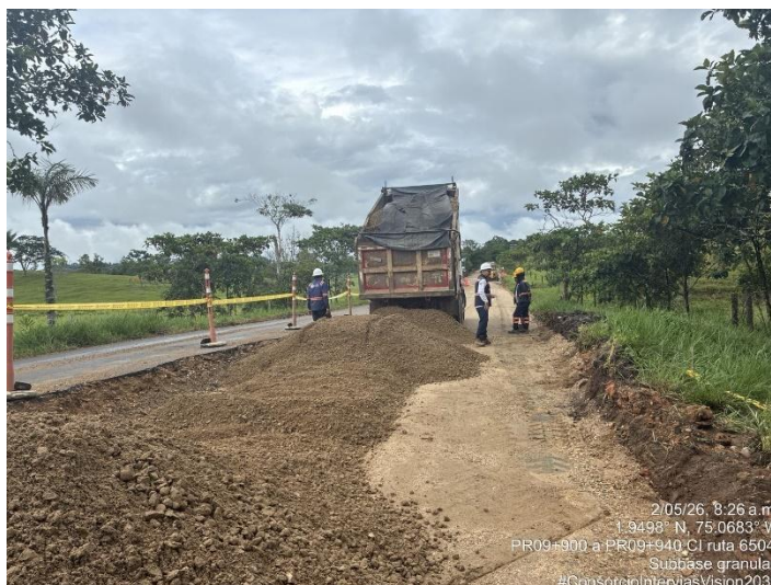
Fotografía 159. PR09+900 Ruta 6504, Suministro e instalación de subbase granular.
