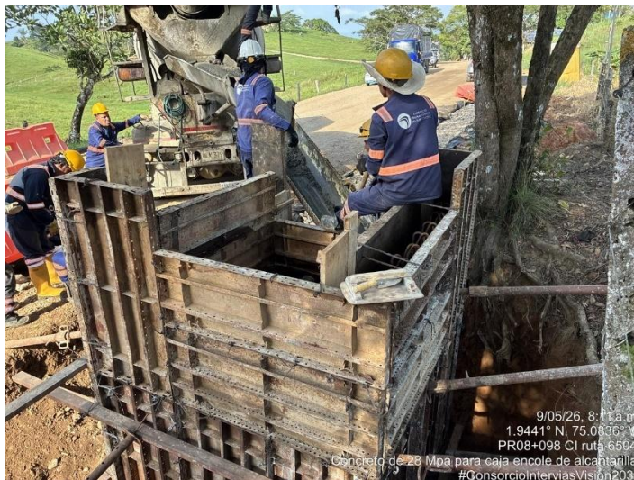
Fotografía 149. PR08+098 Ruta 6504, Suministro e instalación de concreto 28 MPa muros caja – Alcantarilla.
