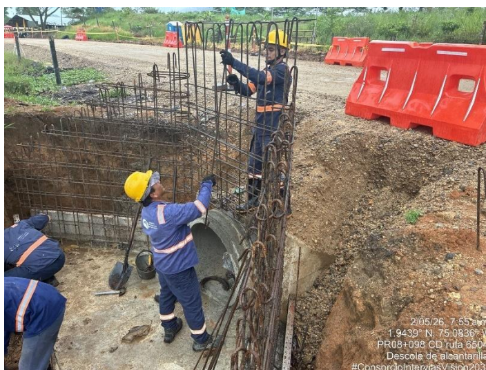
Fotografía 142. PR08+098 Ruta 6504, Armado acero de refuerzo placa solera y aletas – Alcantarilla.
