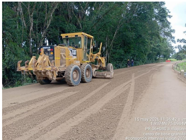
Fotografía 170. PR06+080 Ruta 6504, Suministro e instalación de base granular - Estructura de vía.
