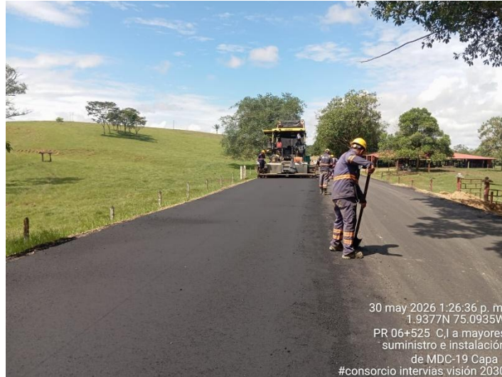
Fotografía 183. PR06+525 Ruta 6504, Suministro e instalación de mezcla asfáltica MDC-19.
