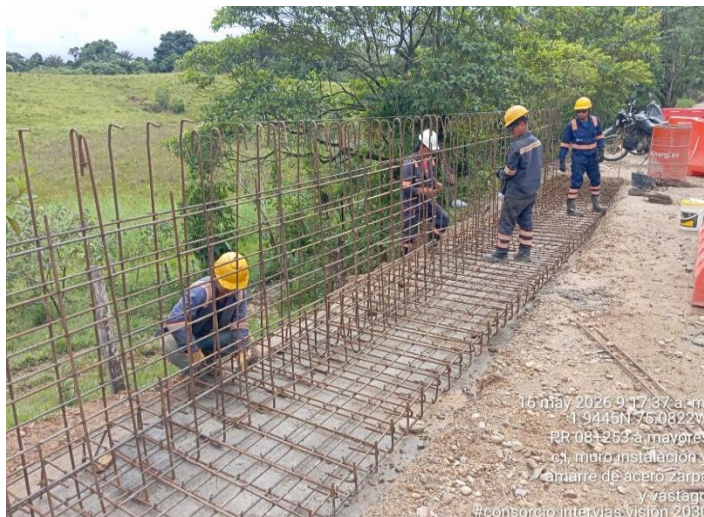
Fotografía 141. PR08+253 Ruta 6504, Armado acero de refuerzo - Muro.
