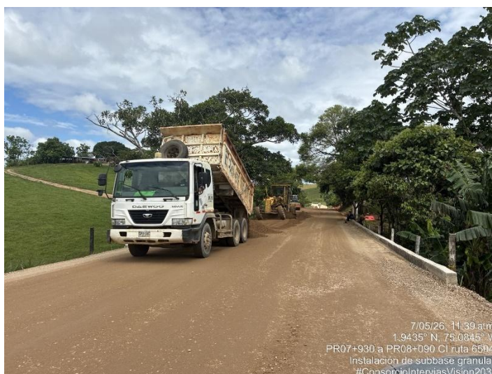
Fotografía 160. PR07+930 Ruta 6504, Suministro e instalación de subbase granular - Estructura de vía.
