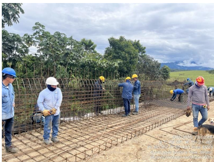
Fotografía 216. PR38+390 Ruta 6503, Armado acero de refuerzo New Jersey – Accesos puente quebrada Las Delicias.
