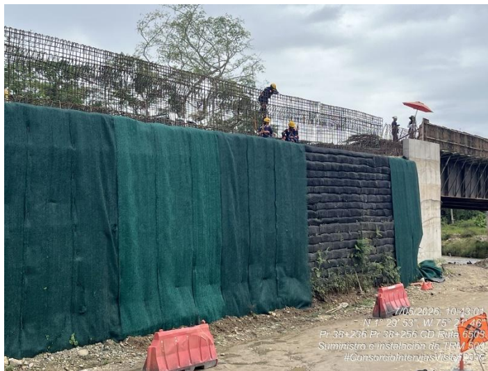
Fotografía 213. PR38+250 Ruta 6503, Instalación de manto TRM – Accesos puente quebrada Las Delicias.
