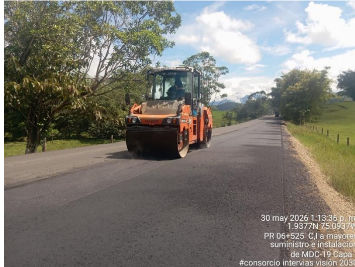
Fotografía 185. PR06+600 Ruta 6504, Compactación de mezcla asfáltica MDC-19.
