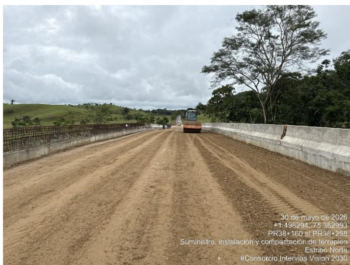
Fotografía 210. PR38+170 Ruta 6503, Compactación suelo de relleno MSME – Accesos puente quebrada Las Delicias.
