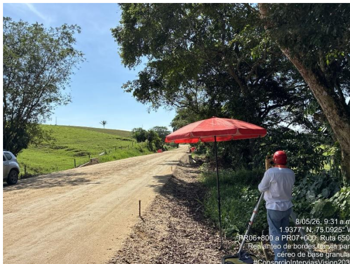
Fotografía 165. PR06+800 Ruta 6504, Replanteo de bordes de vía para cereo SBG – Estructura de vía.
