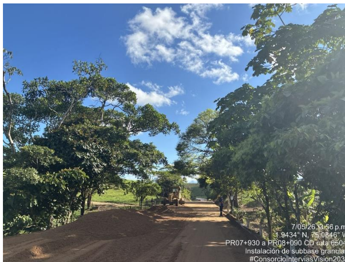
Fotografía 164. PR08+090 Ruta 6504, Instalación de subbase granular - Estructura de vía.
