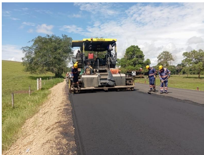
Fotografía 182. PR6+525 Ruta 6504, Suministro e instalación de mezcla asfáltica MDC-19.
