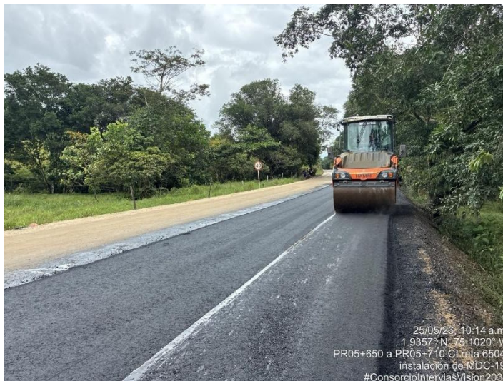
Fotografía 187. PR05+650 Ruta 6504, Compactación de mezcla asfáltica MDC-19.
