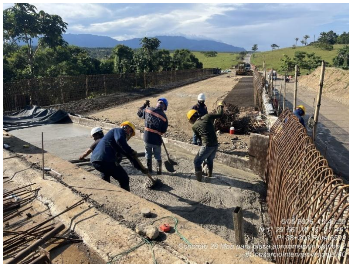
Fotografía 201. PR38+303 Ruta 6503, Suministro e instalación de concreto 28 MPa placa de aproximación – Puente.
