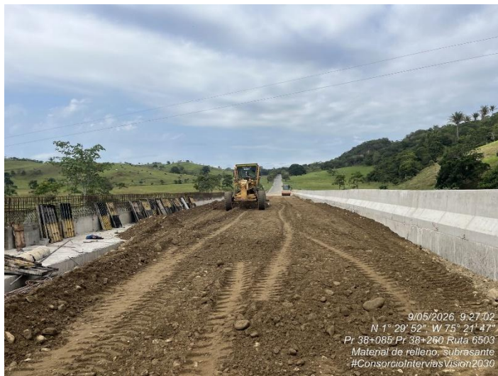
Fotografía 207. PR38+200 Ruta 6503, Instalación de suelo de relleno MSME – Accesos puente quebrada Las Delicias.
