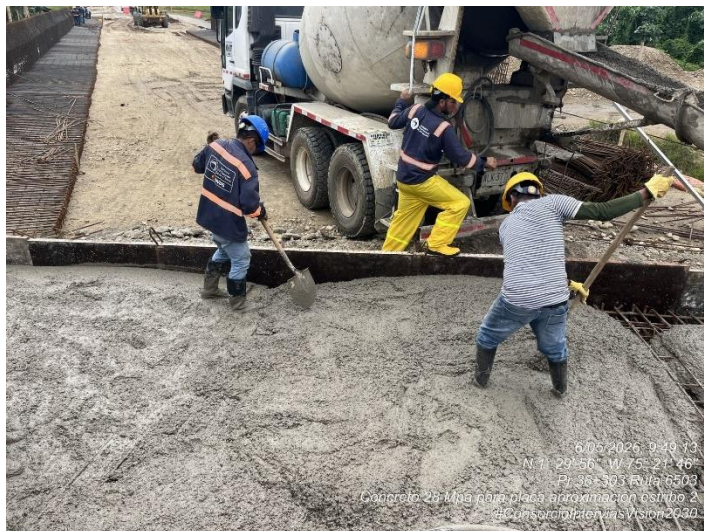
Fotografía 203. PR38+303 Ruta 6503, Suministro e instalación de concreto 28 MPa placa de aproximación – Puente.
