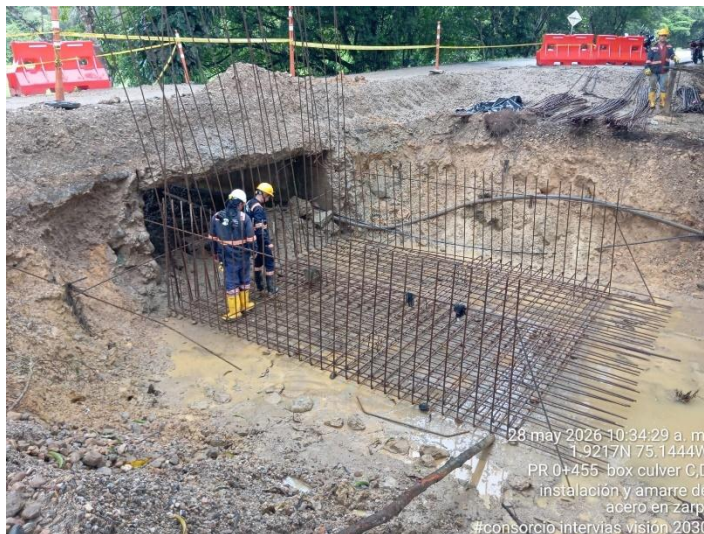
Fotografía 143. PR00+455 Ruta 6504, Armado acero de refuerzo placa – Box Culvert.
