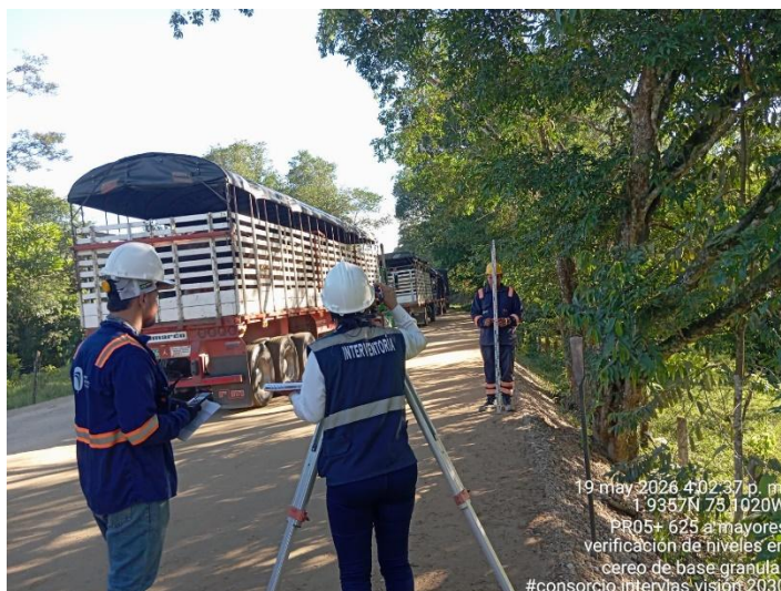
Fotografía 172. PR05+625 Ruta 6504, Verificación de niveles base granular – Estructura de vía.
