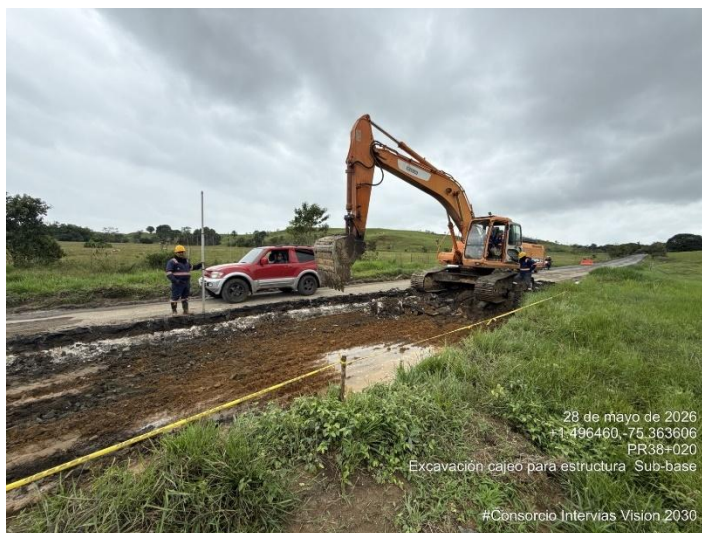
Fotografía 228. PR38+020 Ruta 6503, Excavación – Accesos puente quebrada Las Delicias.
