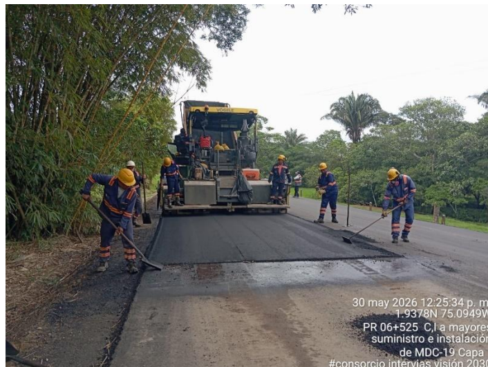
Fotografía 184. PR06+525 Ruta 6504, Suministro e instalación de mezcla asfáltica MDC-19.
