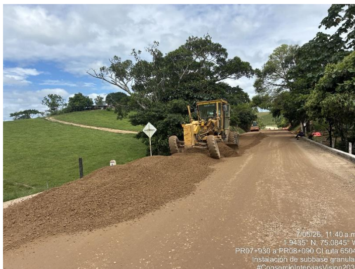
Fotografía 162. PR08+000 Ruta 6504, Suministro e instalación de subbase granular - Estructura de vía.
