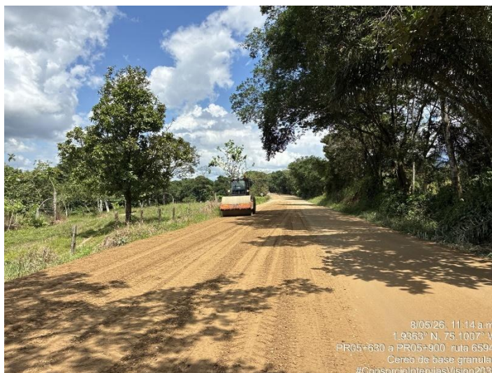
Fotografía 171. PR05+900 Ruta 6504, Suministro e instalación de base granular - Estructura de vía.
