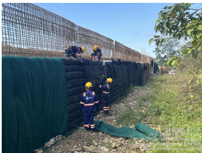
Fotografía 212. PR38+360 Ruta 6503, Instalación de manto TRM MSME – Accesos puente quebrada Las Delicias.
