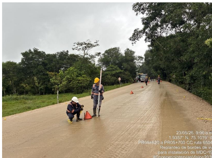
Fotografía 176. PR05+620 Ruta 6504, Replanteo de alineamiento para instalación MDC-19.
