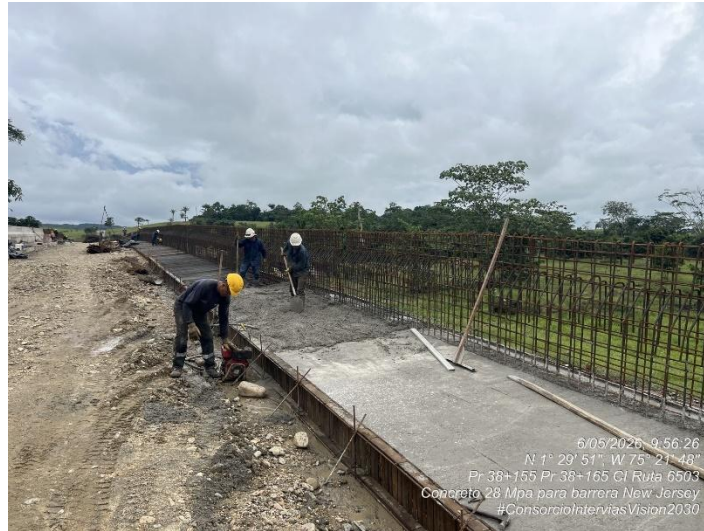
Fotografía 223. PR38+155 Ruta 6503, Suministro e instalación de concreto 28 MPa New Jersey – Accesos puente quebrada Las Delicias.
