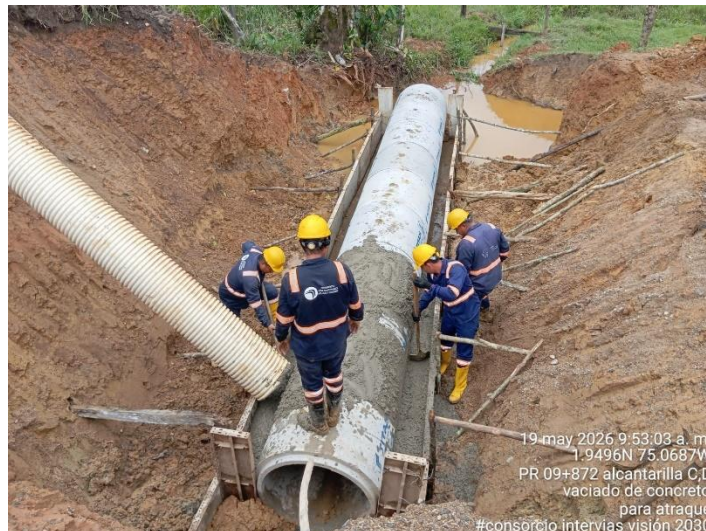
Fotografía 140. PR09+872 Ruta 6504, Suministro e instalación de concreto 14 MPa atraque tubería – Alcantarilla.
