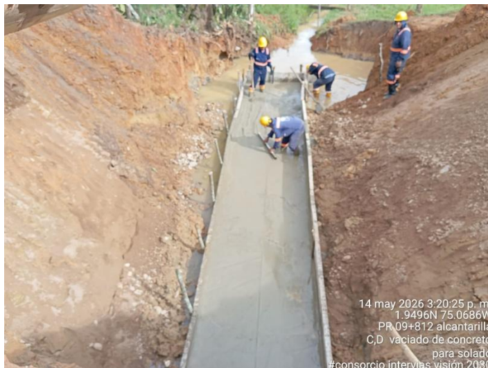
Fotografía 137. PR09+812 Ruta 6504, Suministro e instalación de concreto 14 MPa placa tubería – Alcantarilla.
