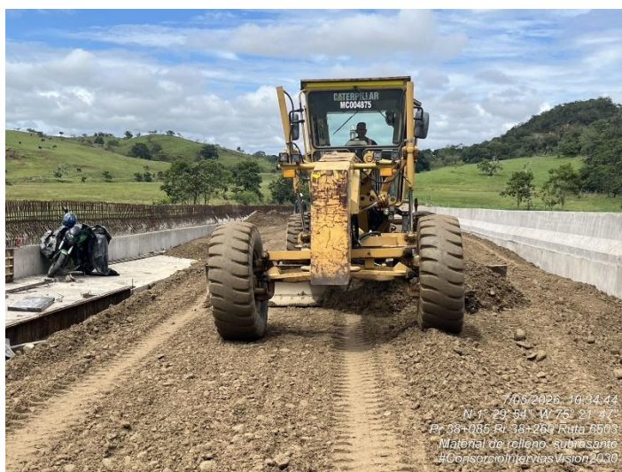
Fotografía 208. PR38+150 Ruta 6503, Instalación de suelo de relleno MSME – Accesos puente quebrada Las Delicias.
