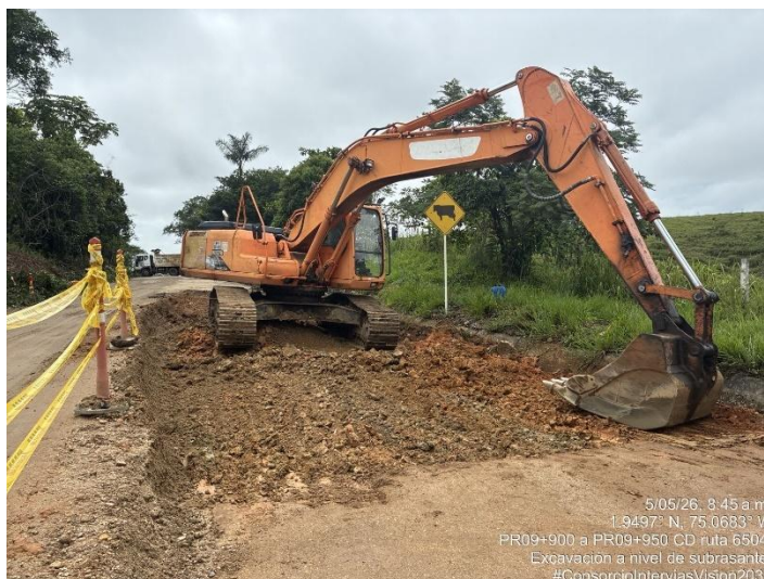
Fotografía 153. PR09+950 Ruta 6504, Excavación a nivel de subrasante.
