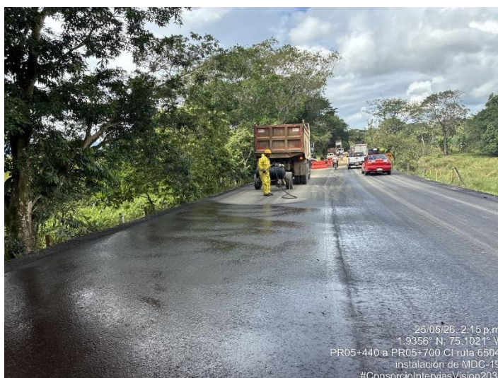
Fotografía 178. PR05+700 Ruta 6504, Imprimación para instalación de mezcla asfáltica.
