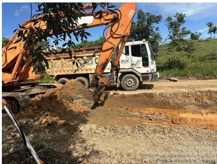
Fotografía 156. PR09+920 Ruta 6504, Excavación - Mejoramiento de fallo.
