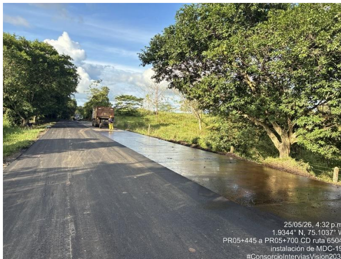
Fotografía 179. PR05+445 Ruta 6504, Imprimación para instalación de mezcla asfáltica.
