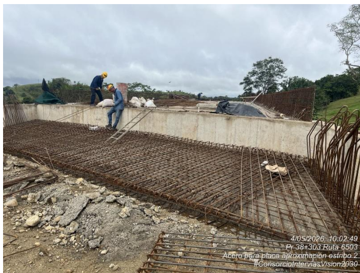
Fotografía 200. PR38+303 Ruta 6503, Armado acero para placa de aproximación – Puente.
