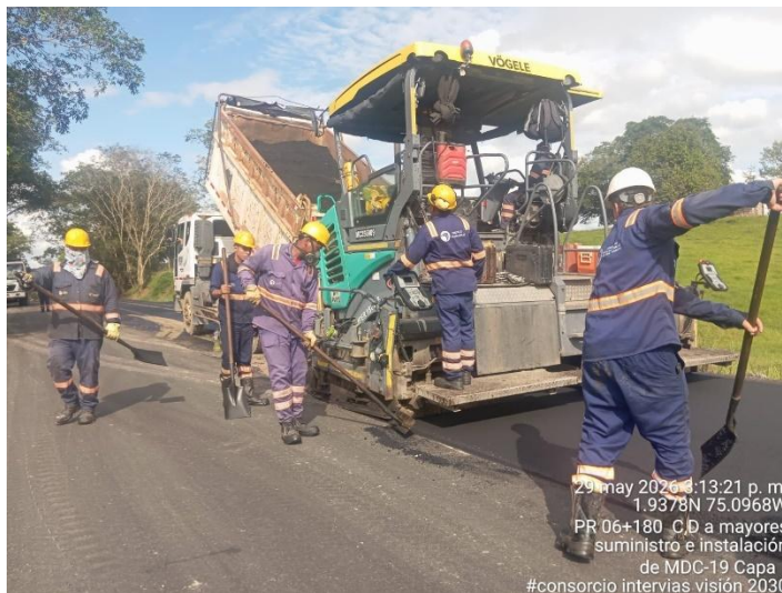
Fotografía 181. PR06+180 Ruta 6504, Suministro e instalación de mezcla asfáltica MDC-19
