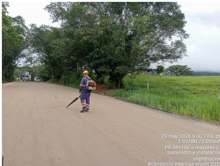
Fotografía 175. PR06+180 Ruta 6504, Sopleteo base granular para imprimación.
