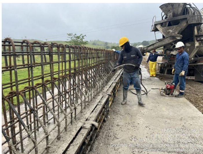
Fotografía 222. PR38+185 Ruta 6503, Suministro e instalación de concreto 28 MPa New Jersey – Accesos puente quebrada Las Delicias.
