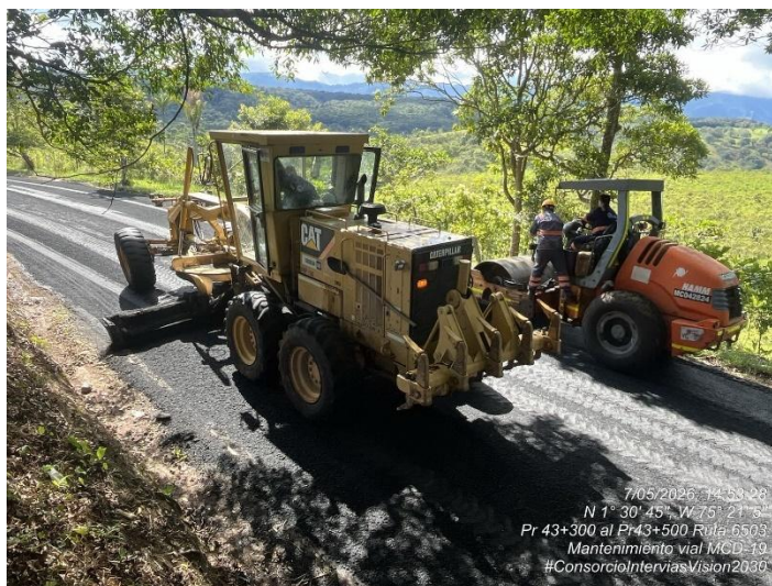
Fotografía 196. PR43+500 Ruta 6503, Instalación y compactación de MDC- 19 - Mantenimiento vial.
