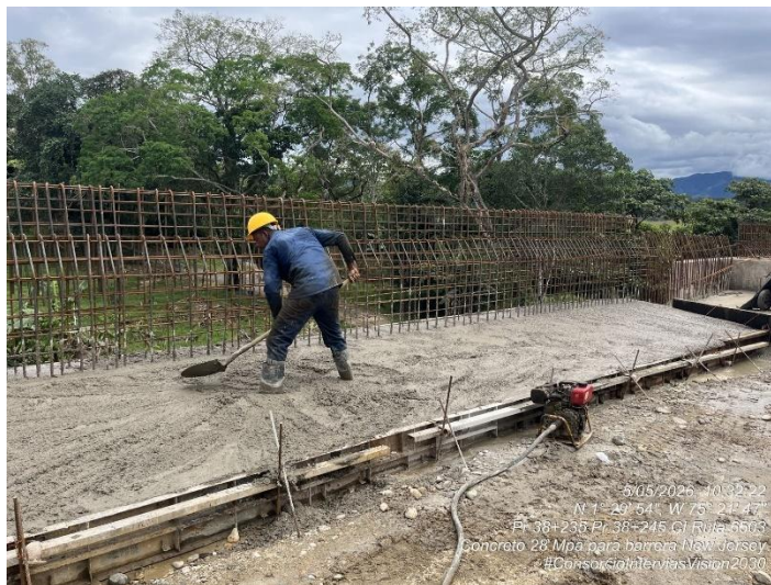
Fotografía 221. PR38+235 Ruta 6503, Suministro e instalación de concreto 28 MPa – Barrera New Jersey.
