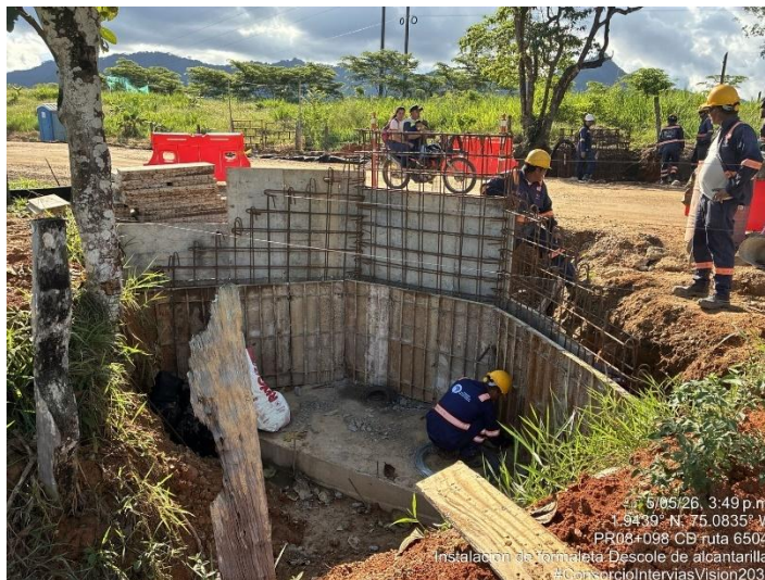
Fotografía 145. PR08+098 Ruta 6504, Encofrado muro y aletas – Alcantarilla.
