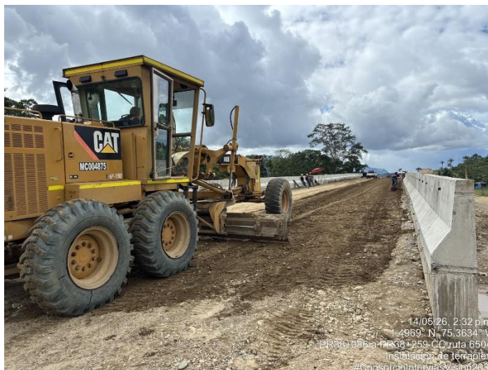
Fotografía 206. PR38+100 Ruta 6503, Instalación de suelo de relleno MSME – Accesos puente quebrada Las Delicias.
