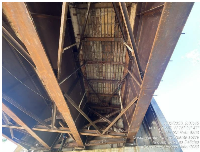
Fotografía 205. PR38+295 Ruta 6503, Desencofrado tablero – Puente.
