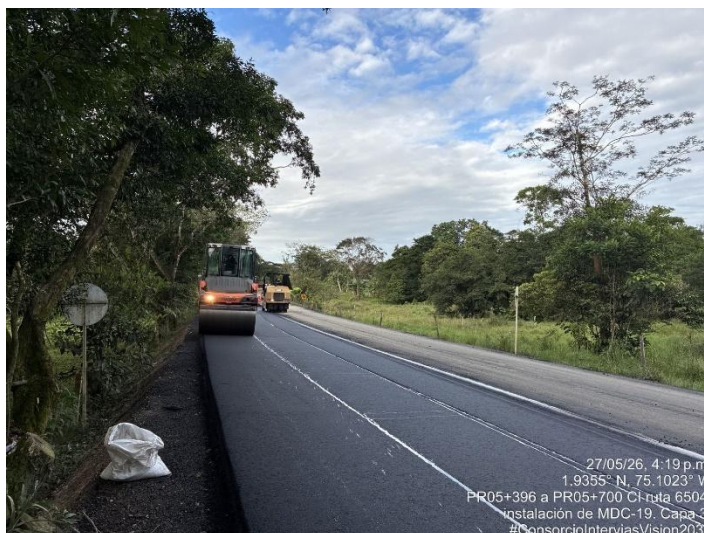
Fotografía 188. PR05+396 Ruta 6504, Compactación de mezcla asfáltica MDC-19.
