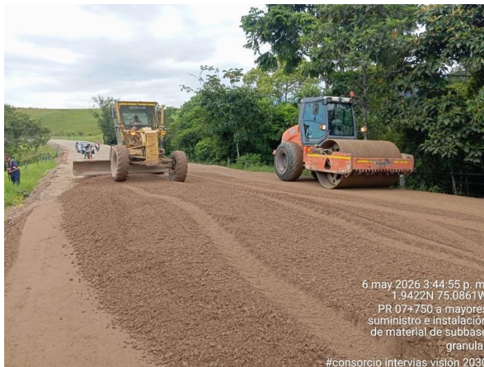
Fotografía 163. PR07+750 Ruta 6504, Instalación de subbase granular - Estructura de vía.
