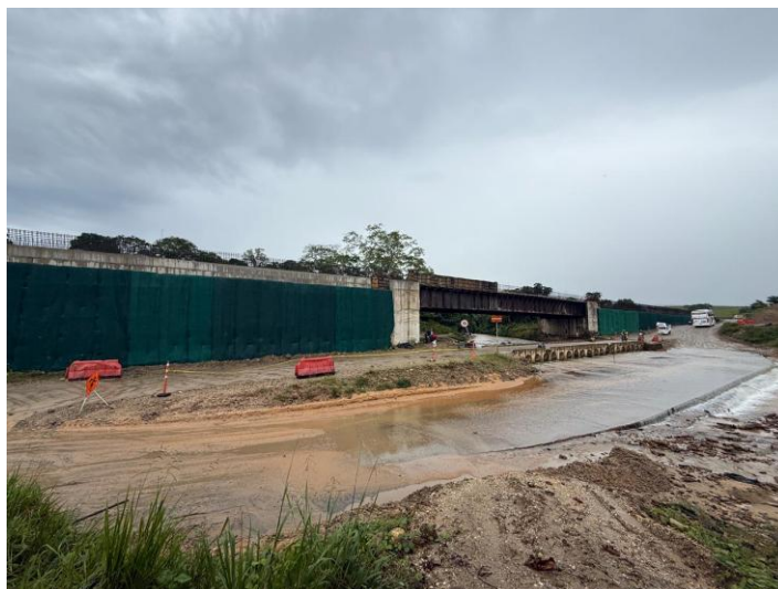
Fotografía 226. PR38+295 Ruta 6503, Accesos puente quebrada Las Delicias.
