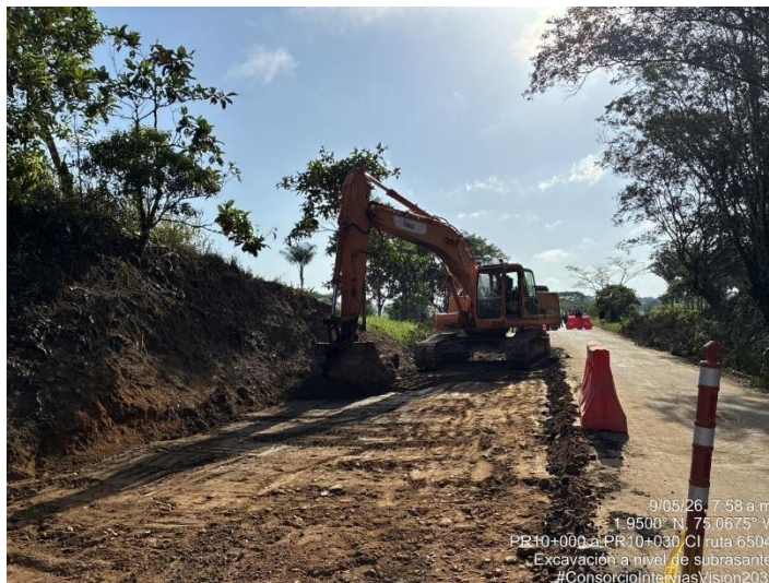
Fotografía 155. PR10+000 Ruta 6504, Excavación a nivel de subrasante.
