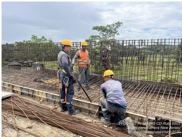
Fotografía 215. PR38+215 Ruta 6503, Armado acero de refuerzo New Jersey – Accesos puente quebrada Las Delicias.
