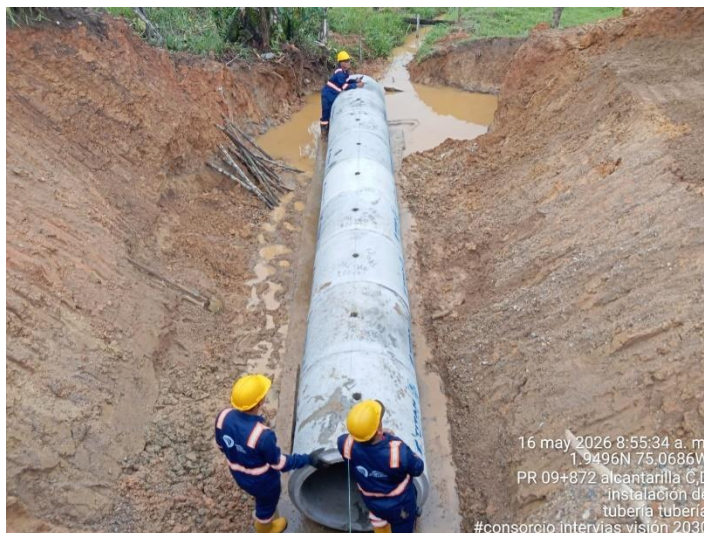
Fotografía 138. PR09+872 Ruta 6504, Suministro e instalación tubería 36" – Alcantarilla.
