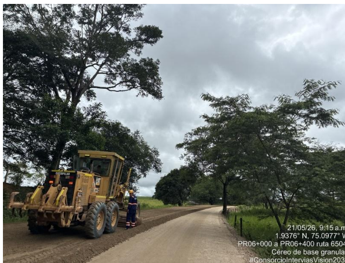
Fotografía 168. PR06+000 Ruta 6504, Suministro e instalación de base granular - Estructura de vía.
