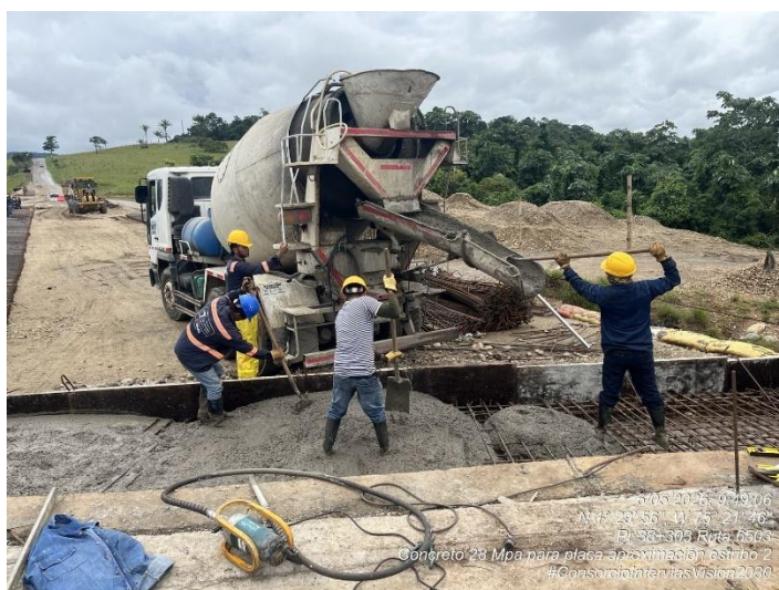
Fotografía 202. PR38+303 Ruta 6503, Suministro e instalación de concreto 28 MPa placa de aproximación – Puente.
