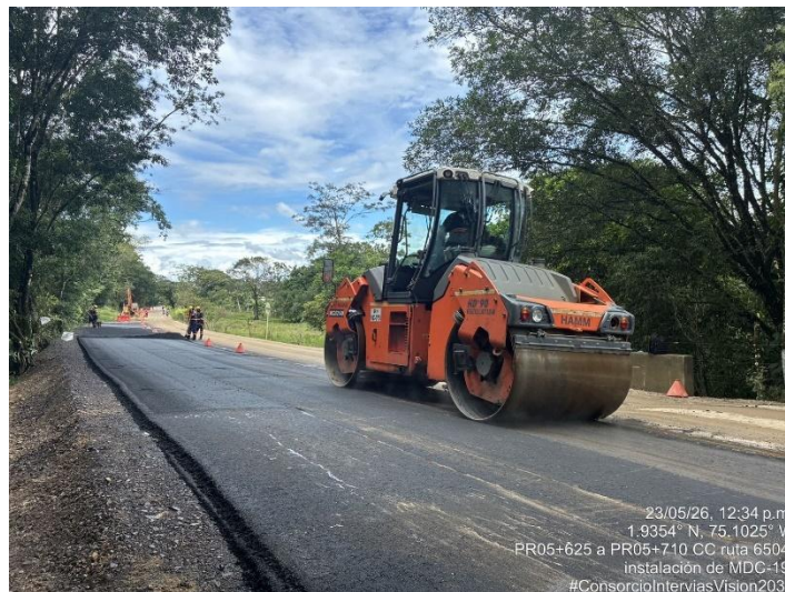
Fotografía 186. PR05+710 Ruta 6504, Compactación de mezcla asfáltica MDC-19.
