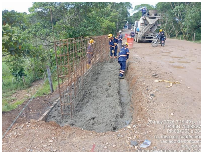
Fotografía 150. PR08+253 Ruta 6504, Suministro e instalación de concreto 28 MPa zarpa – Muro de contención.
