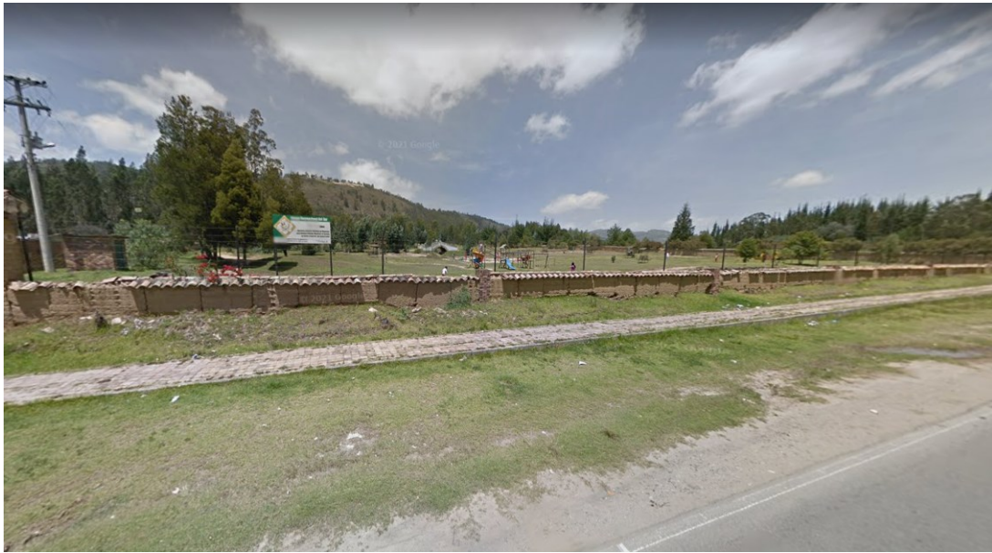
Fotografía 1. Aspecto general del sitio donde se proyecta la obra.
