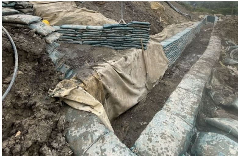
Imagen No. 2. ACTIVIDADES FINALIZADAS PR18+400 – OBRAS HIDRAÚLICAS
