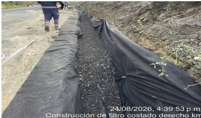
Imagen No. 3. ACTIVIDADES EN FINALIZACIÓN PR18+400 – OBRAS HIDRÁULICAS – FILTRO EN EJECUCIÓN
