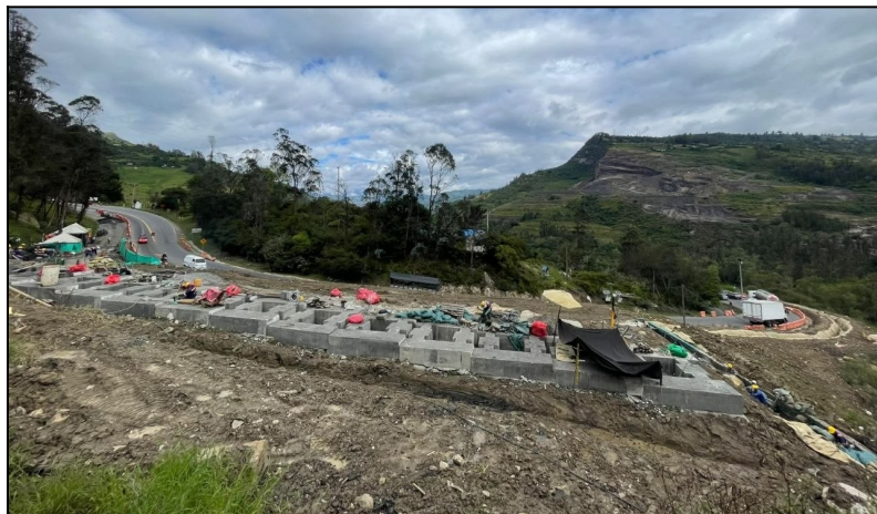
Imagen No. 1. ACTIVIDADES FINALIZADAS PR18+400 – VIGA CABEZAL PANTALLA CON TUBERÍA METÁLICA
