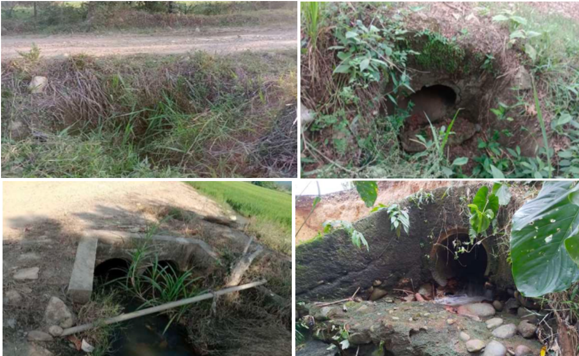
Figura 2. Estado actual de las obras de drenaje existentes en los tramos priorizados.
