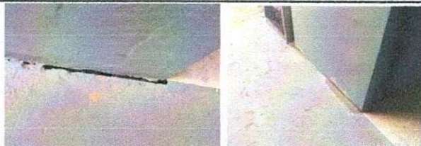
Imágenes 1 y 2: Reparación de grieta en la torre 18
