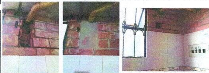
Imágenes 6 y 7: Reparación de la torre 19, donde se había perforado el tubo
