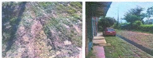
Imágenes 8 y 9: Evidencia de como los propietarios de la torre 19, esta dañado la zona verde.
