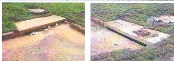
Imagen 14: Instalación de rejilla en sumidero.
