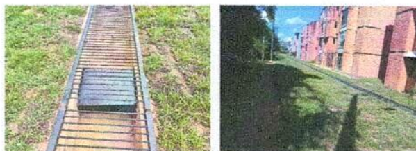
Imágenes 11 y 12: Instalación de lamina de protección de la tubería eléctrica que cruza por el carcamo.
