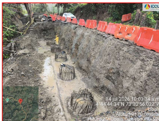
Solados para construcción de viga cabezal Muro 2.7 k7+594
