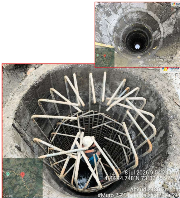
Construcción de Caissons Muro 2.1 k5+120
