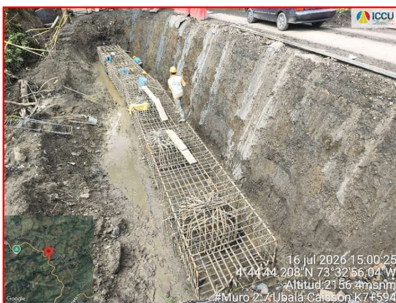
Solados para construcción de viga cabezal Muro 2.7 k7+594
