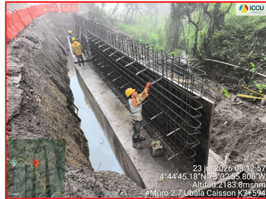
Fundida de Vigas y Pantallas Muro 2.7 k7+594
