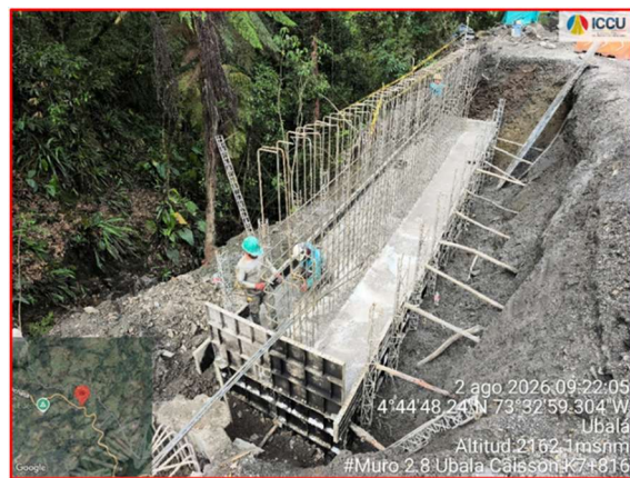
Figurado y amarre de refuerzos Muro 2.8 k7+802
