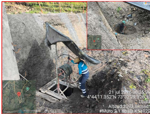
Construcción de Caissons Muro 2.1 k5+120
