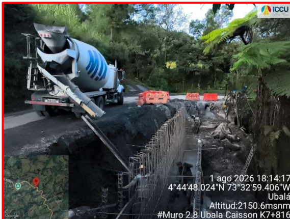
Figurado y amarre de refuerzos Muro 2.8 k7+802
