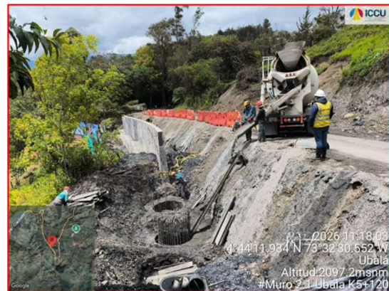
Construcción de Caissons Muro 2.1 k5+120
