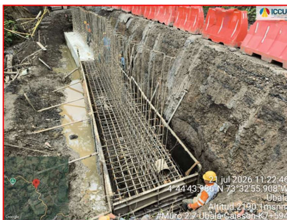
Solados para construcción de viga cabezal Muro 2.7 k7+594
