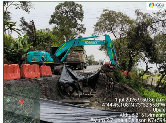
Excavaciones aproches Muro 2.7 k7+594
