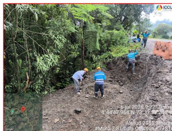
Excavaciones aproches Muro 2.7 k7+594
