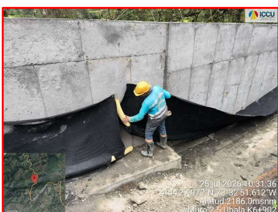
Relleno Estructural Muro 2.5 k6+902 y control de Densidad Insitu
