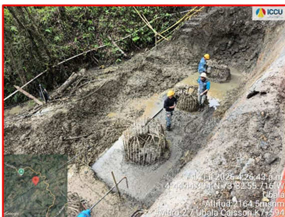
Solados para construcción de viga cabezal Muro 2.7 k7+594
