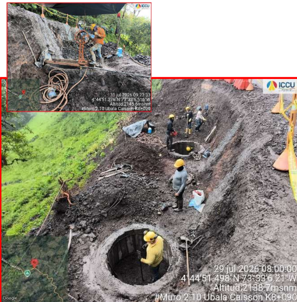
Construcción de Caissons Muro 2.10 k8+090
