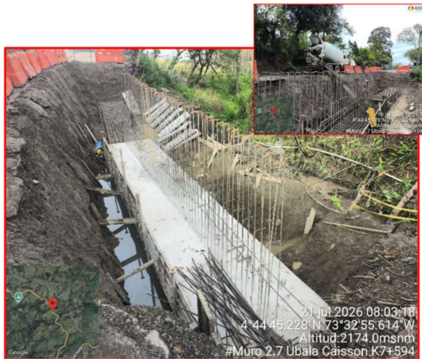
Fundida de Vigas y Pantallas Muro 2.7 k7+594
