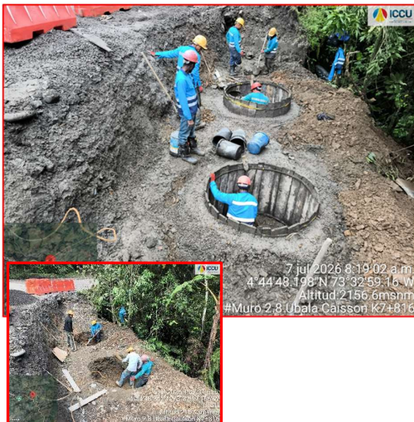
Construcción de Caissons Muro 2.8 k7+802
