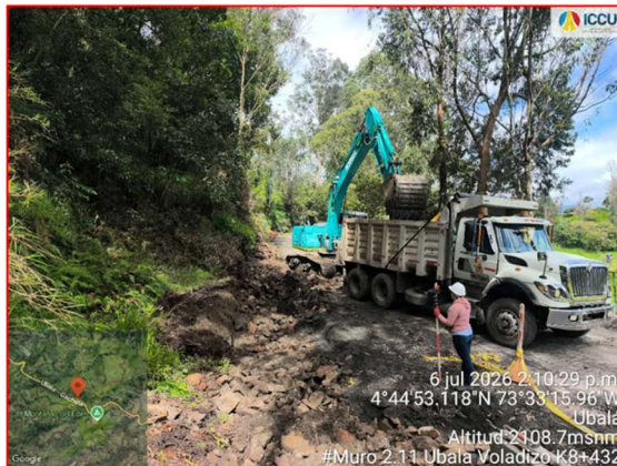
Excavaciones Muro 2.10 k8+090
