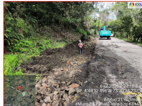
Excavaciones Muro 2.10 k8+090
