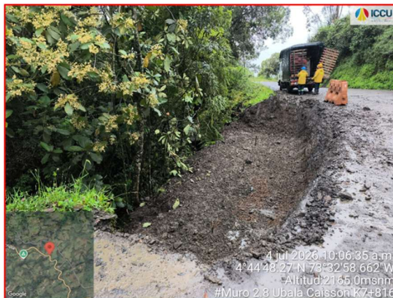
Excavaciones aproches Muro 2.7 k7+594
