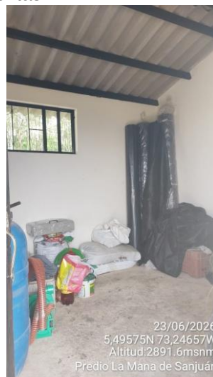
Interior de la bodega.
