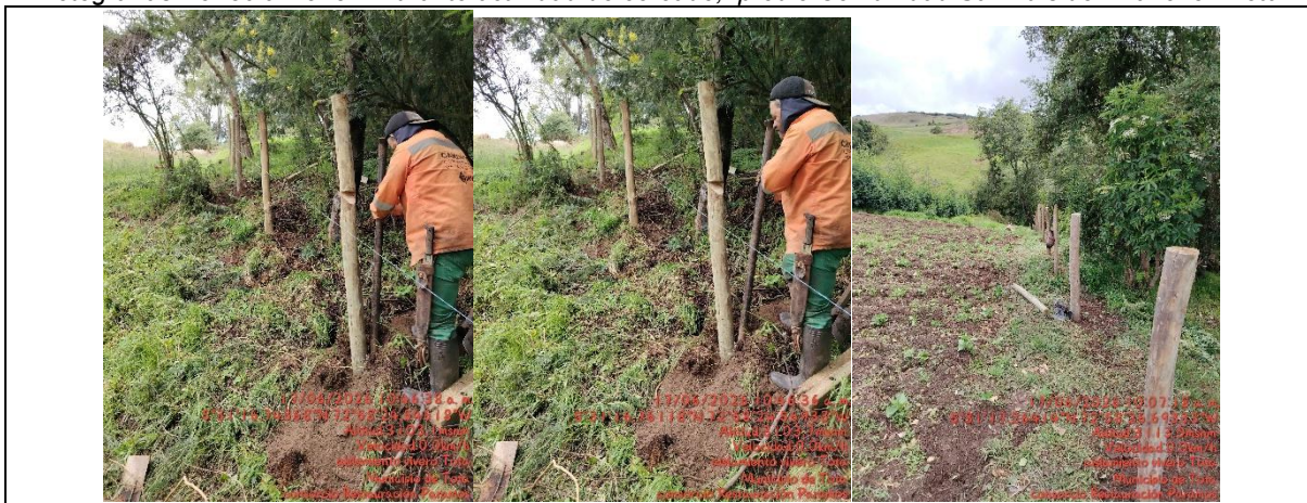
Fotografías No. 80 a No. 82 Durante actividad de cercado, predio Comunidad San Luis de Pirancho - Tota
