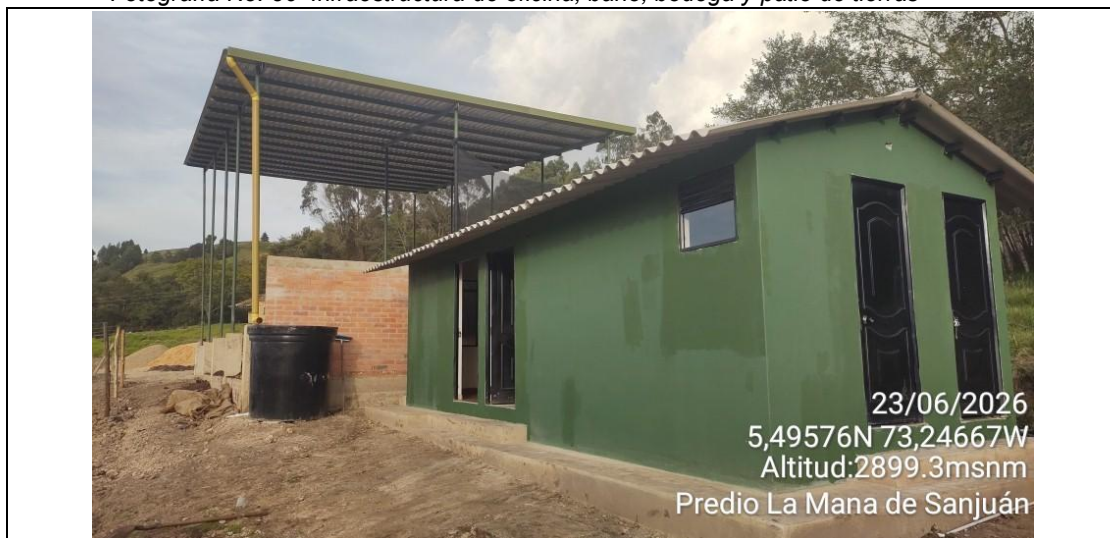
Fotografía No. 86 Infraestructura de oficina, baño, bodega y patio de tierras
