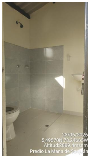
Interior de la unidad sanitaria.
