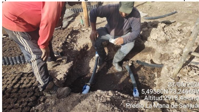
Instalación del Sistema de riego. Fuente: Equipo de trabajo Consorcio
