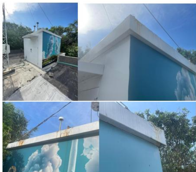
Fig. 3. Estación Tres Ave Marías
