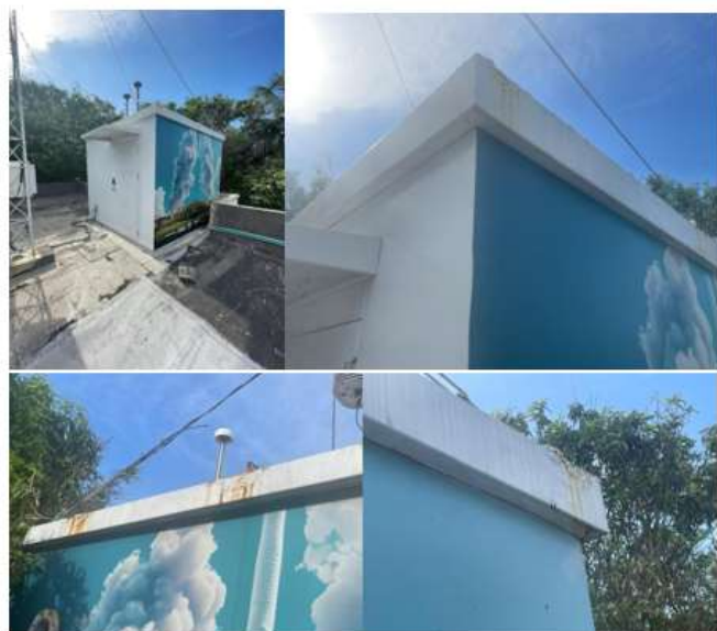
Fig. 3. Estación Tres Ave Marías
