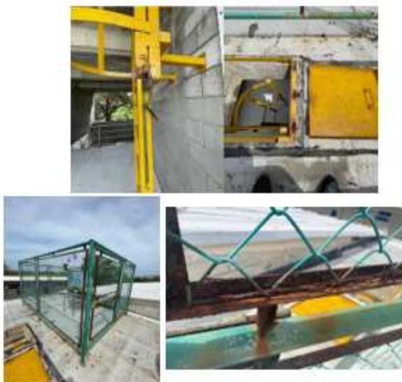
Fig1. Estación IED Juan mina
