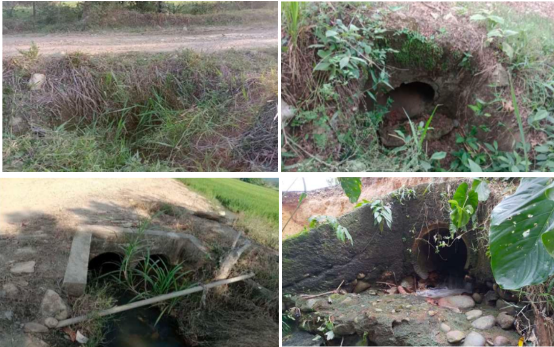
Figura 2. Estado actual de las obras de drenaje existentes en los tramos priorizados.
