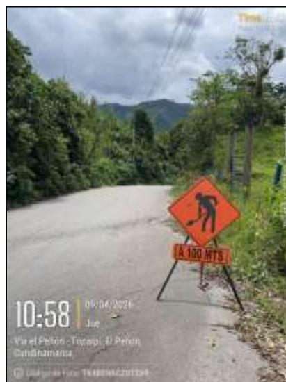
Fotografía 10. Señalización en obra.
