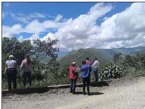
Foto 7. K0+400. Sitio critico No. 8 – Muro de contención.
