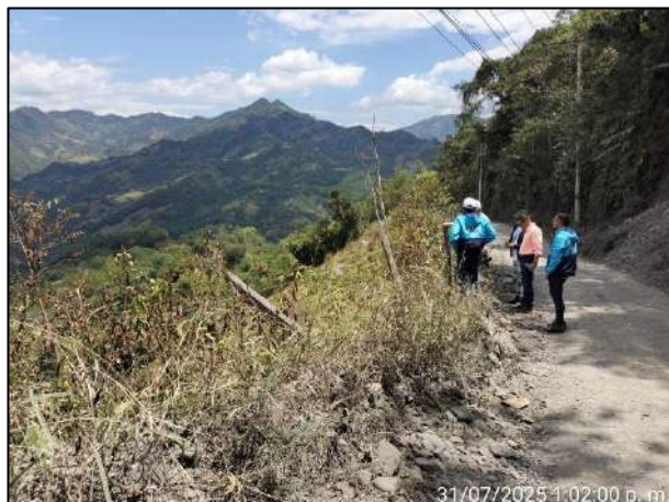
Foto 5. K0+400. Vía en afirmado
