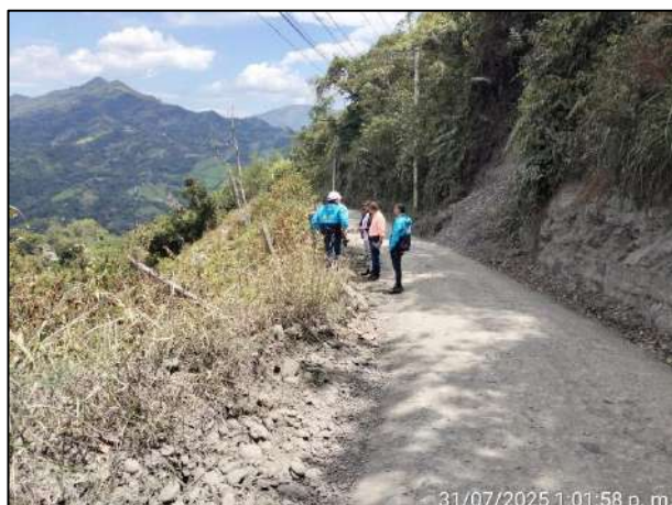
Foto 3. K0+220. Carpeta de rodadura en afirmado.
