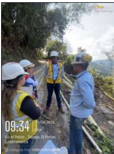
Fotografía 3. Recorrido en obra
