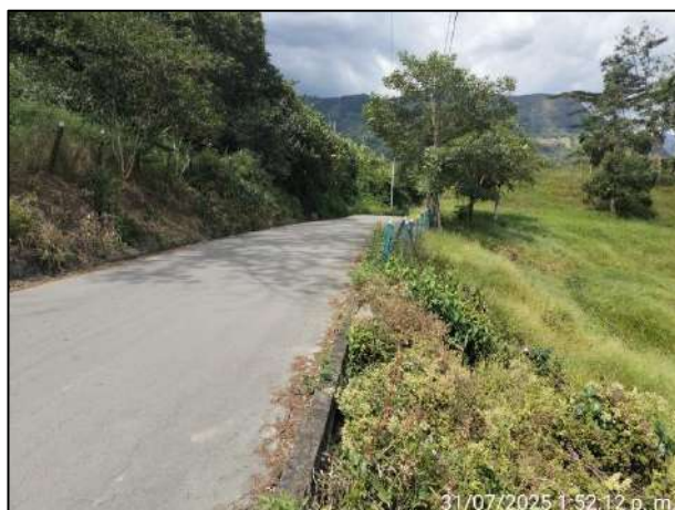
Foto 9. K1+300. Pavimento deteriorado.
