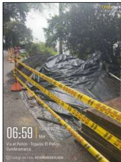
Fotografía 8. Señalización en obra
