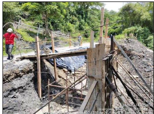
Registro Fotográfico 1. Actividades de construcción Muro de Contención 4 – K1+140.
