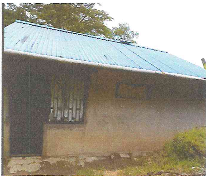
Fachada de la vivienda
