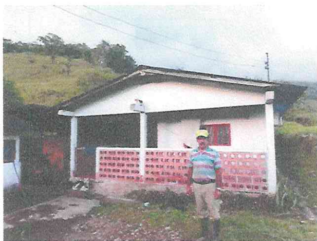
Fachada de la vivienda
