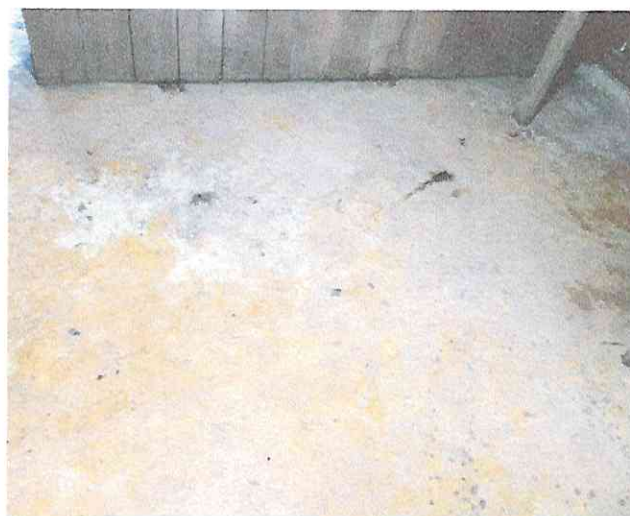
Punto instalación de la estufa
