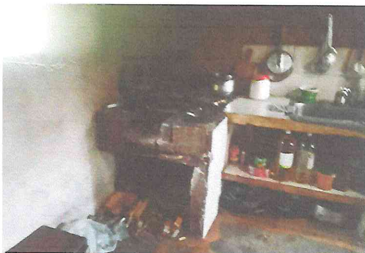
Punto instalación de la estufa
