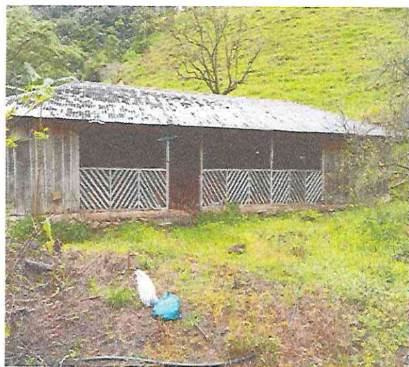
Fachada de la vivienda
