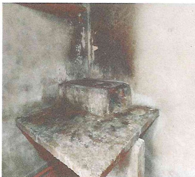
Punto instalación de la estufa
