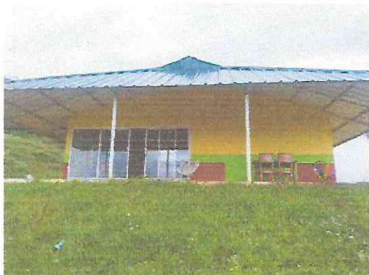
Fachada de la vivienda
