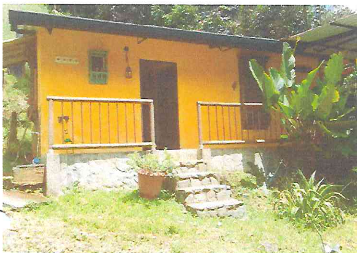
Fachada de la vivienda
