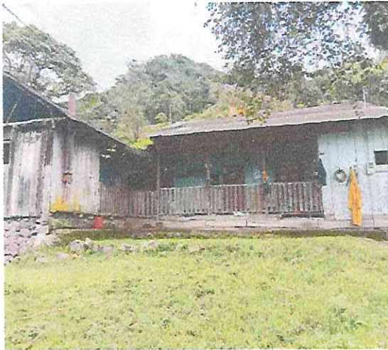
Fachada de la vivienda
