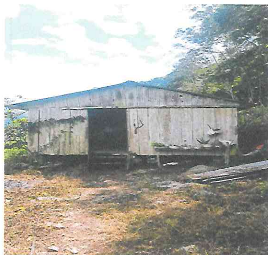
Fachada de la vivienda
