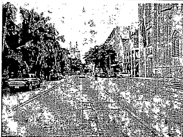
Foto 01: Estado actual vía. Fuente registro fotográfico: Proyecto
