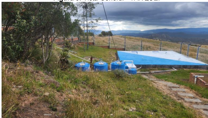
Figura 5. Vista General - TANQUE.
