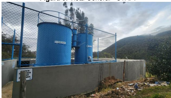
Figura 3. Vista General - STAP.
