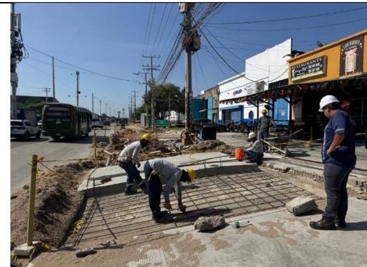
Figurado de acero de refuerzo para rampas
