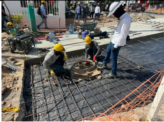
Instalación de acero de refuerzo para placas irregulares
