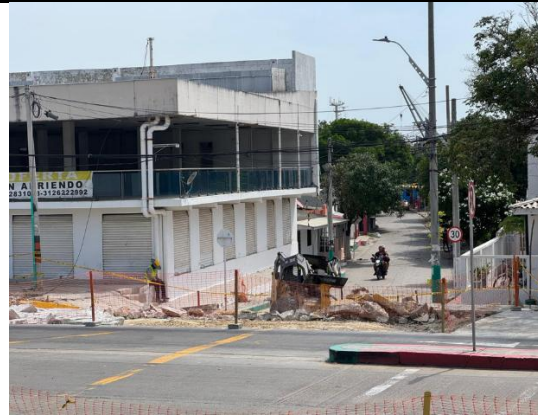
Demoliciones de pavimento via 40
