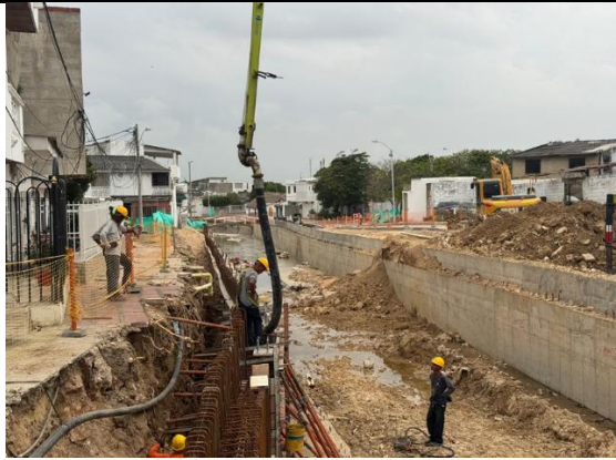
Vaciado de concreto de 4000psi para Muros de Canal
