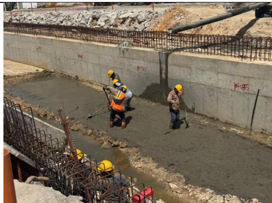
Vaciado de solado fondo de canal
