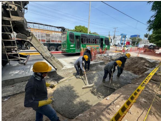
Vaciado de concreto para solado
