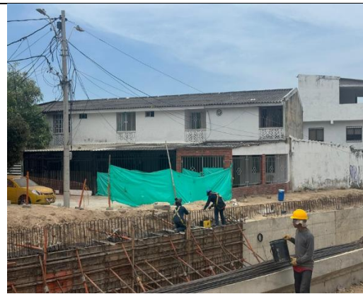
Instalación de platinas sobre muros
