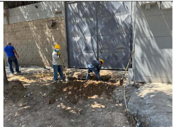
Reubicación de tuberías de redes existentes
