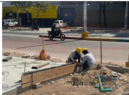
Figurado y vaciado de bordillos
