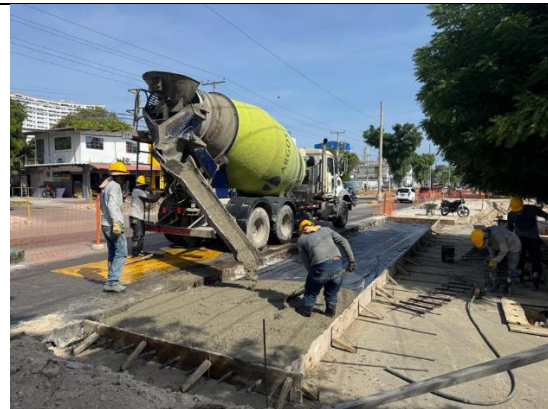
Vaciado de concreto MR-5
