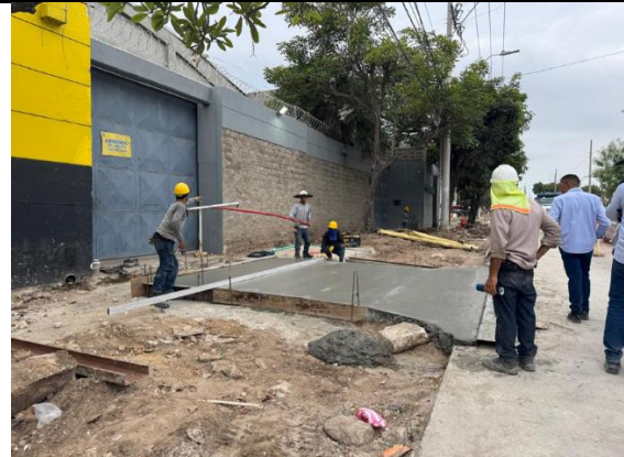
Vaciado de rampas de acceso a locales
