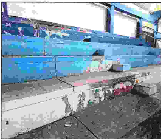
No. 1: deterioro, desprendimientos, fisuras superficiales y pérdida de pintura en graderías
