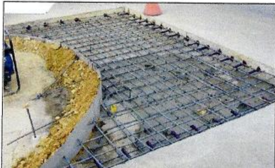
Detalle Losa irregular con refuerzo continuo.
