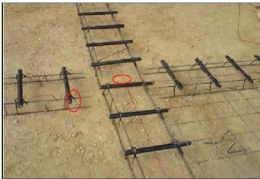
Ejemplo construcción canastillas e instalación dovelas.
