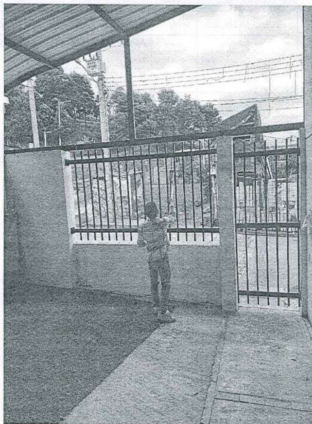
Ilustración 7 SUMINISTRO E INSTALACIÓN DE MALLA TIPO GALLINERO 180 X 10 METROS 1-1/4 PULGADAS-HOGAR COMUNITARIO DE BIENESTAR FAMILIAR MI PEQUEÑO MUNDO - LAS MERCEDES
