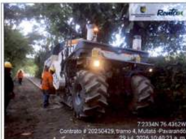
Construcción de filtros K2+730
