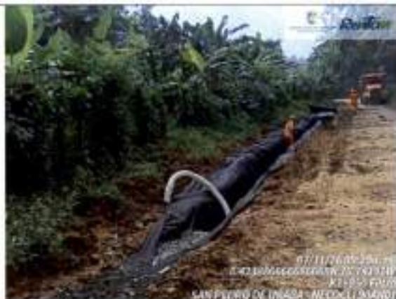
Construcción de filtros K1+850
