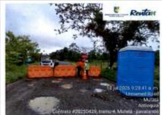
Implementación de PMT para construcción de filtros, limpieza de tuberías y construcción de tuberías.
