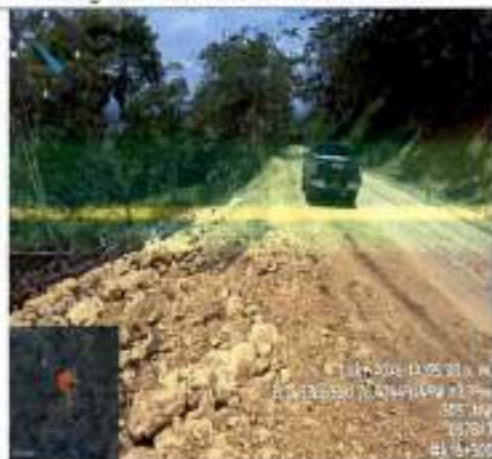
Fotografía No.9 Rellenos en vía K16+300
