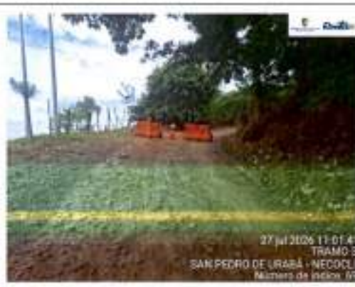
Implementación PMT en instalación de obras transversales
