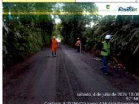
FIGURA 2 VERIFICACIÓN Y VALIDACIÓN DE BASE GRANULAR
