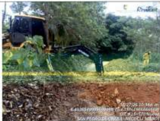
Excavación para instalación tubería O.T. K18+570
