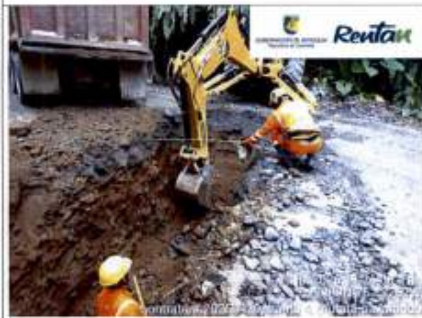
Limpieza de alcantarilla K17+510
