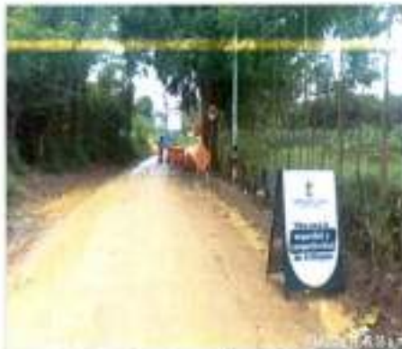
Instalación de vallas tijeras informativas
