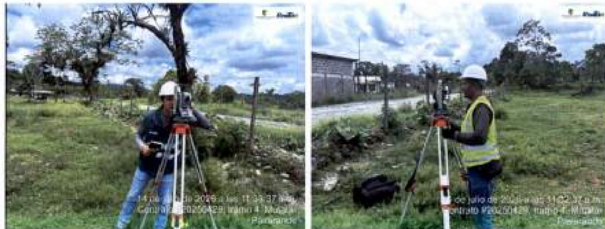
FIGURA 3 VERIFICACIÓN DE POLIGONAL CON SUS PUNTOS DE CONTROL
