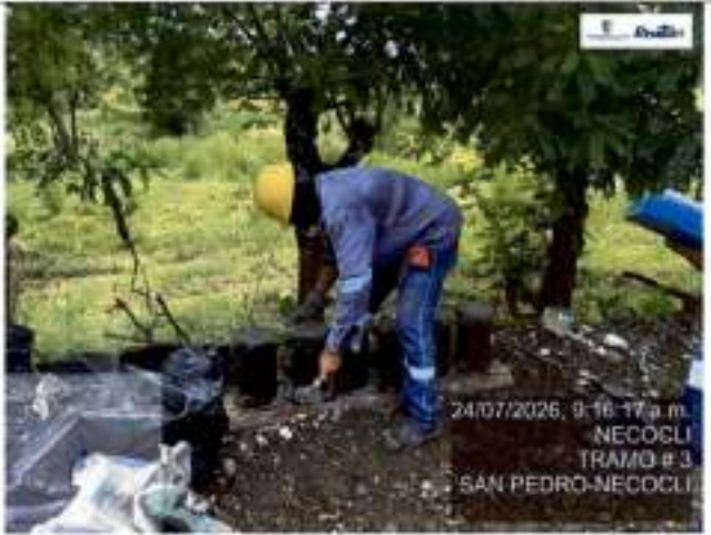
Toma de cilindros de concreto
