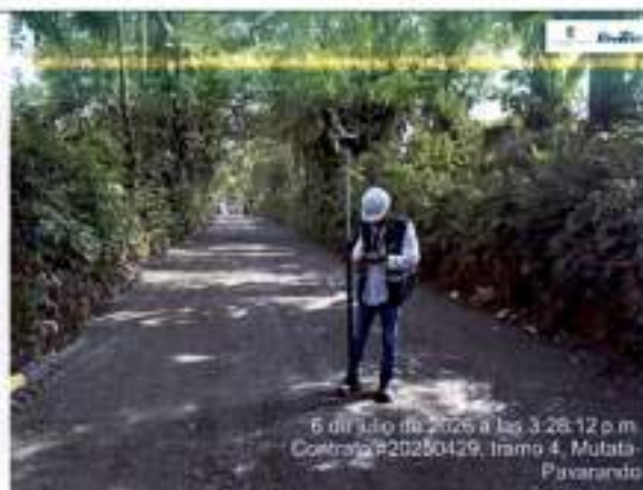
FIGURA 2 VERIFICACIÓN Y VALIDACIÓN DE BASE GRANULAR
