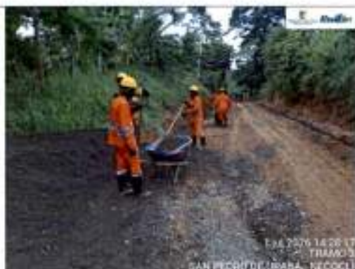
Verificación de controles en construcción de filtros
