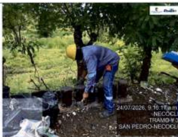
Toma de cilindros de concreto
