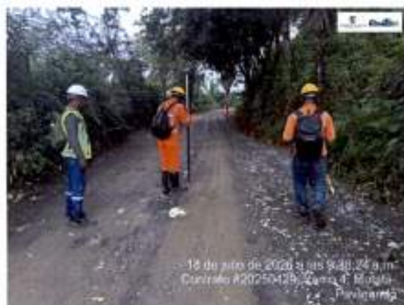
FIGURA 6 REPLANTEOS DE EJE VIAL TRAMO 4.
