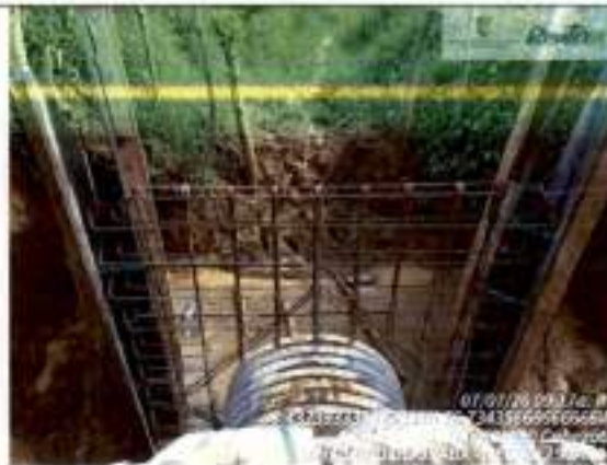
Instalación de acero O.T. K3+690
