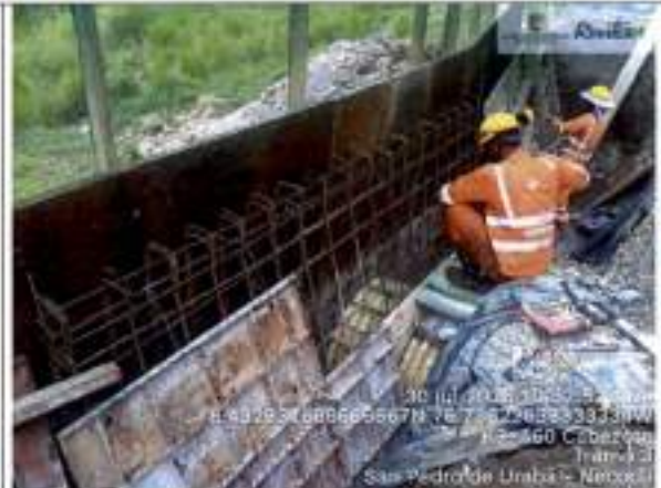
Instalación de acero O.T. K3+460
