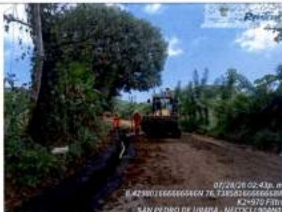
Construcción de filtros K2+970
