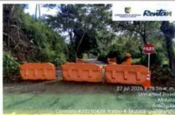
Implementación PMT para construcción de filtros
