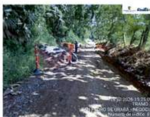
Implementación PMT en instalación de filtros
