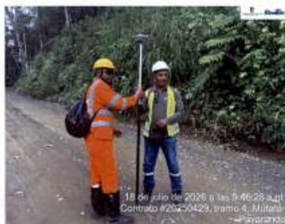
FIGURA 6 REPLANTEOS DE EJE VIAL TRAMO 4.
