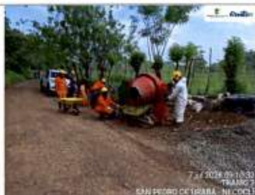
Verificación de controles en vaciado de encofe y descole
