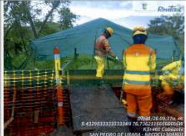
Fundida de muro O.T. K3+460
