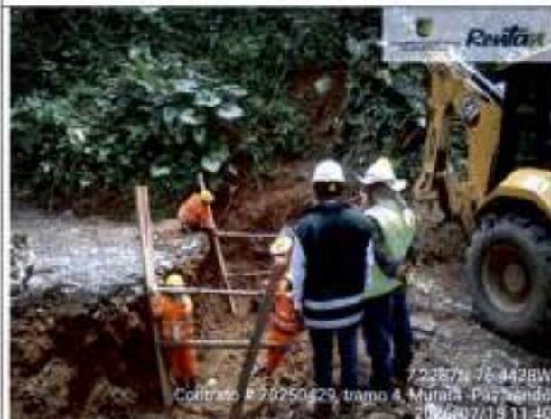
Construcción de filtros K1+850
