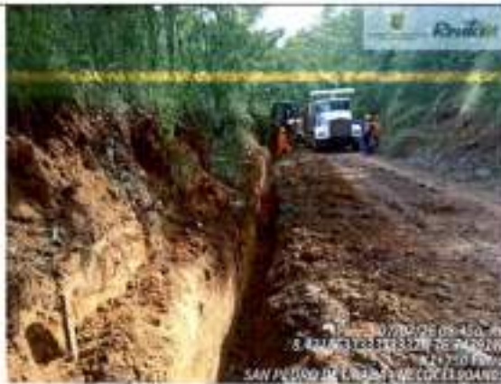
Construcción de filtro. K1+750
