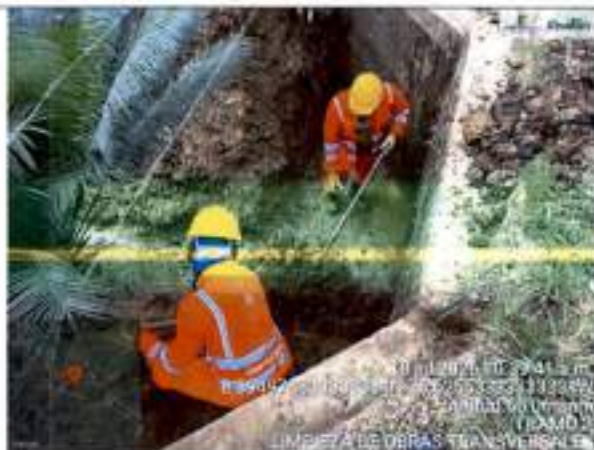
Limpieza de alcantarilla K17+510
