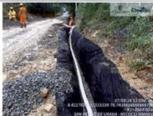
Construcción de filtros K1+850
