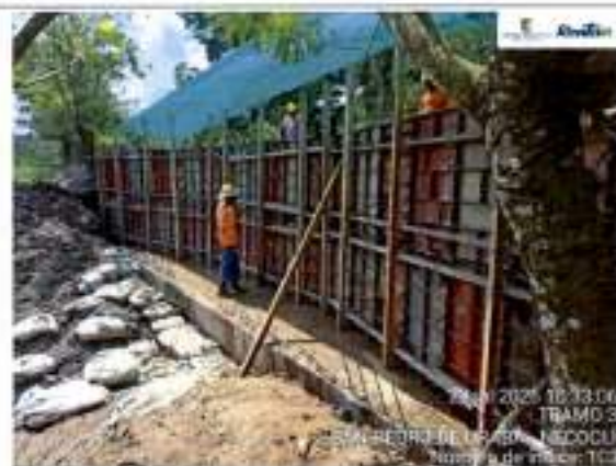
Instalación de formaletas O.T. K3+460
