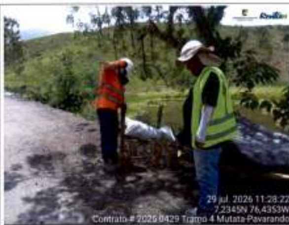
Instalación de acero O.T. K3+460
