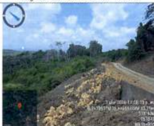
Fotografía No.11 Rellenos en vía K15+800
