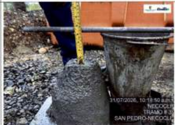
Slump concreto de muro O.T. K3+460
