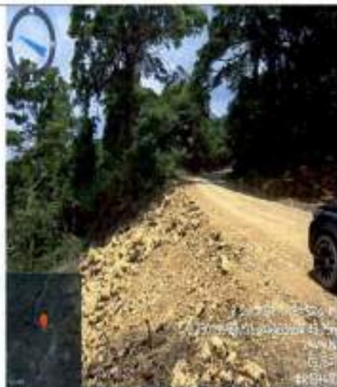
Fotografía No.7 Rellenos en vía K18+400
