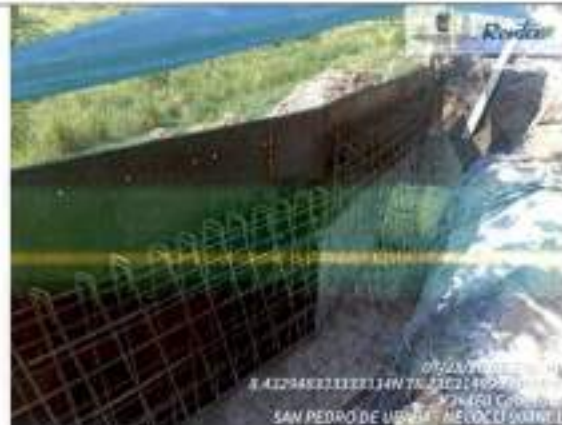
Instalación: acero y formaletas O.T. K3+460
