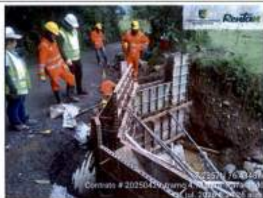
Excavación para instalación tubería O.T. K18+570
