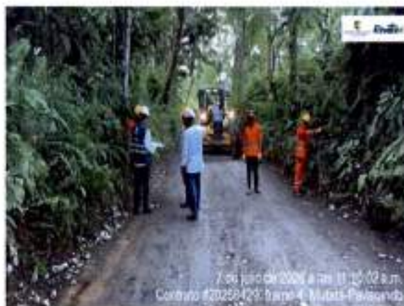
FIGURA 1 LIBERACION SUB RASANTE
