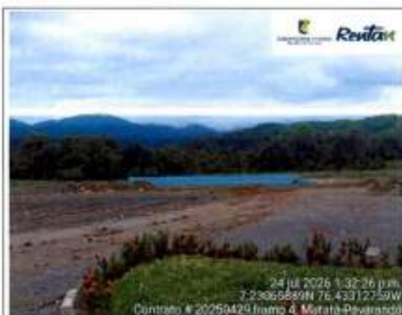
Zona por compactar
