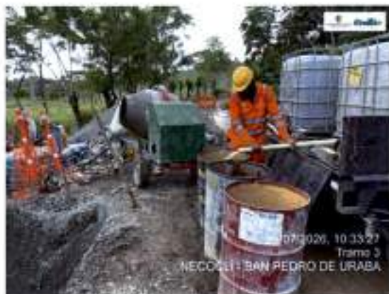
Suministro de agua (aljibe) para actividades constructivas
