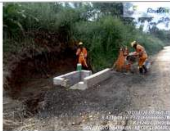
Compactación O.T. K3+240
