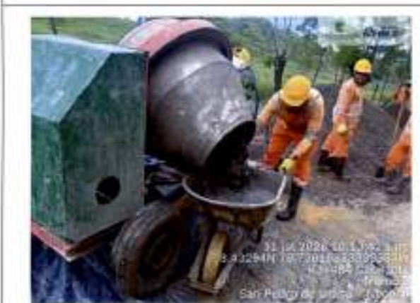
Fundida de muro O.T. K3+460
