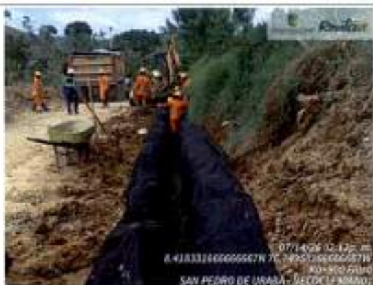
Construcción de filtros K0+900
