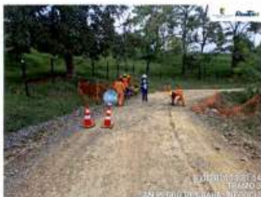
Implementación PMT en toma de densidades de compactación
