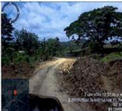
Fotografía No.17 rellenos en vía K13+900
