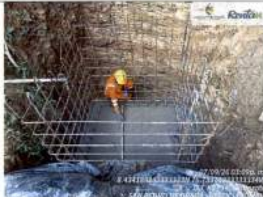
Fundida losa de fondo O.T. K3+940
