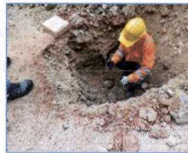
APIQUE REALIZADO POR RETROEXCAVADORA DE LLANTAS
