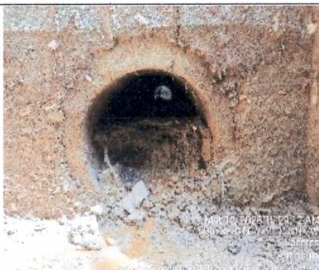
Limpieza de alcantarillas
