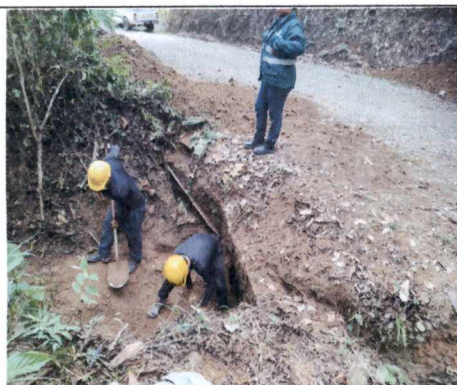
Limpieza de alcantarillas
