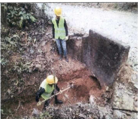
Limpieza de alcantarillas
