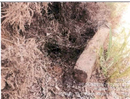
Alcantarilla colmatada
