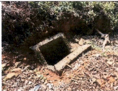
Limpieza de alcantarilla
