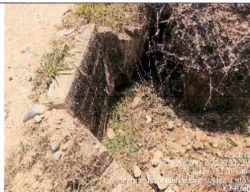
Limpieza de alcantarilla
