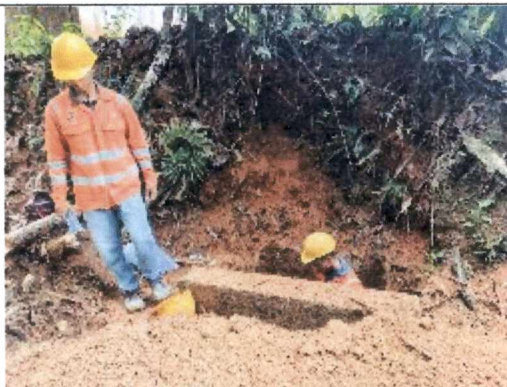
Limpieza de alcantarilla
