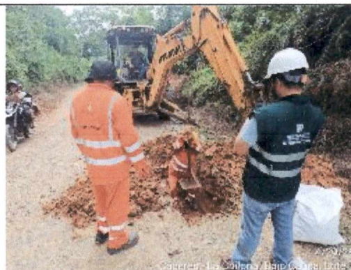
Toma de apiques K21
