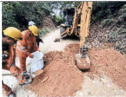
Toma de apique K19
