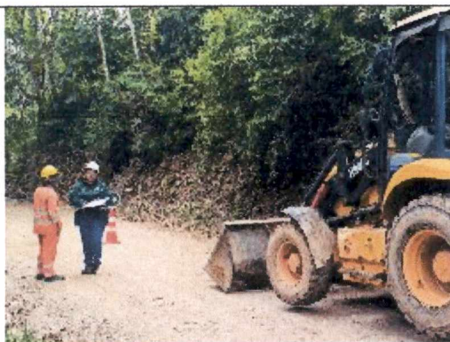
Toma de apiques
