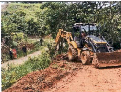
Adecuación campamento K23
