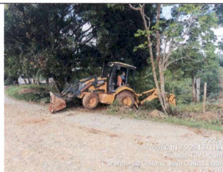
Limpieza de descole
