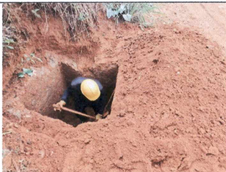
Limpieza de alcantarilla
