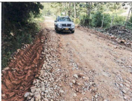
Prueba a motoniveladora
