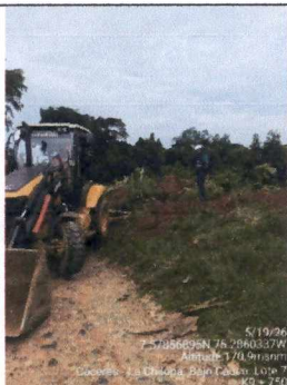
Adecuación campamento K23
