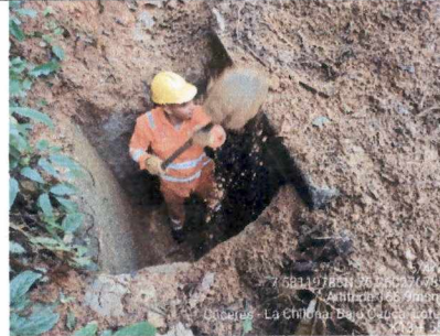
Limpieza de alcantarilla
