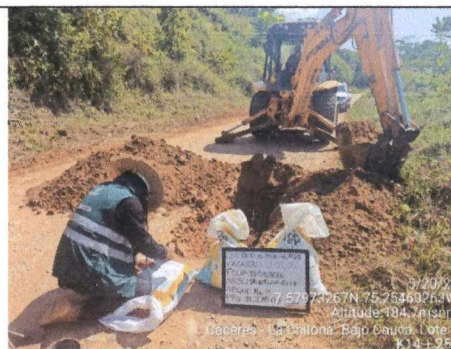
Toma de apique
