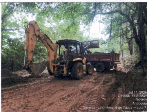
Foto 7. Cargue de material de filtro.
