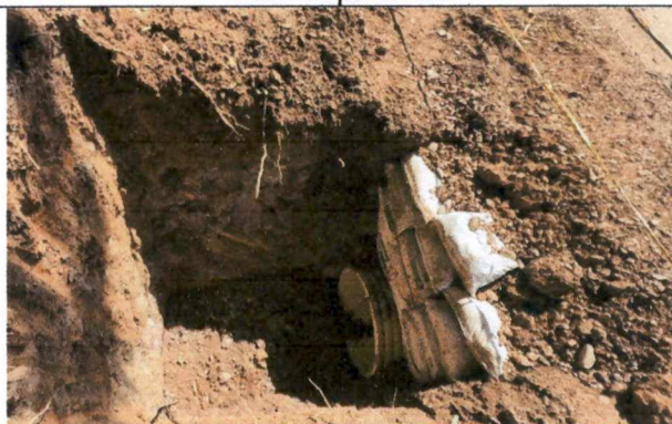
Foto 18. Instalación de tubería para alcantarilla.
