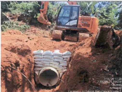
Foto 9. Instalación primera alcantarilla en el tramo de prueba.
