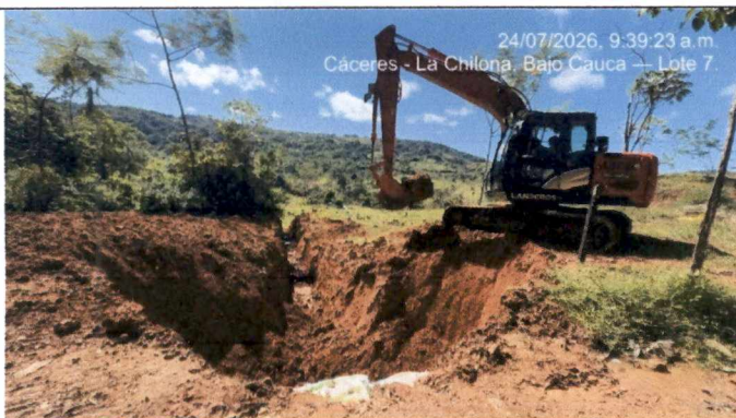
Foto 17. Construcción de alcantarilla.
