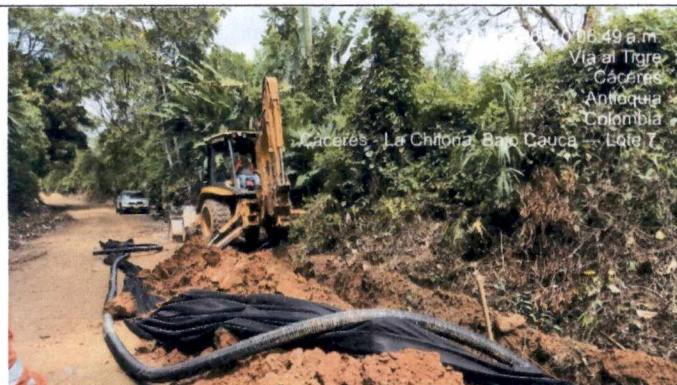
Foto 21. Excavación para filtro.
