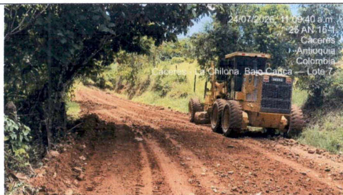
Foto 23. Conformación de vía por medio de motoniveladora.
