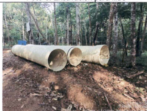
Foto 8. Tubería par alcantarillas.
