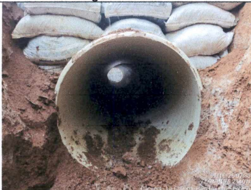
Foto 9. Instalación primera alcantarilla en el tramo de prueba.
