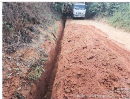
Foto 6. Excavación para filtro
