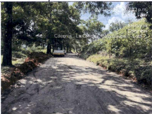
Foto 13. Conformación y nivelación de vía.
