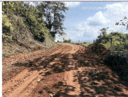
Foto 14. Conformación de vía.
