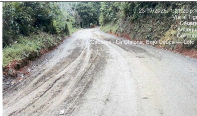
Foto 22. Nivelación de vía con afirmado.
