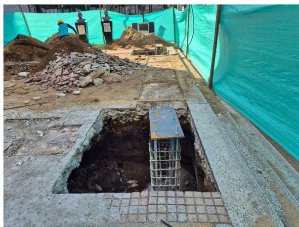
FOTOGRAFÍA 64. Anclaje de platina 300*450mm de 5/8"
