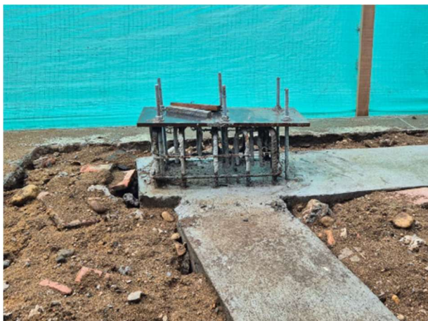
FOTOGRAFÍA 61. Anclaje de platina 300*450mm de 5/8"
