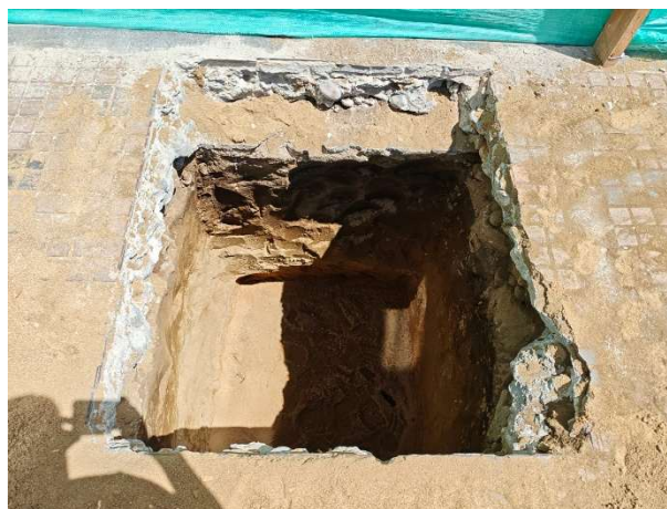
FOTOGRAFÍA 42. Excavación manual
