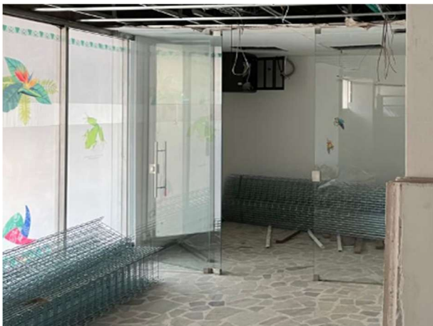
FOTOGRAFÍA 7. Desmonte de vidrio templado
