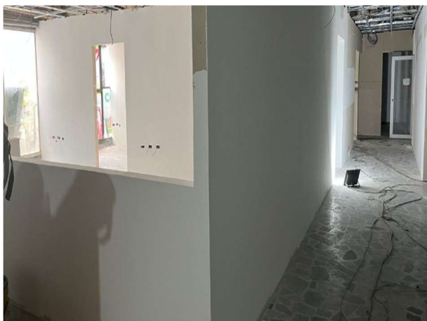
FOTOGRAFÍA 17. Estuco para Muros
