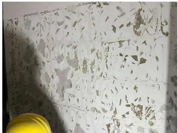
FOTOGRAFÍA 6. Demolición de baldosa cerámica
