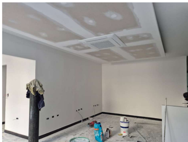
FOTOGRAFÍA 18. Estuco para Muros
