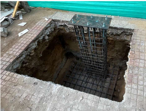
FOTOGRAFÍA 39. Acero de refuerzo resistencia F_y = 420 MPa (60000 PSI)
