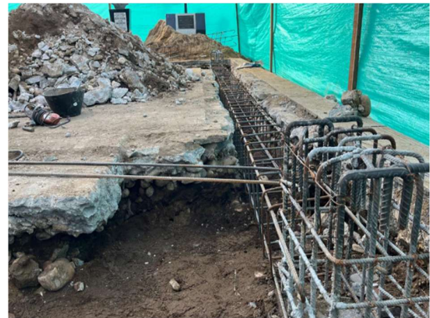
FOTOGRAFÍA 40. Acero de refuerzo resistencia F_y = 420 MPa (60000 PSI)
