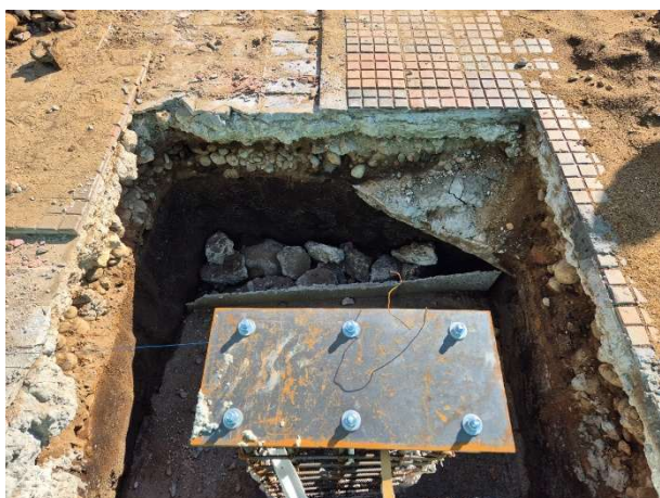
FOTOGRAFÍA 63. Anclaje de platina 300*450mm de 5/8"
