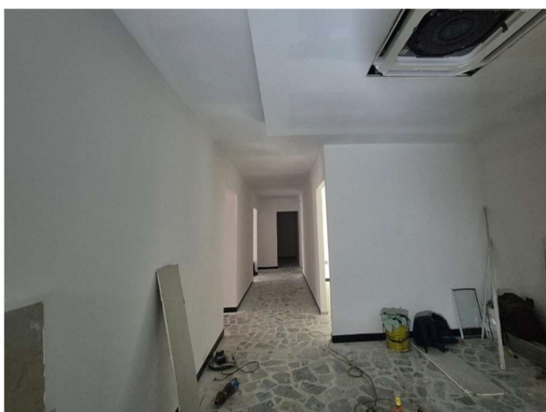
FOTOGRAFÍA 19. Estuco para Muros
