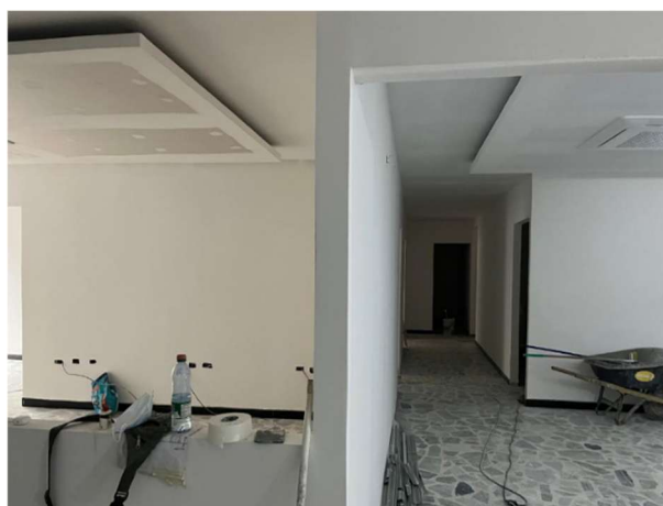
FOTOGRAFÍA 20. Estuco para Muros.
