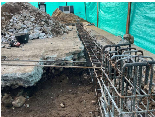
FOTOGRAFÍA 33. Vigas de cimentación en concreto reforzado 4000 PSI
