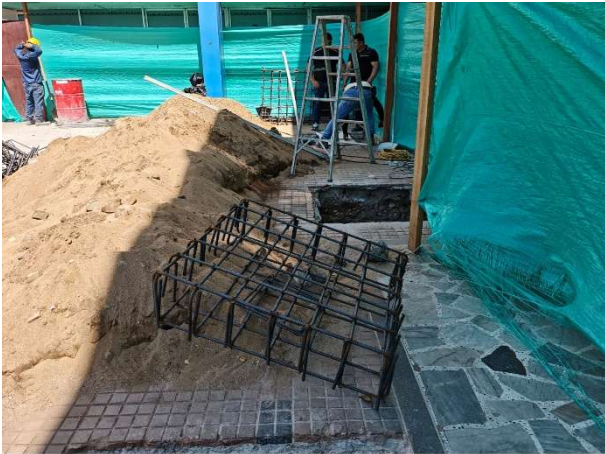
FOTOGRAFÍA 37. Acero de refuerzo resistencia F_y = 420 MPa (60000 PSI)
