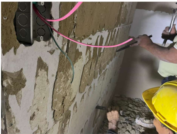
FOTOGRAFÍA 5. Demolición de baldosa cerámica
