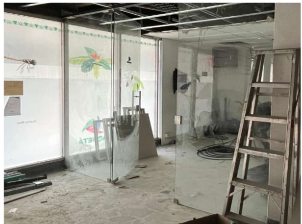
FOTOGRAFÍA 8. Desmonte de vidrio templado
