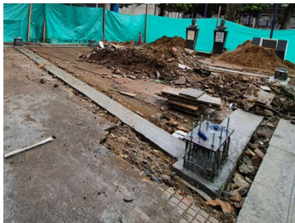
FOTOGRAFÍA 62. Anclaje de platina 300*450mm de 5/8"
