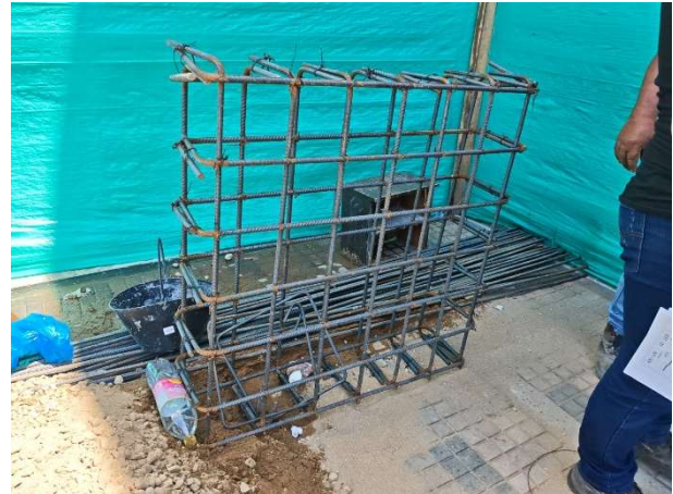
FOTOGRAFÍA 38. Acero de refuerzo resistencia F_y = 420 MPa (60000 PSI)
