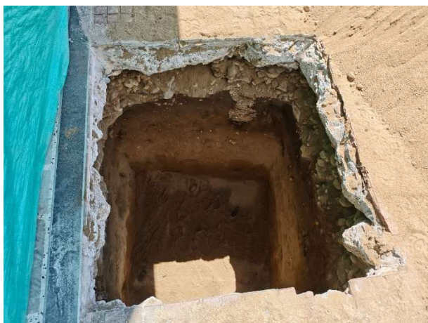
FOTOGRAFÍA 41. Excavación manual
