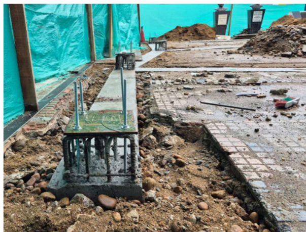
FOTOGRAFÍA 34. Vigas de cimentación en concreto reforzado 4000 PSI
