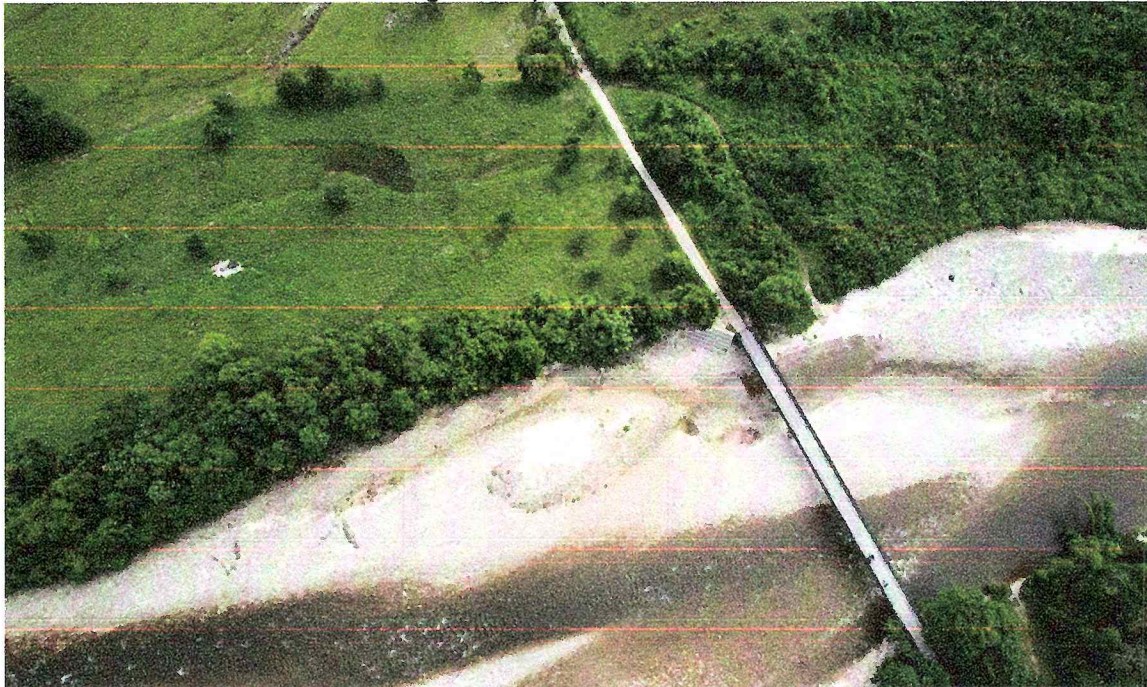
Imagen de puente existente
