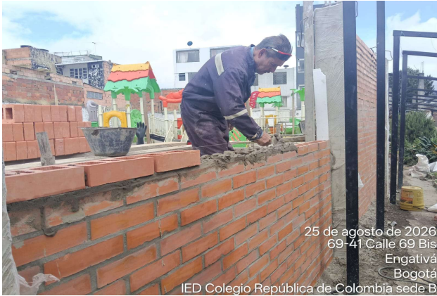
Levantamiento de muro en mampostería
