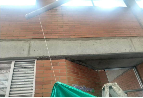
Retiro de la hilada de ladrillo a la vista adosada a la cara inferior de la viga de concreto reforzado para permitir la junta de dilatación
