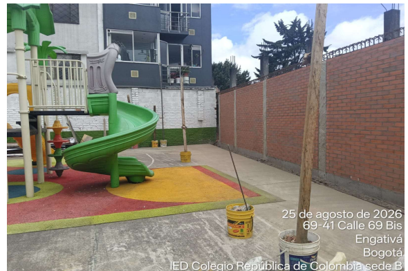
Limpeza de area y retiro de escombros
