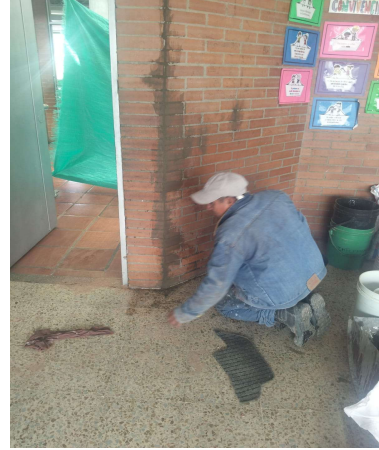
Afinado y reposición de junta de mortero en muros de ladrillo a la vista que presentaban desgaste o faltantes de pega.
