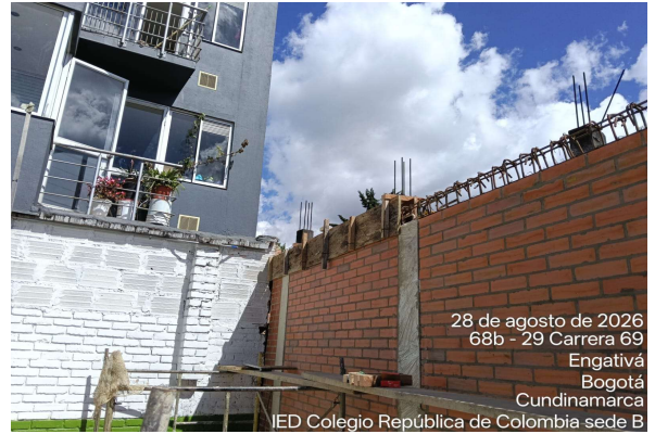
Armado de estructura y formaletas para fundida de viga de amarre
