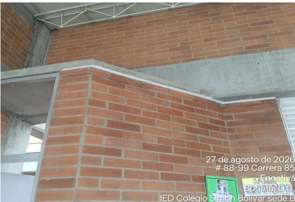
Elaboración de junta de dilatación en el aula 10.
