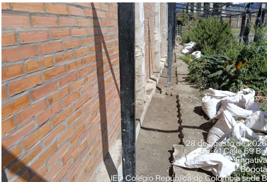
Relleno perimetral al muro
