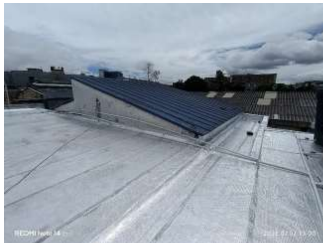
4. Instalación de manto impermeabilizante.
