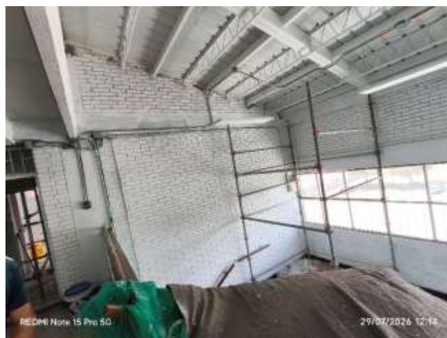
6. S.I. Estructura, cubierta y fondeo muros.
