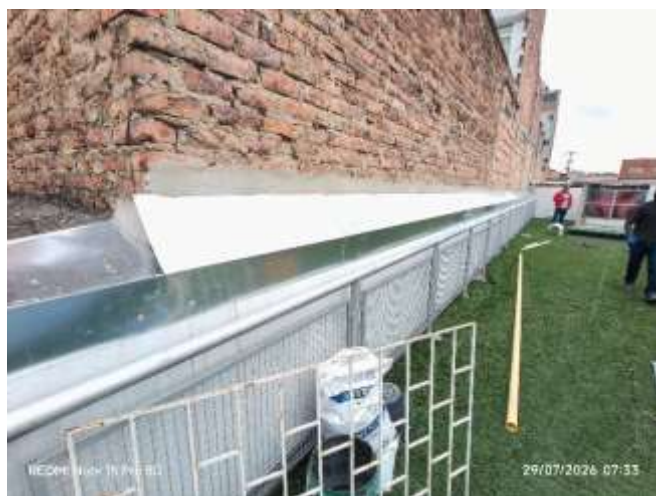
11. □ Instalación Flanche.
