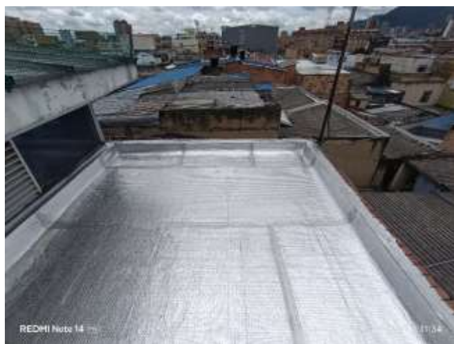
5. Instalación de manto en la terraza.
