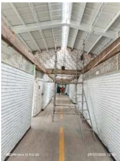
3. S.I. Estructura, cubierta y fondeo muros.
