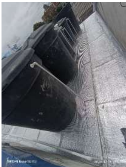
5. Instalación de tanques, tuberías y manto.
