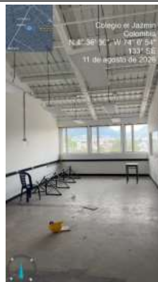
14. □ Pintura acabado muros – guarda escoba.
