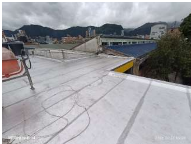
3. Instalación de manto impermeabilizante.
