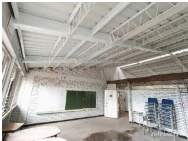
4. S.I. Estructura, cubierta y fondeo muros.
