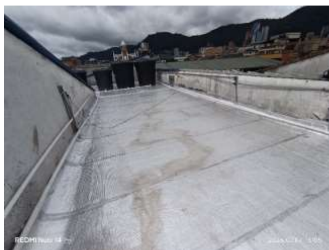
10. □ Instalación de tanques, tuberías y manto.
