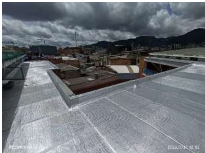
3. Instalación de manto en la terraza.
