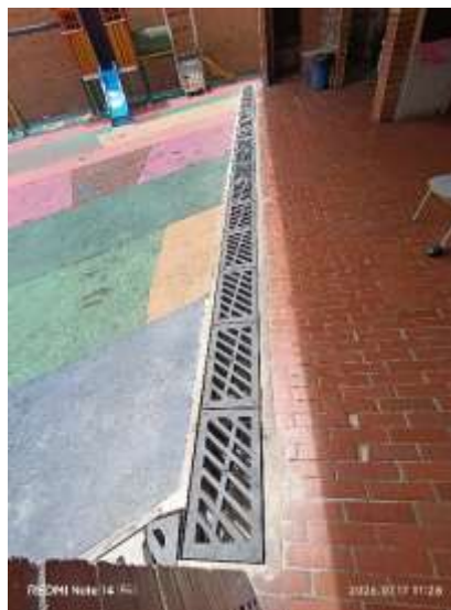
8. Construcción de cárcamo.
