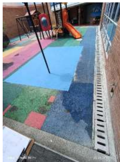
6. Pintura de placa en zona de Jardín
