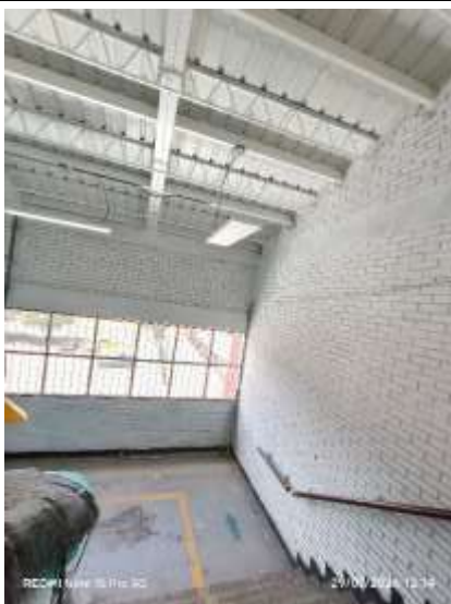
5. S.I. Estructura, cubierta y fondeo muros.
