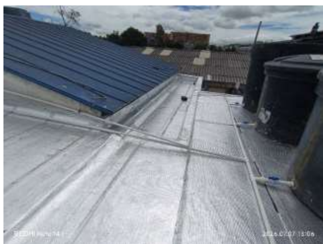
9. □ Instalación de tanques, tuberías y manto.
