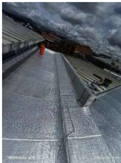
4. Instalación de manto en la terraza.
