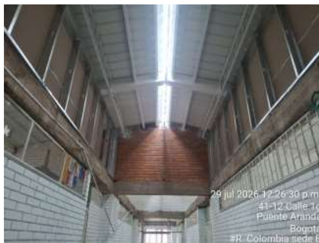
10. □ Drywall muros pasillo 3er piso.
