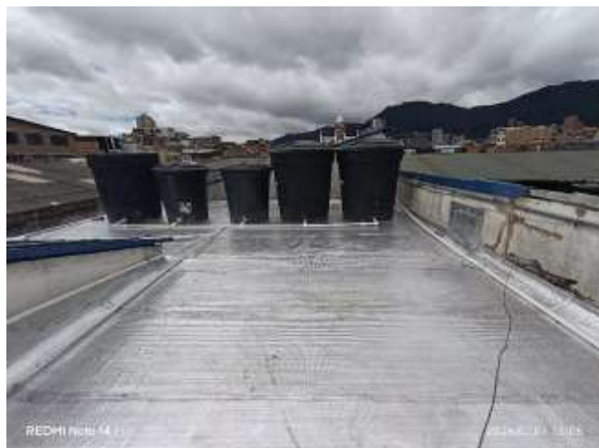
7. □ Instalación de tanques, tuberías y manto.
