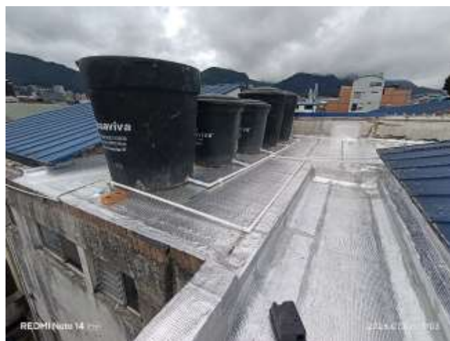
6. Instalación de tanques, tuberías y manto.
