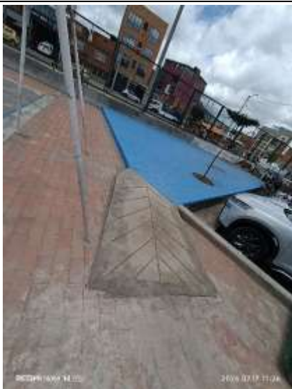
9. Construcción de rampa.
