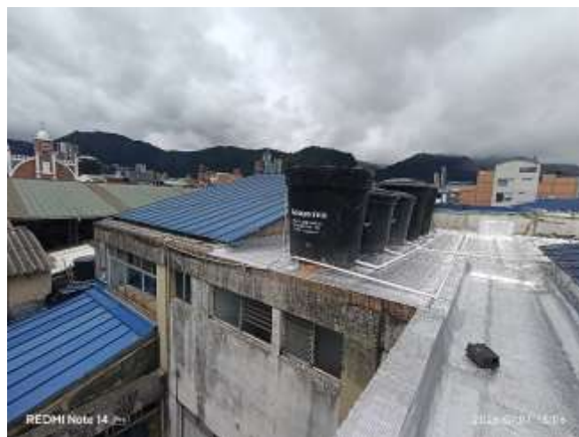
8. □ Instalación de tanques, tuberías y manto.
