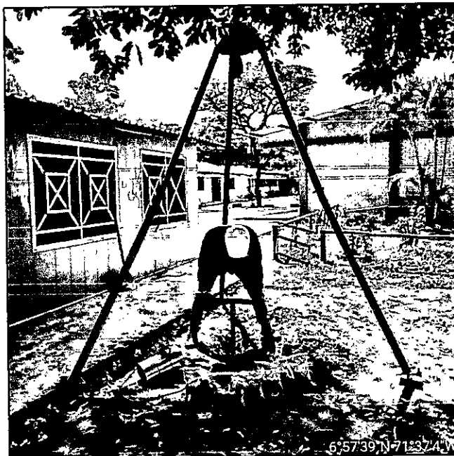
Foto 9. Sondeo exploratorio S-03 – Recuperación de muestra
