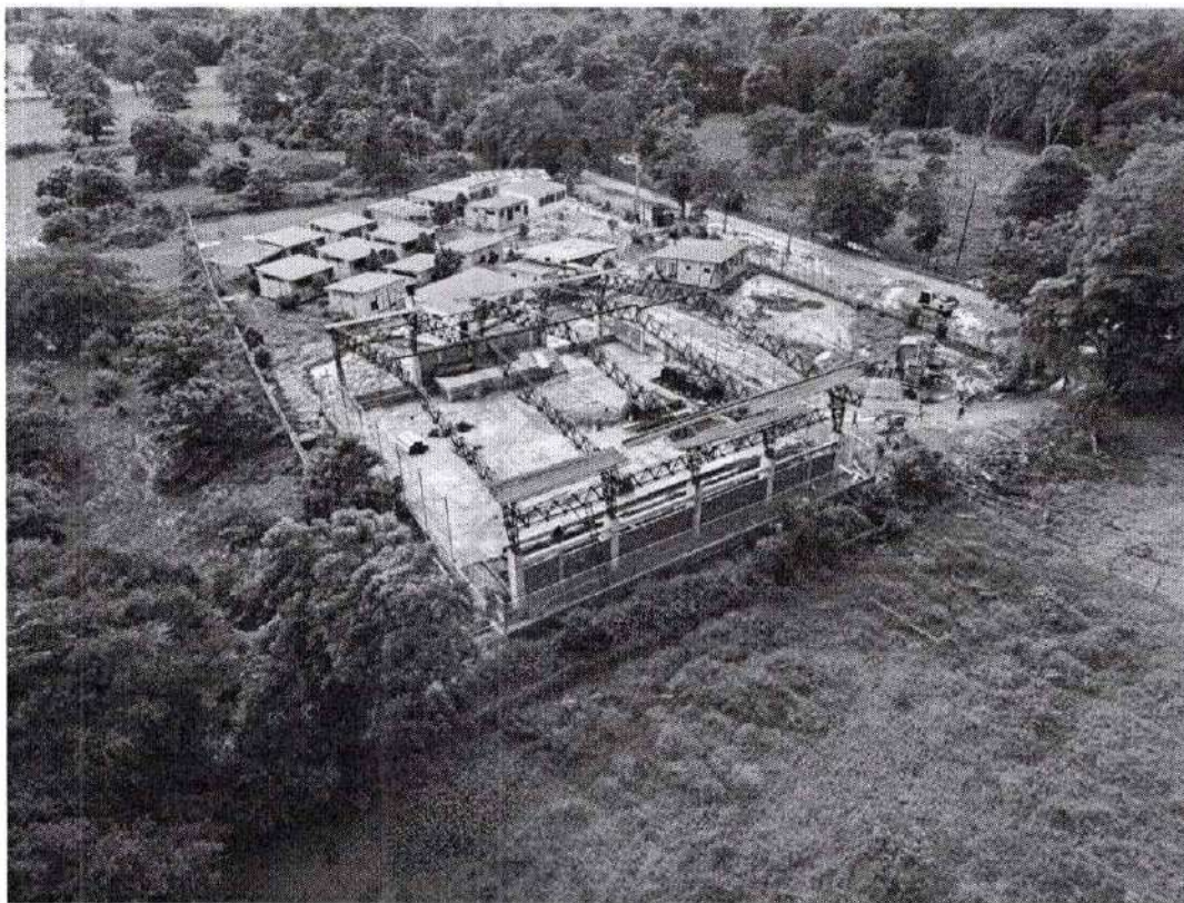
Imagen 2. Fotografía aérea – I.E. José Acevedo y Gómez. Fuente: Documento Técnico del Proyecto.
