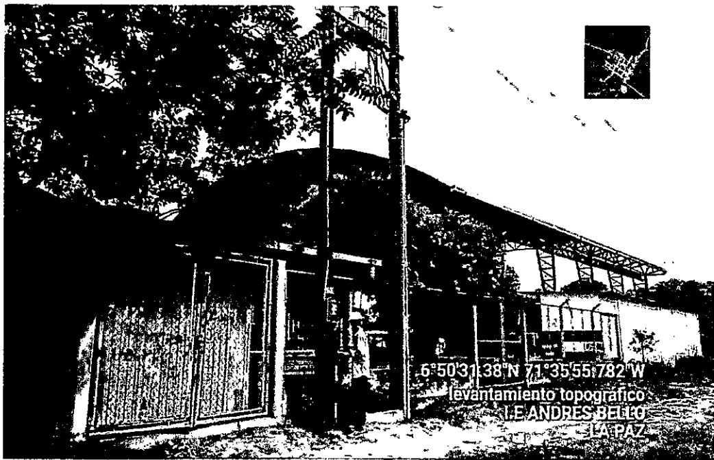
REGISTRO FOTOGRAFICO - LEVANTAMIENTO TOPOGRAFICO
