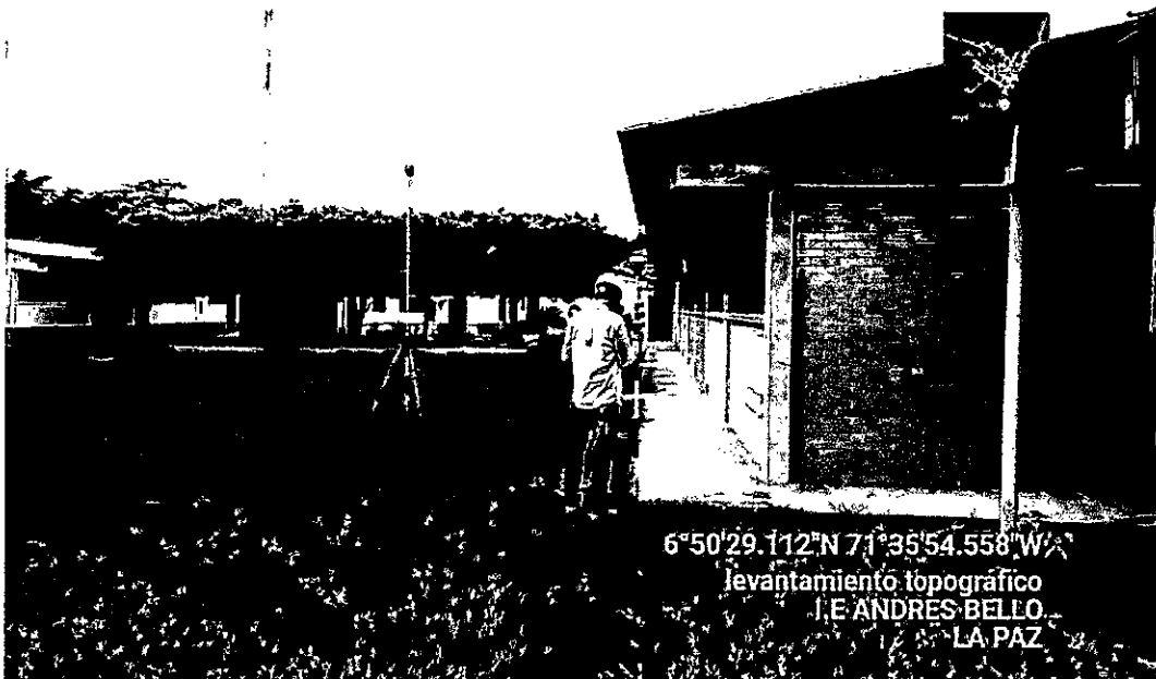
REGISTRO FOTOGRAFICO - LEVANTAMIENTO TOPOGRAFICO
