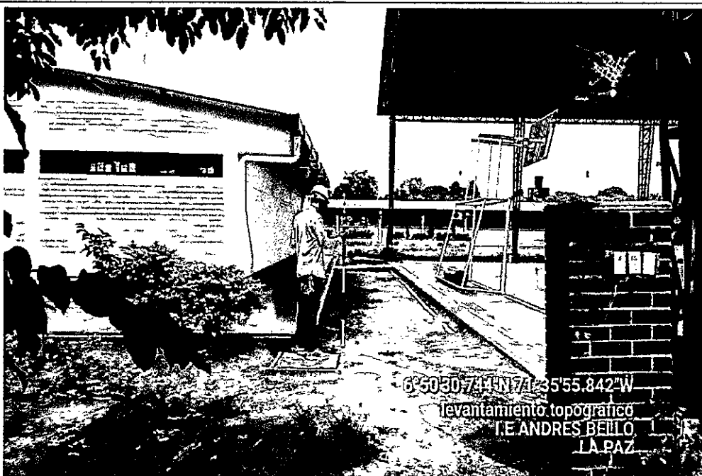
REGISTRO FOTOGRAFICO - LEVANTAMIENTO TOPOGRAFICO
