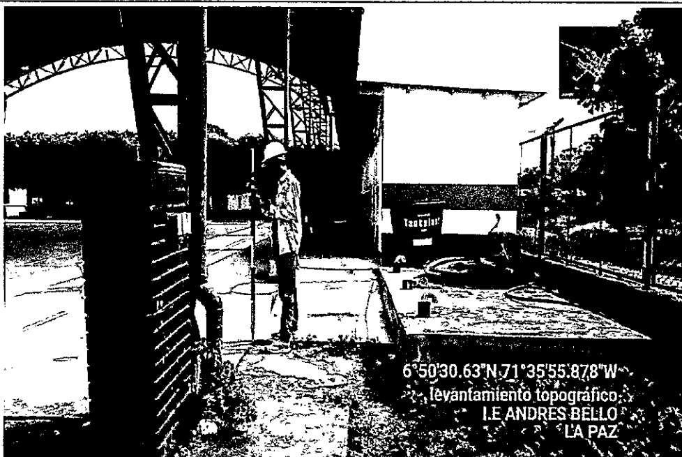
REGISTRO FOTOGRAFICO - LEVANTAMIENTO TOPOGRAFICO
