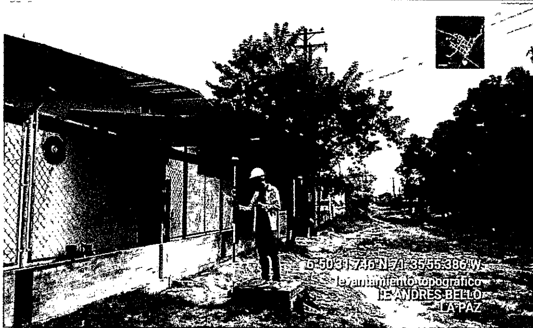
REGISTRO FOTOGRAFICO - LEVANTAMIENTO TOPOGRAFICO
