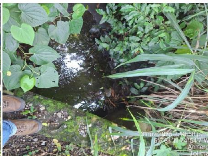
Foto 1. Alcantarilla 36" K0+536 encole - descole
