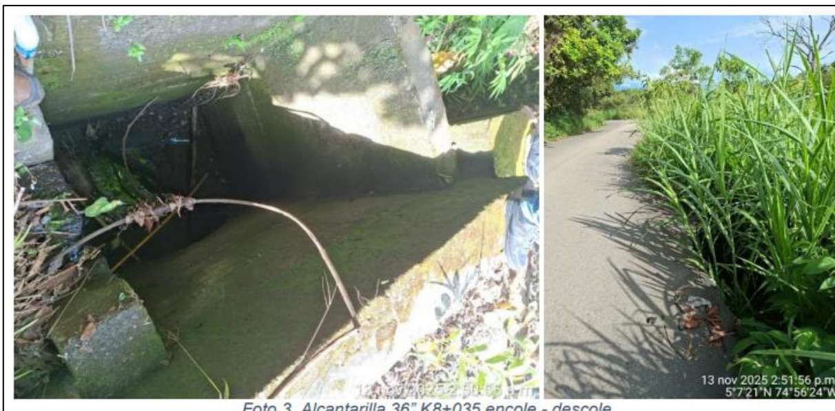
Foto 3. Alcantarilla 36" K8+035 encole - descole
