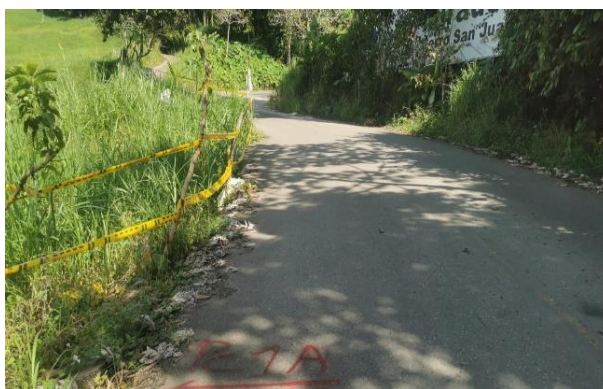
Ilustración 7. Punto crítico 1 A K08+030.
