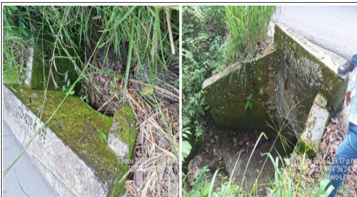
Foto 4. Alcantarilla 36" K8+404 encole - descole
