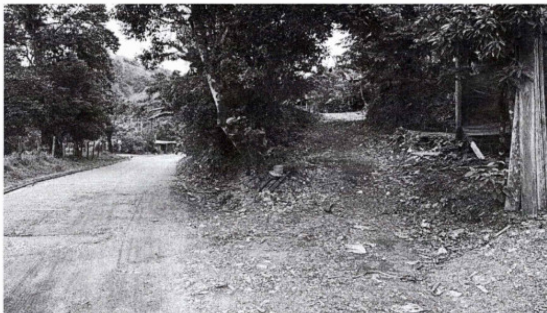
Fotos 11, 12 y 13: Necesidad de ampliación de construcción de red de alcantarillado pluvial.
