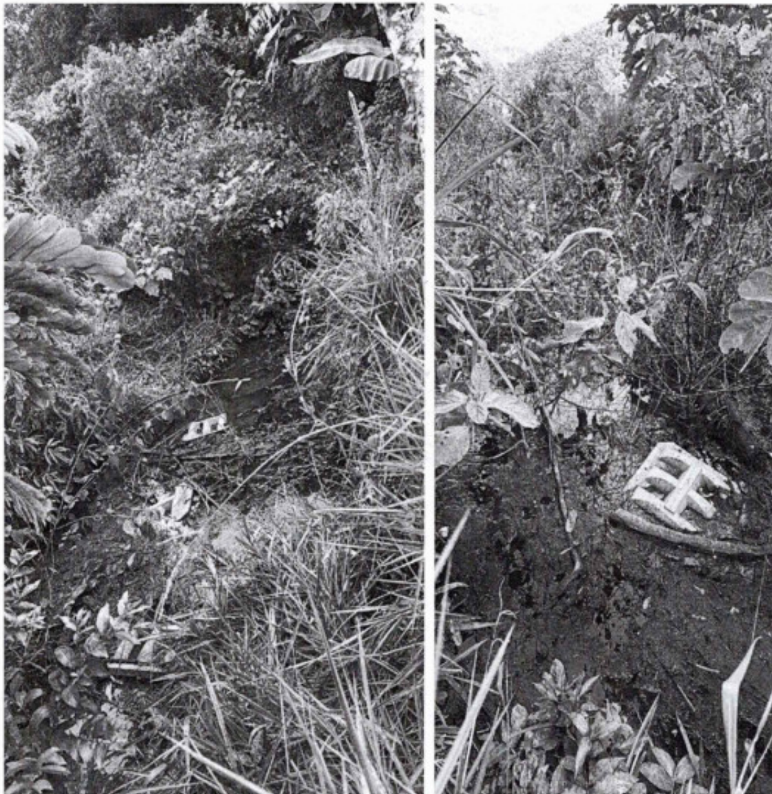
Foto 16: Necesidad de ampliación de construcción de red de alcantarillado sanitario.
