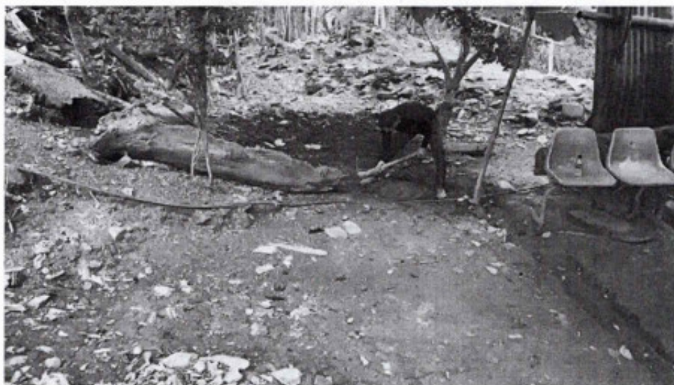
Foto 4: Punto final del tramo a construir.
