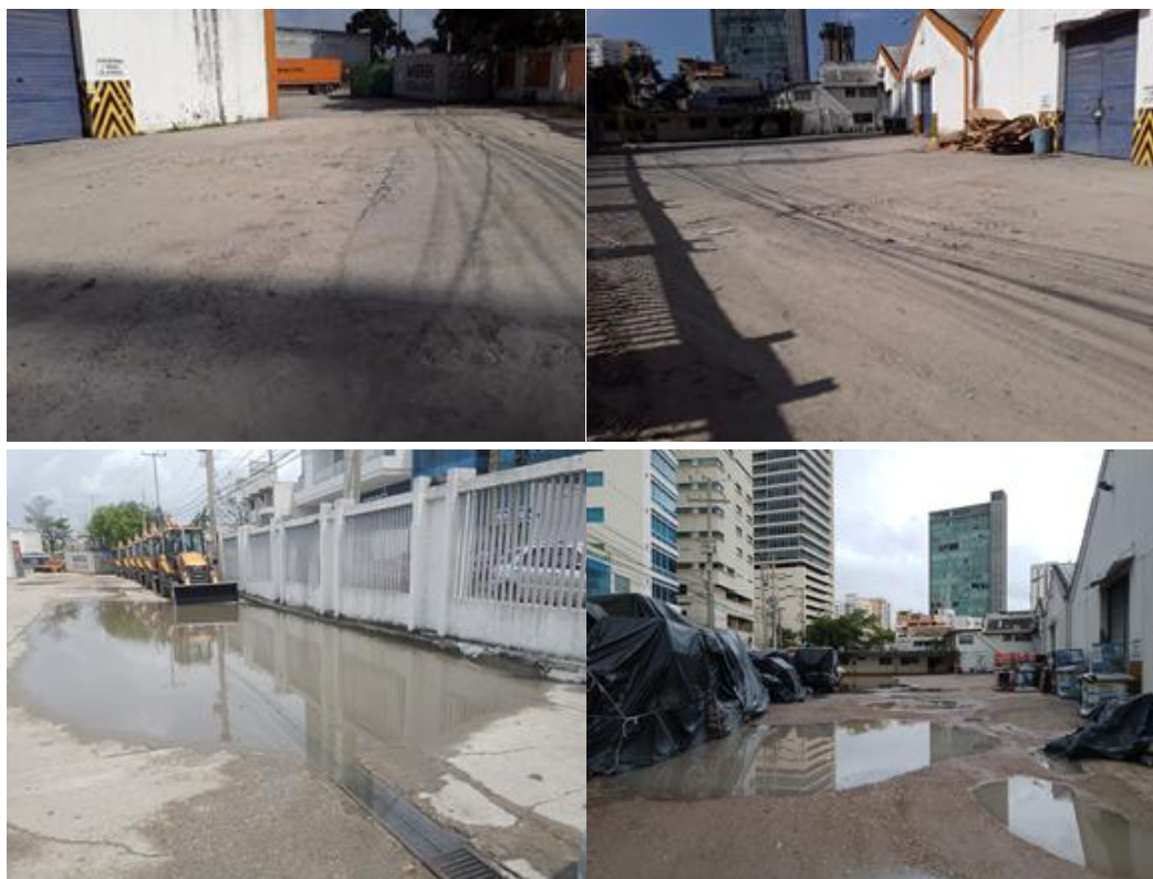
Ilustración No 3. Registro fotográfico área de inversión en infraestructura vial Acceso Bodegas 1-2 y Edificio de Administración Zona Franca Manga
