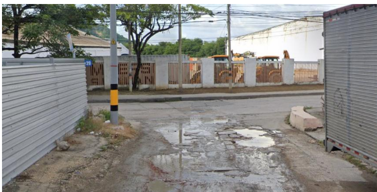
Ilustración No 7. Registro fotográfico Áreas de inversión en infraestructura vial Nueva salida sobre la Cra. 28
